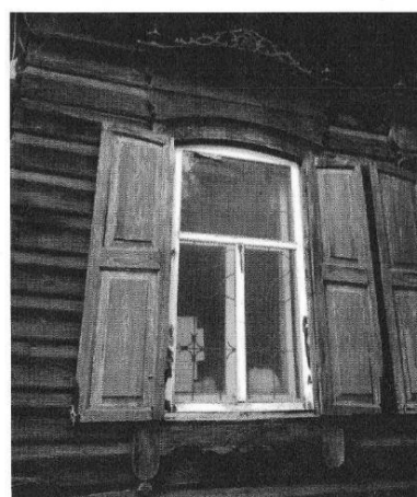
2. Фрагмент юго-восточного фасада. Окно, обшивка.
