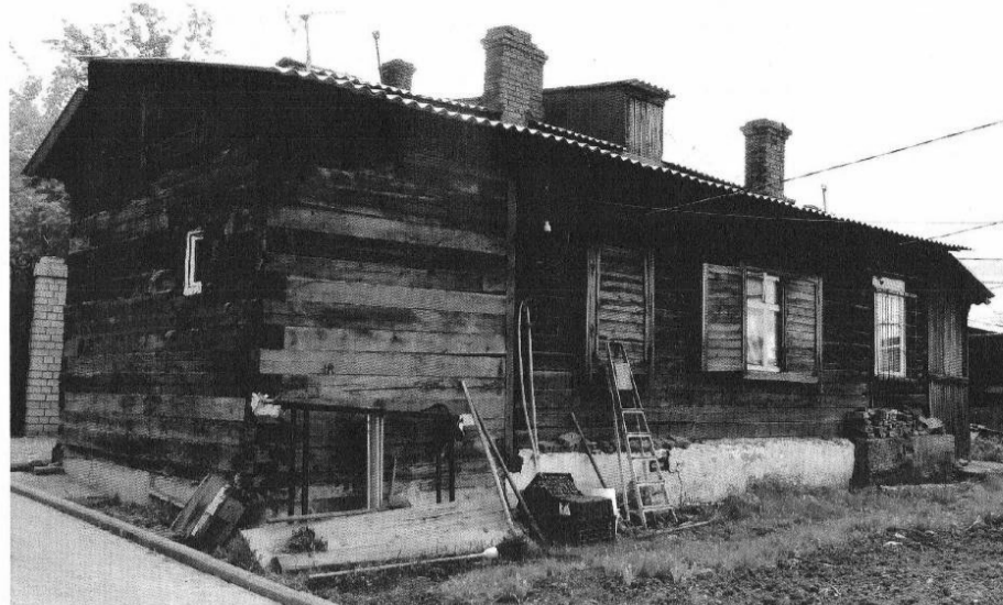
8. Вид на северо-западный фасад. Поздние пристрой.
