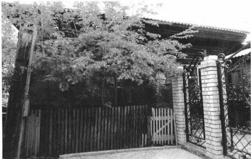
4. Вид на северо-восточный фасад здания со стороны въезда в усадьбу с улицы Коммунаров.
