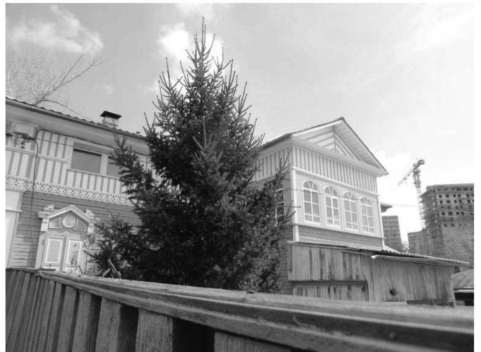
Фото 6 - Юго-западный (дворовой) фасад
