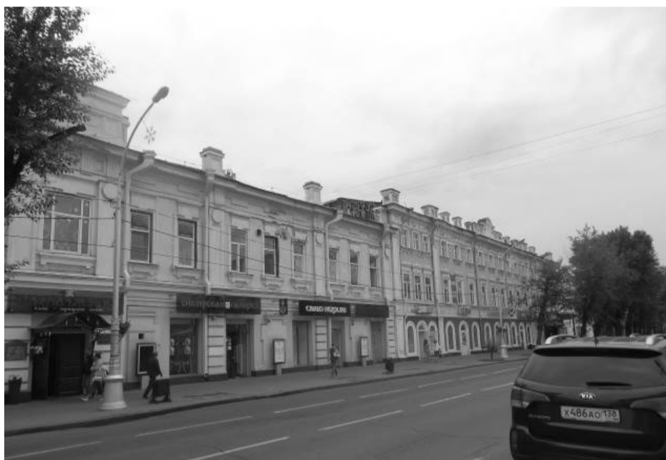
Фото 7 - Общий вид с ул. К. Маркса
