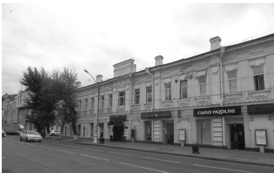
Фото 6 - Общий вид с ул. К. Маркса
