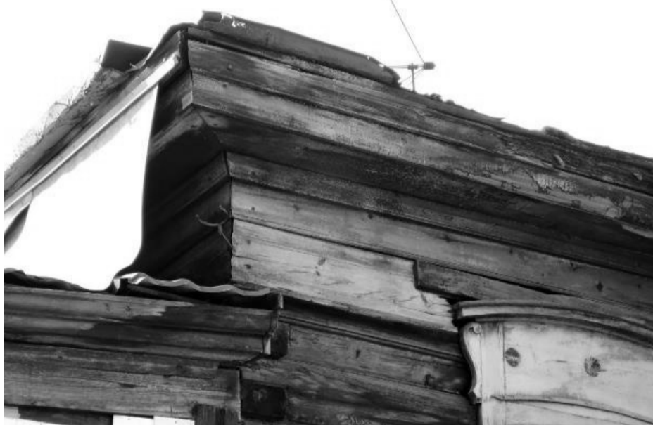
Фото 23. Фрагмент северо-восточного (дворового) фасада. Фриз и карниз основного объёма. Фото 2019 г.
