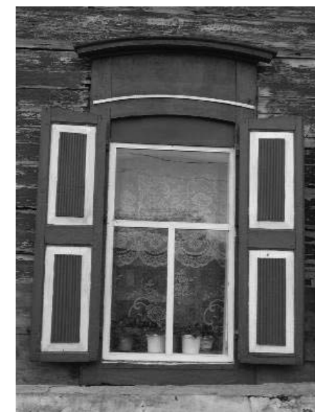
Дата съемки: апрель, 2017 г. Фото 3 - Фрагмент северо-западного (главного) фасада здания. Оконный проем.
