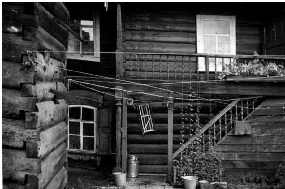
Фото 8. Фрагмент юго-восточного (дворового) фасада. Г-образный дворовый прируб с галереей. Слева – утраченный прируб люфт-клозета. Фото В.Т. Щербина, 1980-е гг. Архив Службы по охране ОКН Иркутской области
