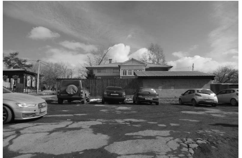
Фото 4 - Вид на усадьбу с ул. Седова (юго-западный фасад)
