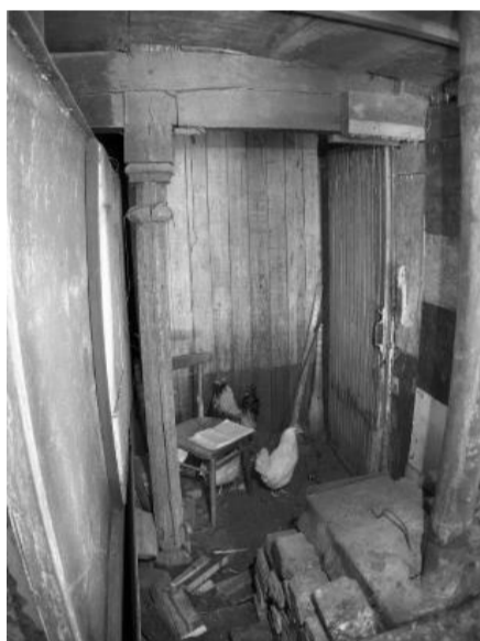
Фото 18. Фрагмент юго-восточного (дворового) фасада. Фигурный столбик галереи, 1 этаж. Фото 2019 г.
