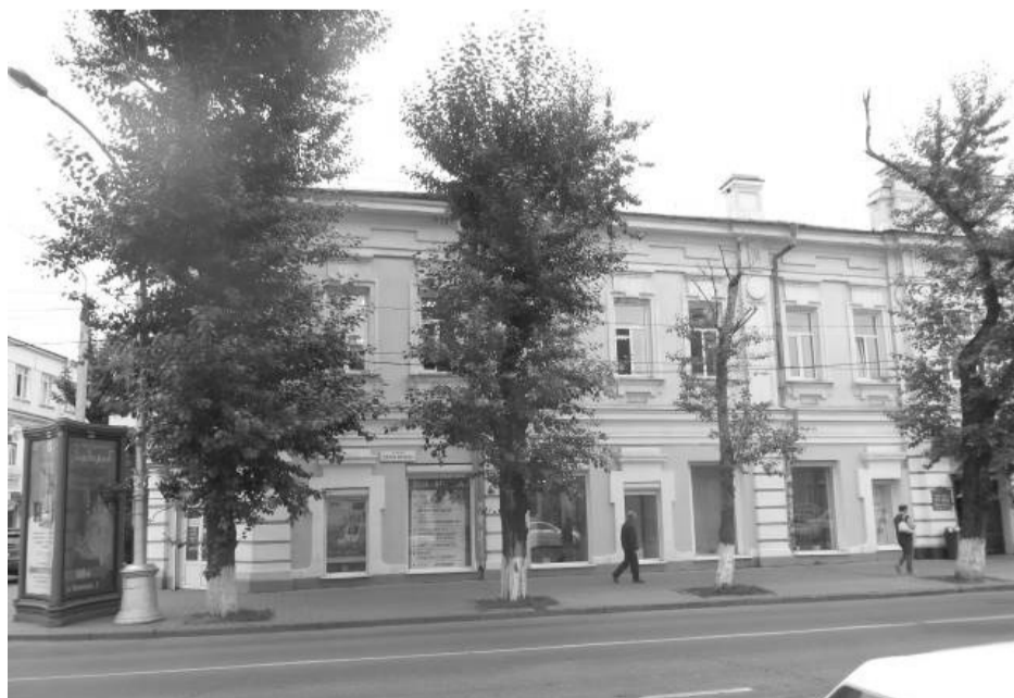
Фото 4 - Общий вид с ул. К. Маркса
