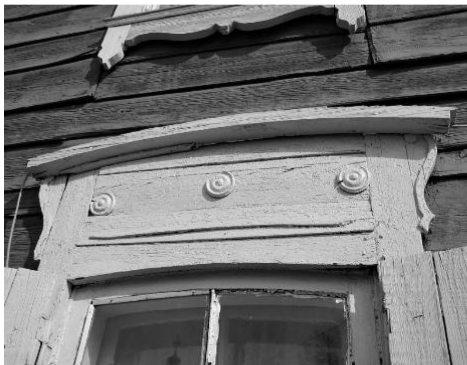
Фото 15. Фрагмент оконного наличника 1-го этажа. Сандрик, лобань. Фото 2019 г.
