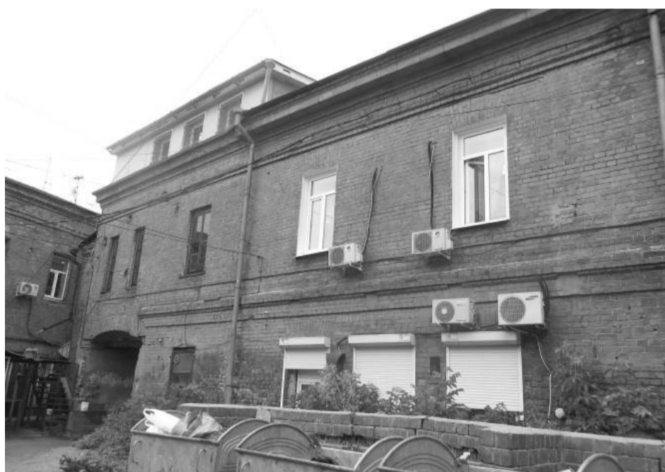
Фото 19 - Вид на забор со двора
