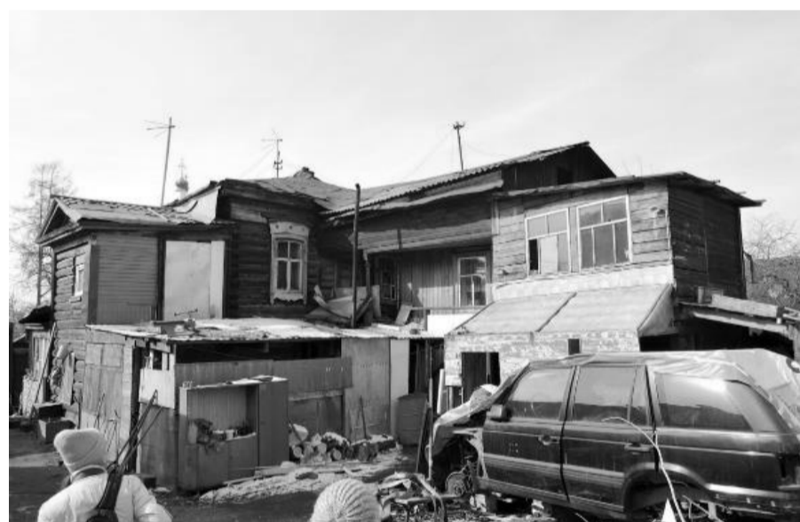
Фото 10. Общий вид с востока. Фото 2019 г.
