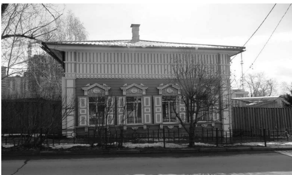
Фото 3 – Главный северо-западный фасад по ул. Кожова
