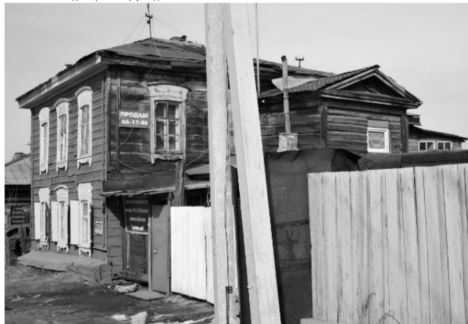
Фото 4. Общий вид здания с юга. Фото 2019 г.
