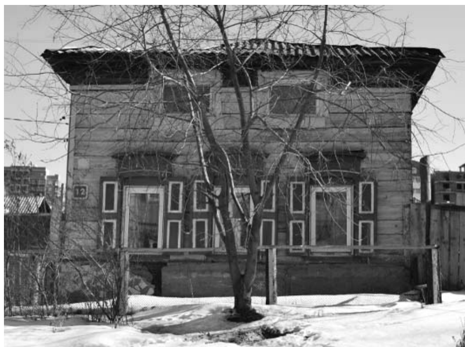
Дата съемки: апрель, 2017 г. Фото 1 - Вид на северо-западный (главный) фасад здания со стороны улицы Красных Мадьяр
