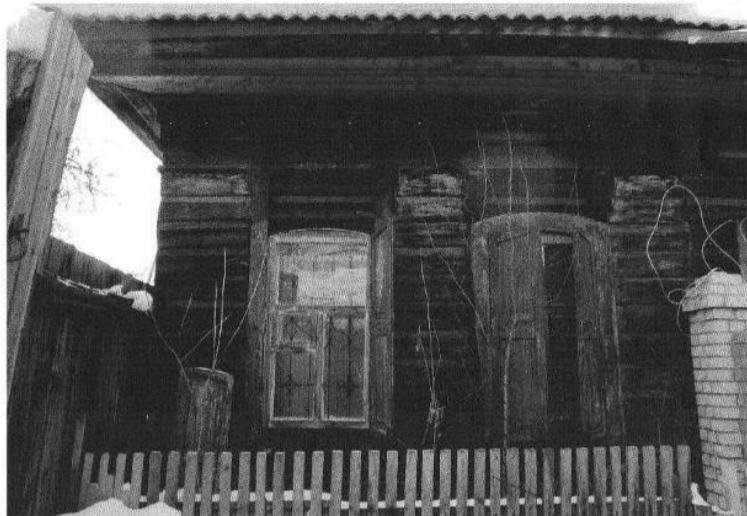
5. Вид на северо-восточный фасад здания со стороны въезда в усадьбу с улицы Коммунаров.
