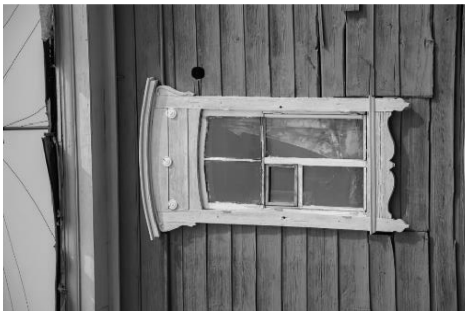
Фото 17. Фрагмент юго-западного (главного) фасада. Центральное окно 2-го этажа, переделанное из балконной двери. Снизу видна зашивка проёма. Фото 2019 г.
