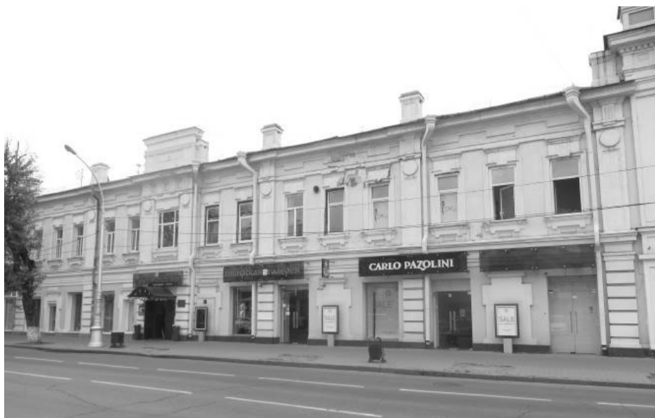
Фото 5 - Общий вид с ул. К. Маркса
