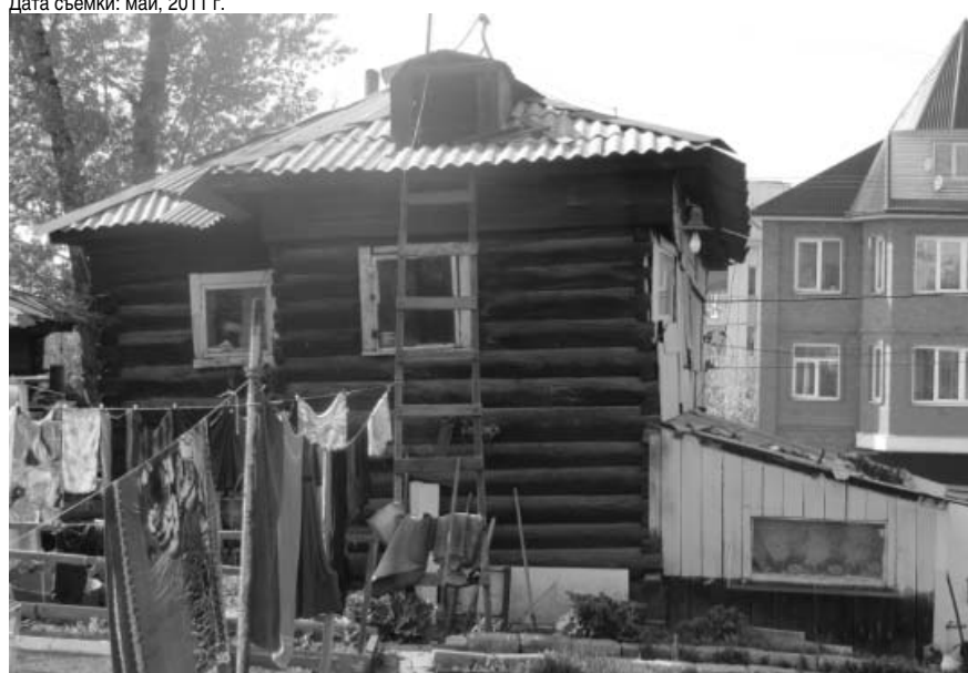
Дата съемки: май, 2017 г. Фото 7 - Вид на юго-восточный фасад здания со стороны двора.
