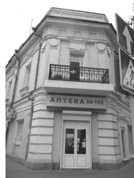
Фото 10 - Скошенный угол здания
