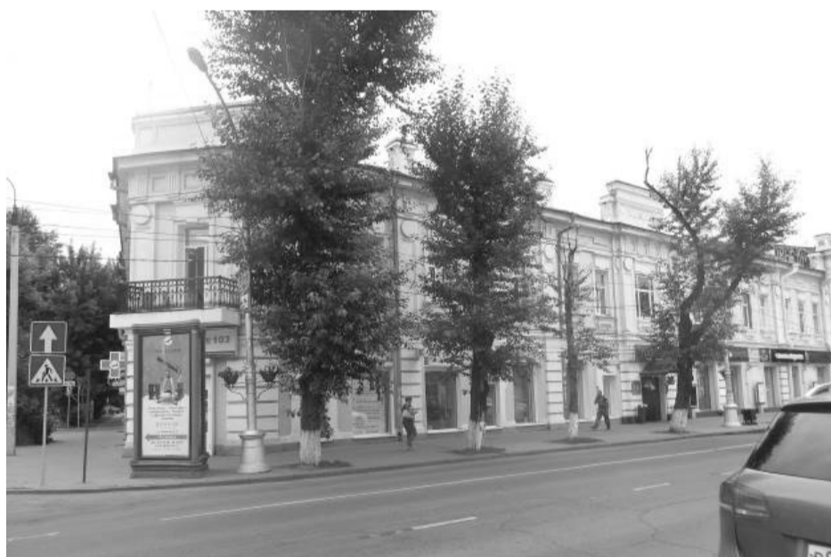
Фото 3 - Общий вид с ул. К. Маркса
