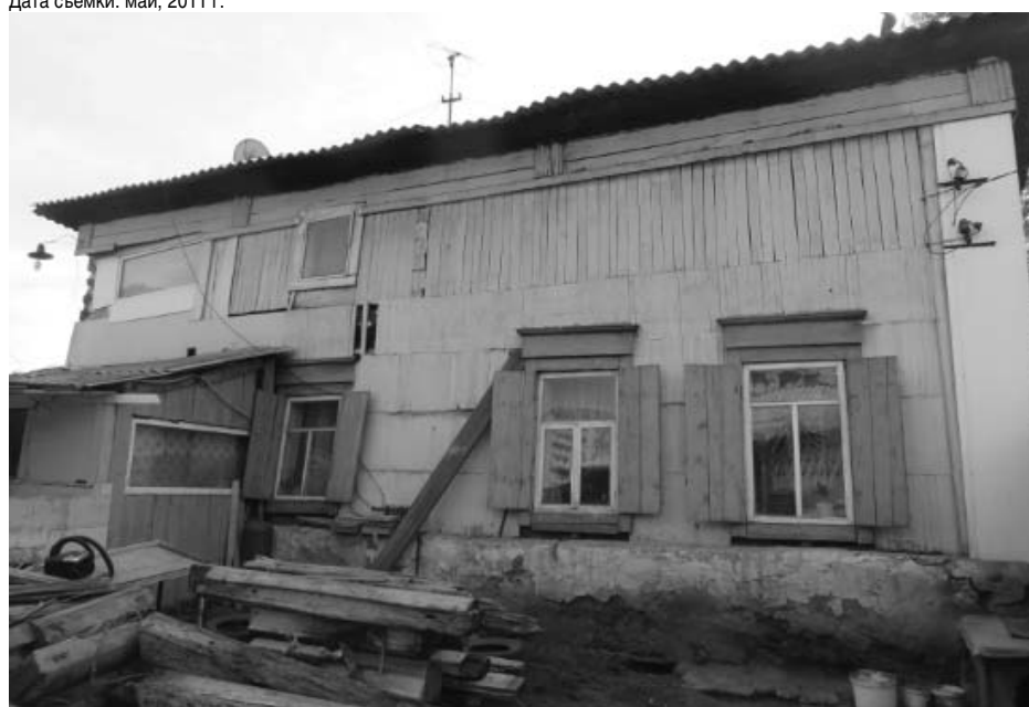
Дата съемки: май, 2017 г. Фото 5 - Вид на северо-восточный и юго-восточный фасады здания со стороны двора.
