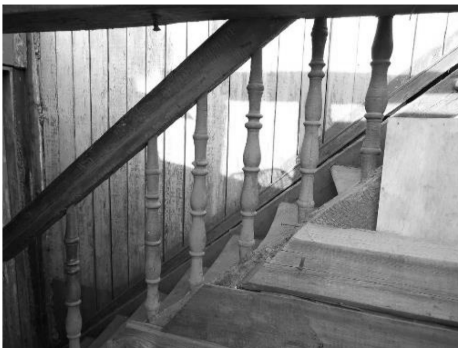
Фото 22. Фрагмент юго-восточного (дворового) фасада. Ограждение наружной лестницы из токарных балясин. Фото 2019 г.
