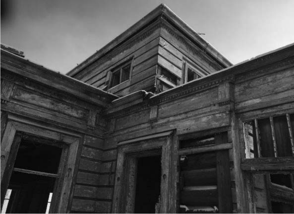
Фото 16 - Фрагмент дворового (юго-западного) фасада. Место примыкания прируба
