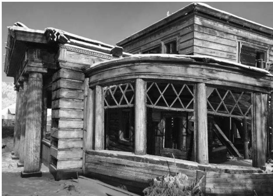
Фото 18 - Фрагмент дворового (юго-западного) фасада. Вид с южной стороны
