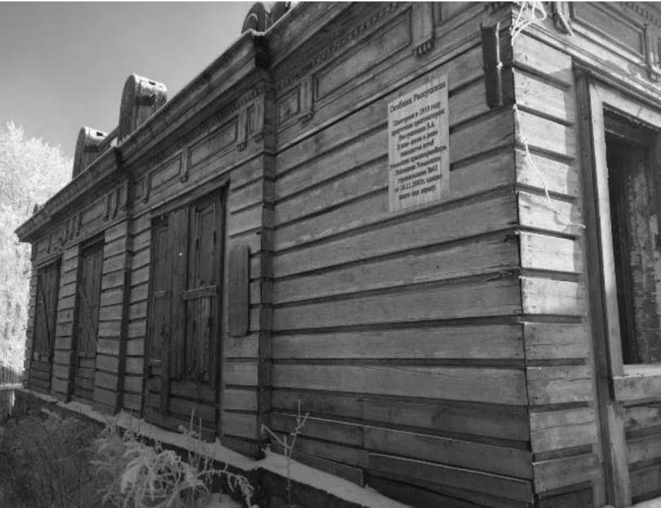
Фото 10 - Фрагмент главного (северо-западного) фасада дома. Вид с запада
