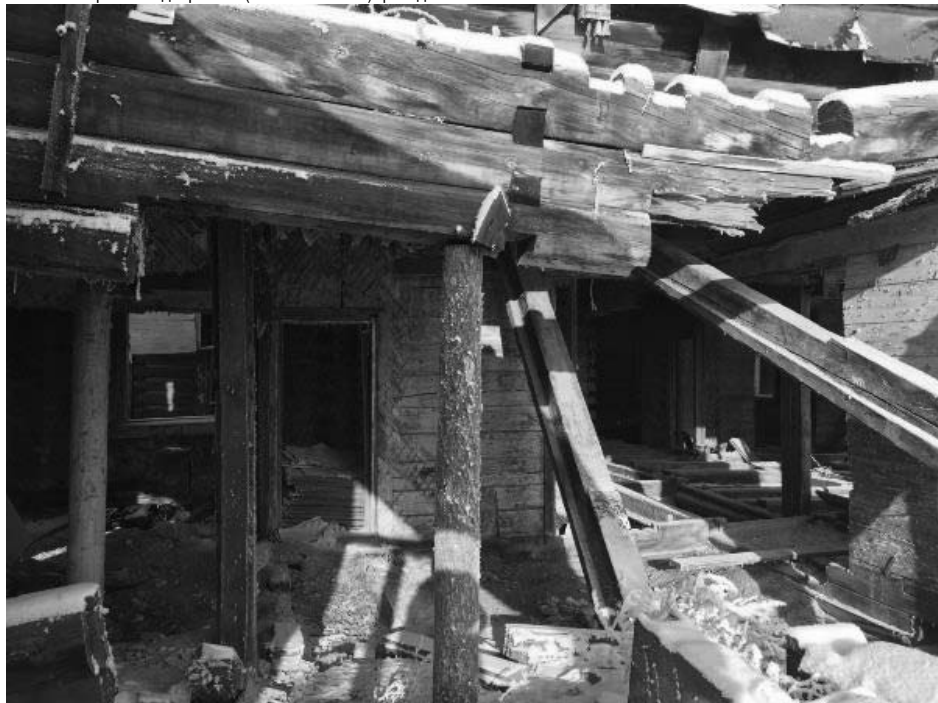
Фото 23 - Фрагмент дворового (юго-восточного) фасада
