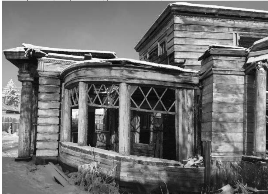
Фото 19 - Фрагмент левого фланга дворового (юго-восточного) фасада
