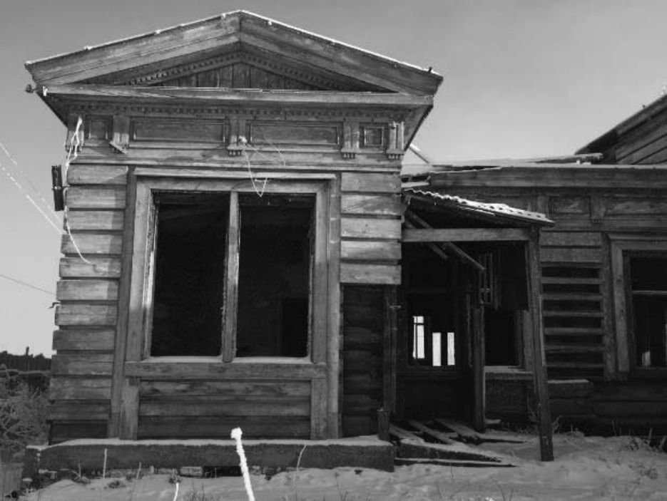
Фото 12 - Фрагмент левого фланга дворового (юго-западного) фасада дома
