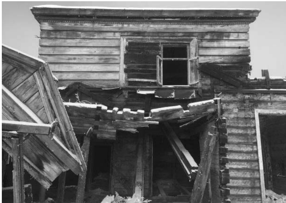
Фото 21 - Фрагмент дворового (юго-восточного) фасада
