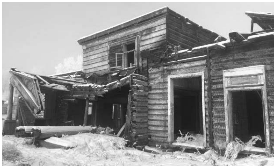
Фото 22 - Фрагмент дворового (юго-восточного) фасада
