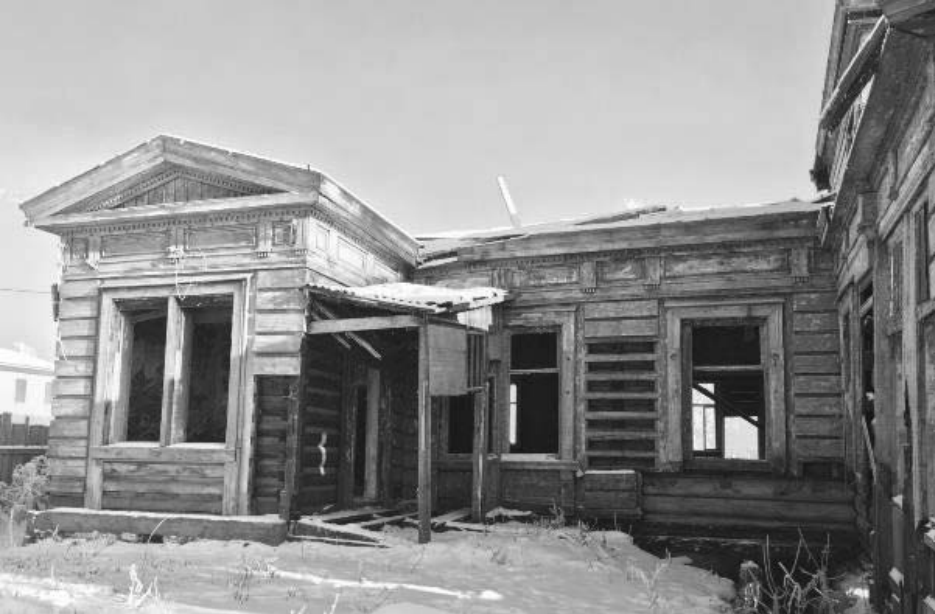
Фото 13 - Фрагмент (левой половины) дворового (юго-западного) фасада дома
