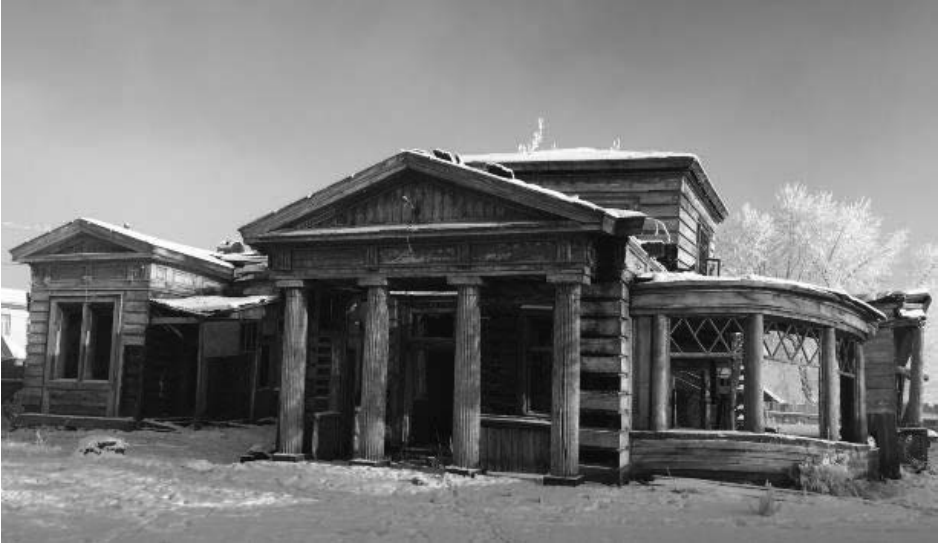
Фото 17 - Дворовой (юго-западный) фасад
