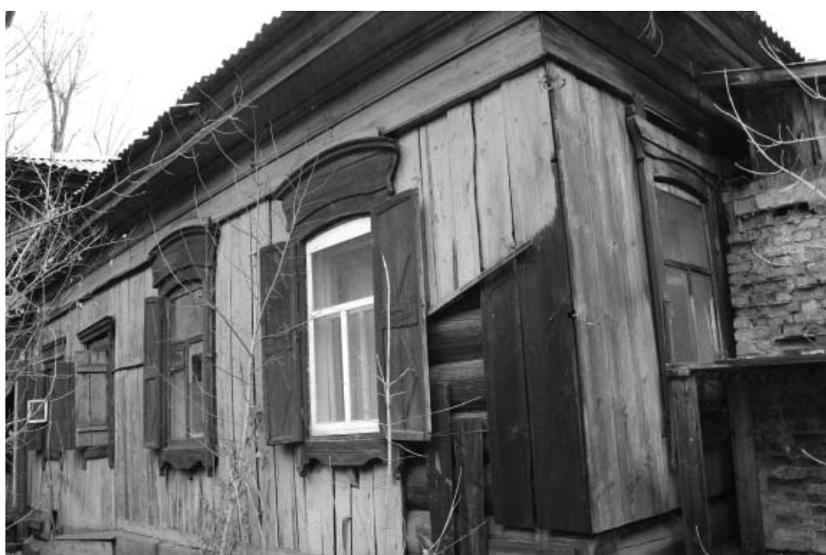
Фото Н.В. Шастун, март 2019 г. Фрагмент юго-западного фасада. Вид с южного угла.
