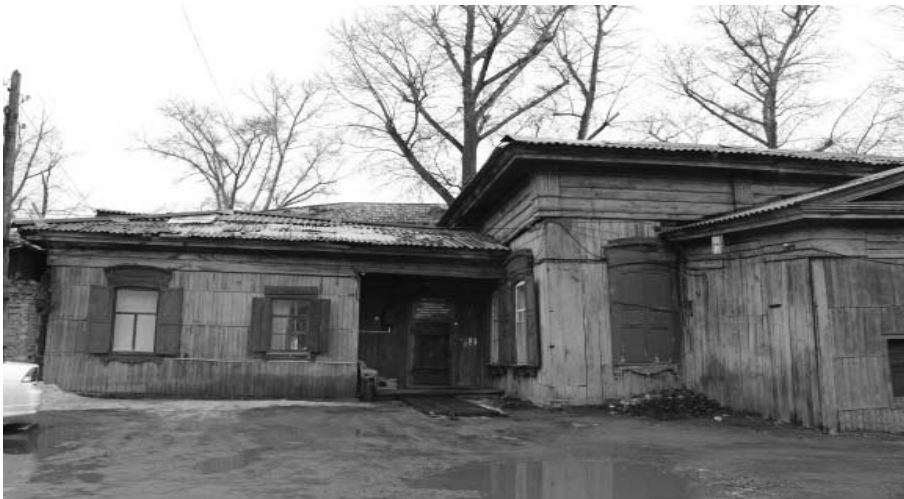
Фото Н.В. Шастун, март 2019 г. Фрагмент северо-восточного фасада.
