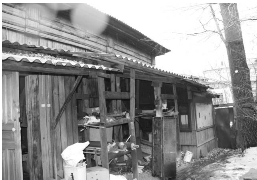
Фото Н.В. Шастун, март 2019 г. Фрагмент юго-западного фасада. Вид с западного угла.
