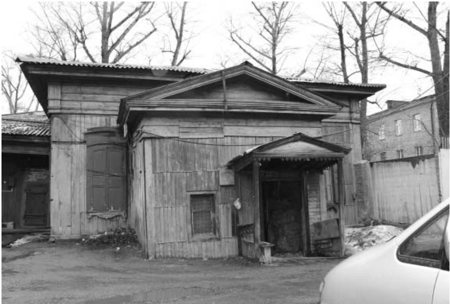
Фото Н.В. Шастун, март, 2019 г. Фрагмент северо-восточного фасада. Входной прируб.
