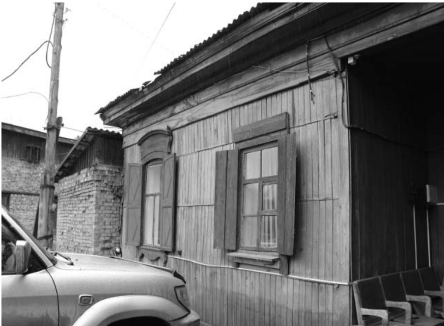
Фото Н.В. Шастун, март 2019 г. Фрагмент северо-восточного фасада. Левый фланг.
