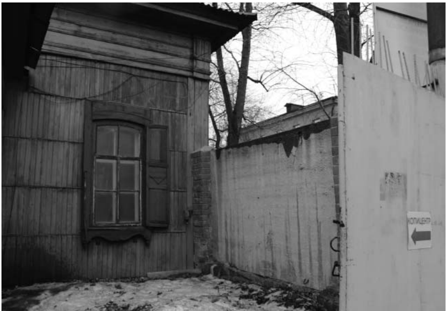
Фото Н.В. Шастун, март 2019 г. Фрагмент северо-восточного фасада.
