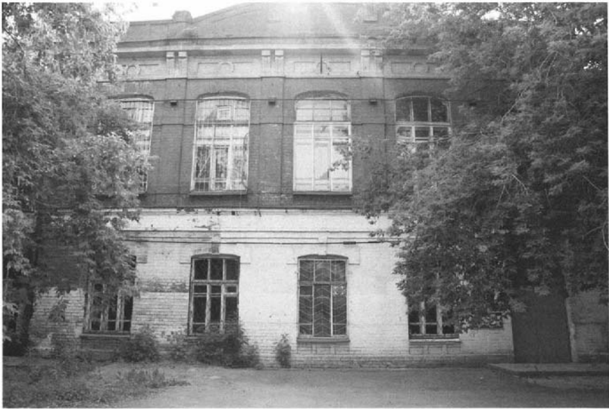
Фото 1 - Общий вид здания
