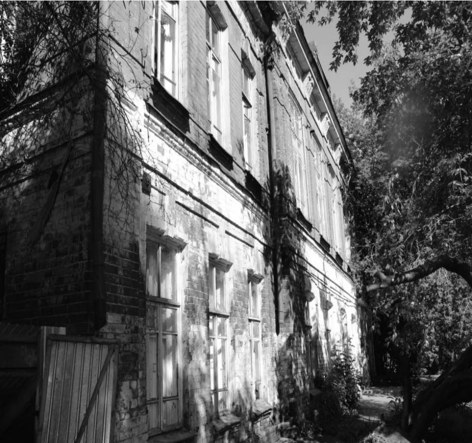
Фото Н.В. Шастун., август 2018 г. Главный (северо-восточный) фасад. Вид с восточного угла.
