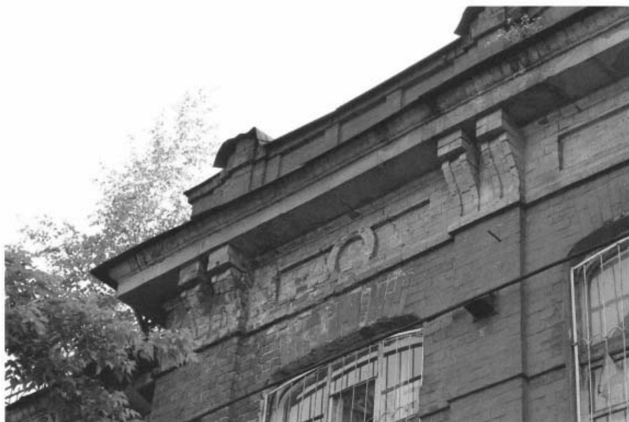
Фото 4 - Фриз и карниз на главном фасаде
