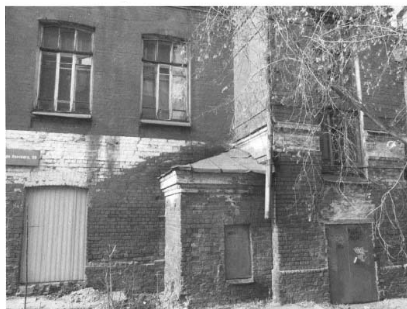
Фото 10 - Фрагмент юго-восточного фасада
