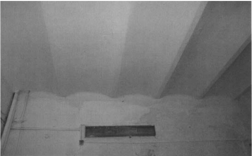
Фото 15 - Фрагмент интерьера. Сводчатые перекрытия
