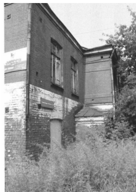
Фото 8 - Фрагмент юго-восточного фасада
