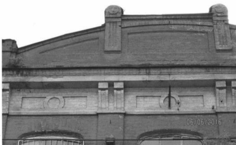
Фото 5 - Аттиковая стенка на главном фасаде
