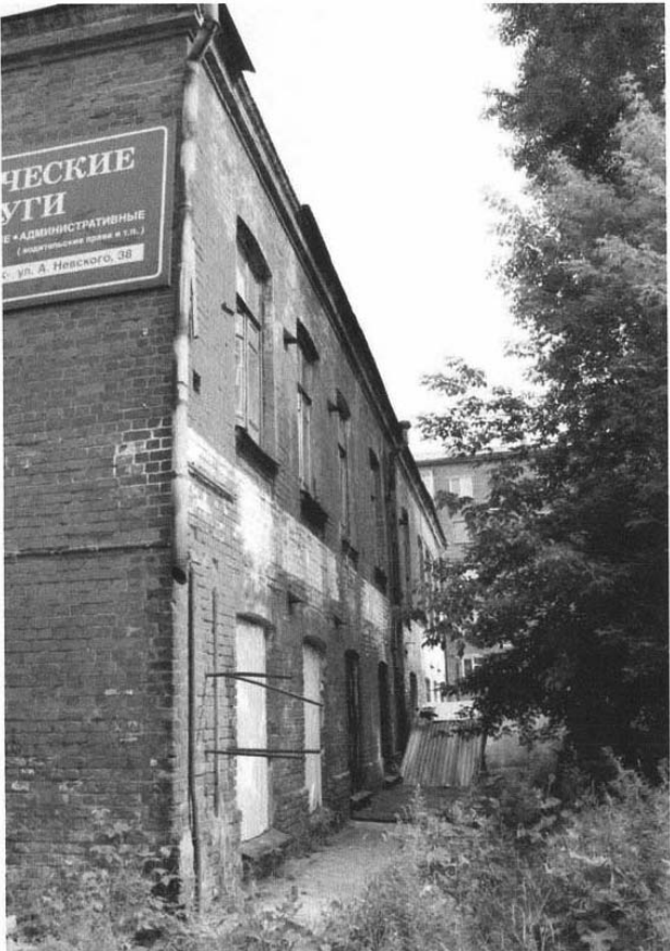
Фото 11 - Фрагмент юго-западного фасада
