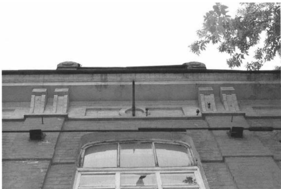
Фото 3 - Фриз и карниз на главном фасаде
