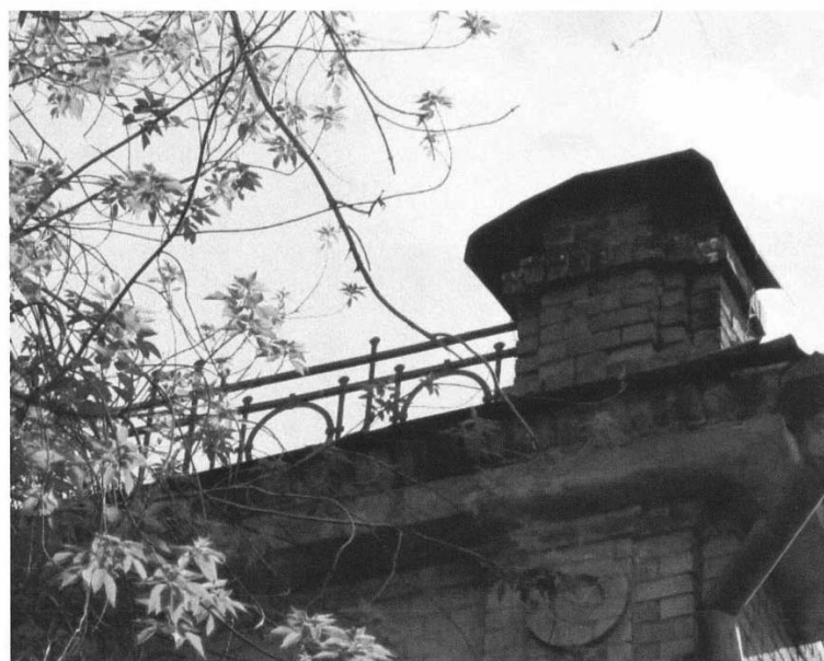
Фото 6 - Ограждение кровли. Главный фасад
