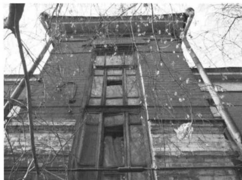
Фото 9 - Фрагмент юго-восточного фасада
