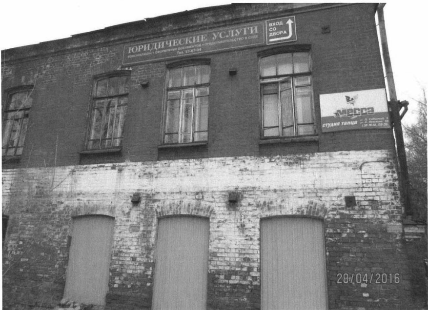
Фото 12 - Оконные проемы юго-западного фасада
