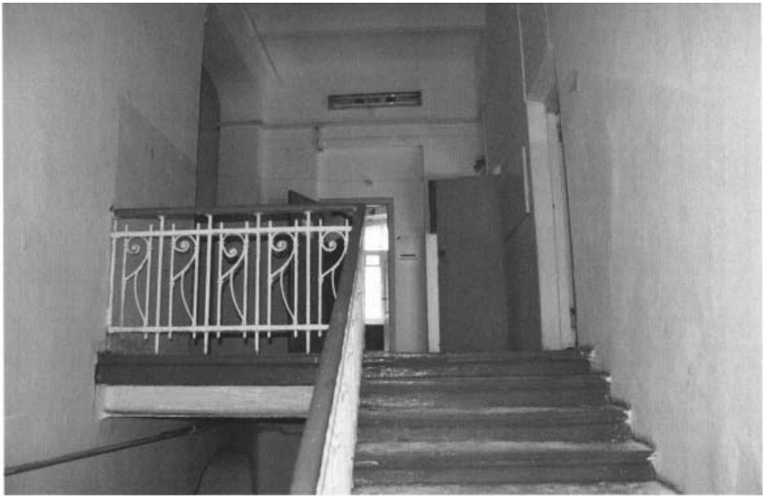
Фото 13 - Фрагмент интерьера. Лестница
