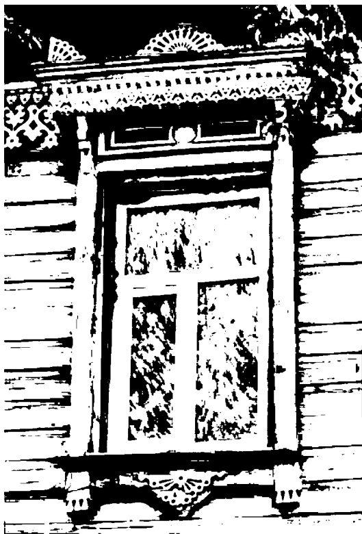
Оконное обрамление второго этажа
