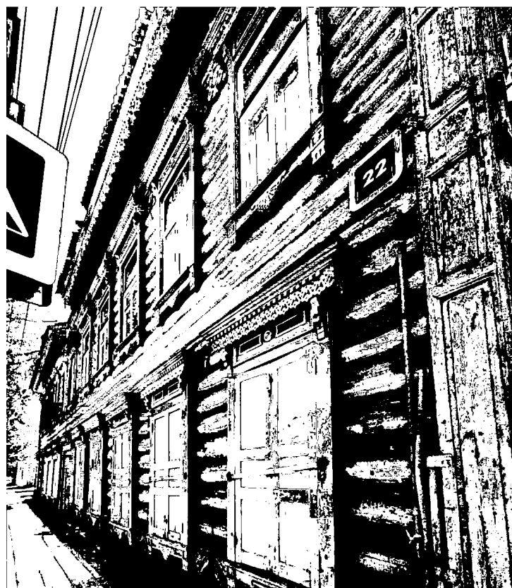
Уличный фасад Объекта
