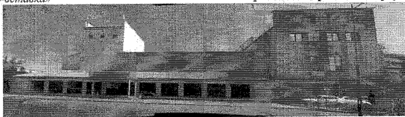
Боковой юго-западный фасад 3 «Театрального» корпуса, ориентированный на улицу Франк-Каменецкого: справа-налево – фойе, зрительный зал, сценическая коробка.
