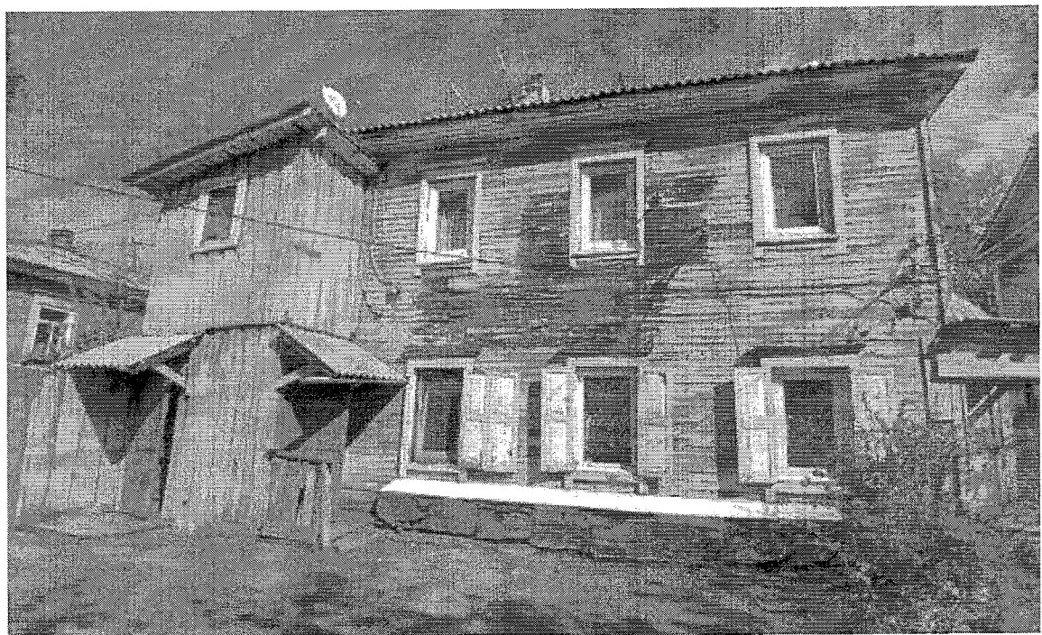
Вид на северо-западный фасад Объекта
