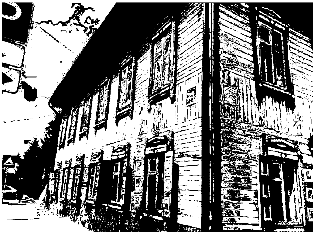
Главный юго-западный фасад здания под лит. А «Доходный дом». Вид с юга
