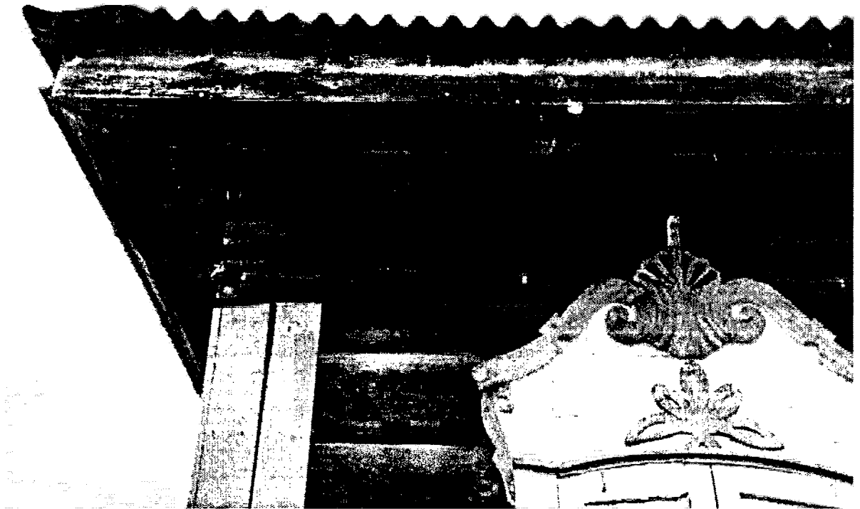
Фотография № 4. Фрагмент юго-восточного фасада объекта культурного наследия
