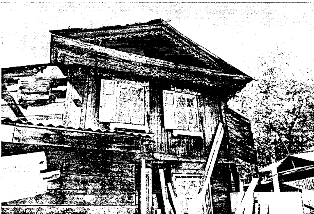
Фотография № 5. Вид на фрагмент фасада объекта культурного наследия.
