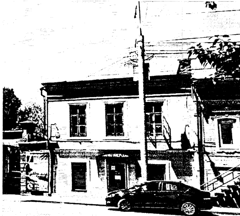
Фотография № 1. Вид с улицы Тимирязева на объект культурного наследия
