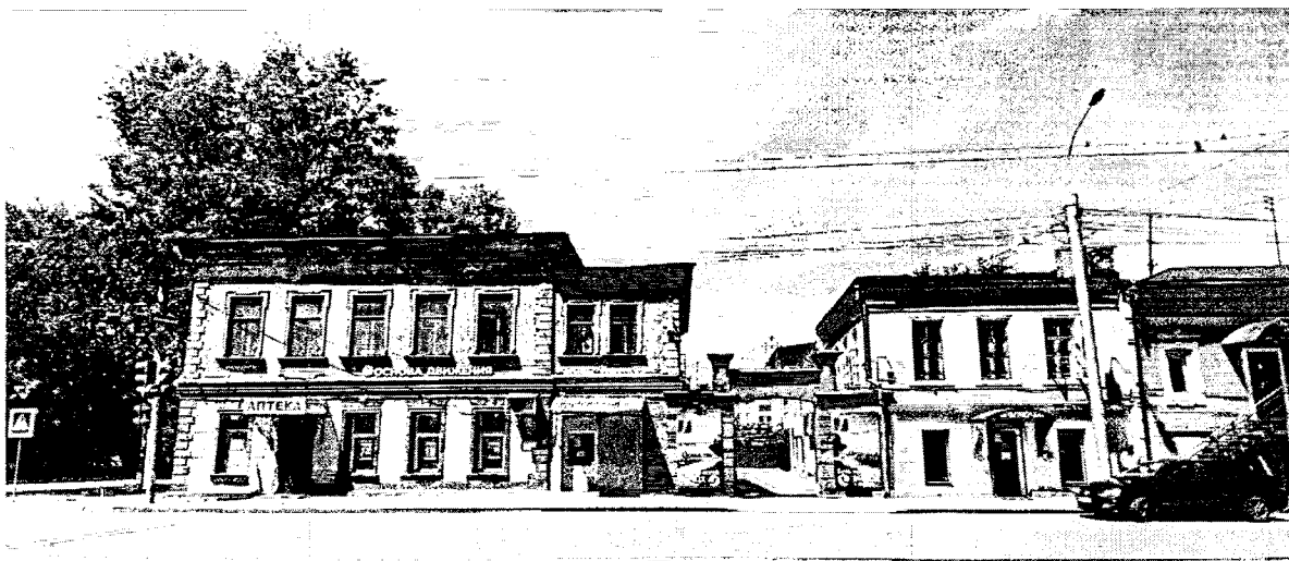
Фотография № 1. Вид с улицы Тимирязева на объект культурного наследия
