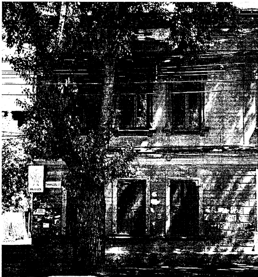
Фотография № 5. Вид на фрагмент фасада объекта культурного наследия
