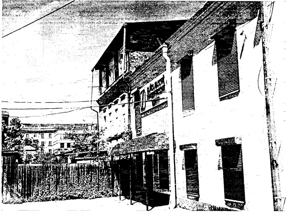
Фотография № 3. Вид на фрагмент фасада объекта культурного наследия
