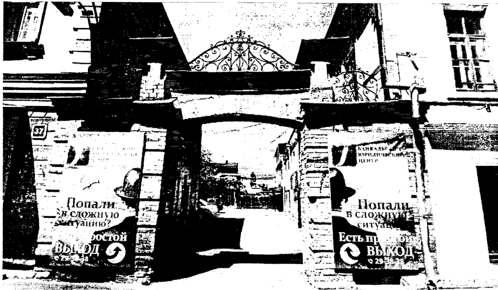
Фотография № 1. Вид с улицы Тимирязева на объект культурного наследия
