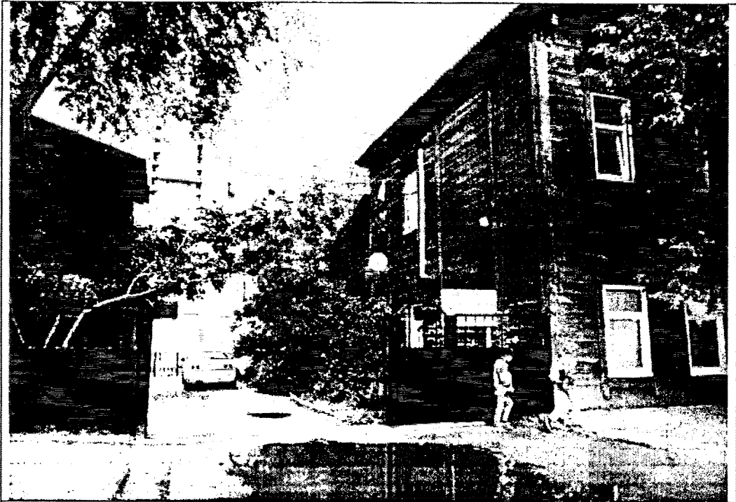
19. Вид с улицы на каменное здание в глубине усадьбы по ул. Бабушкина, 7 Б.
