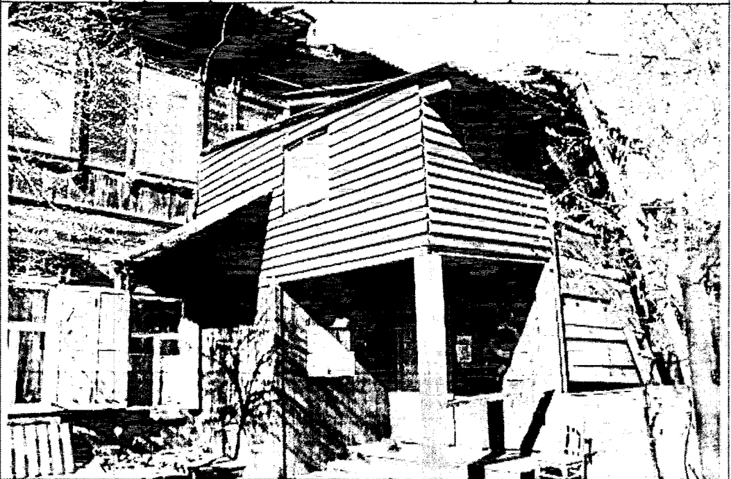
8. Пристрой северо-восточного фасада с поздней пристройкой перед входами.
