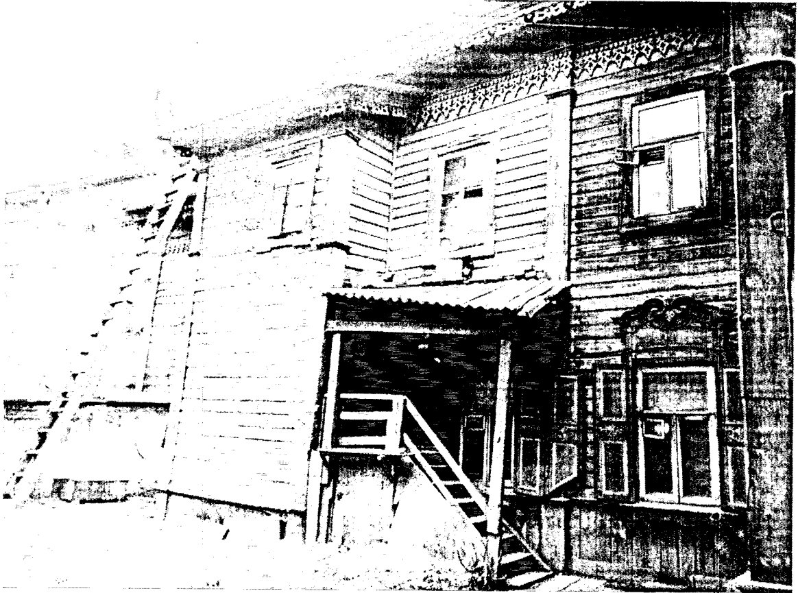
Фото 3. Фрагмент главного фасада доходного дома (лит. а) по ул. Сурикова
