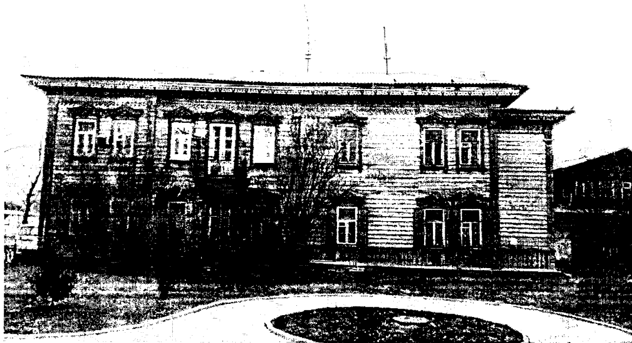
Фото 5. Фрагмент северо-восточного фасада доходного дома (лит. а)
