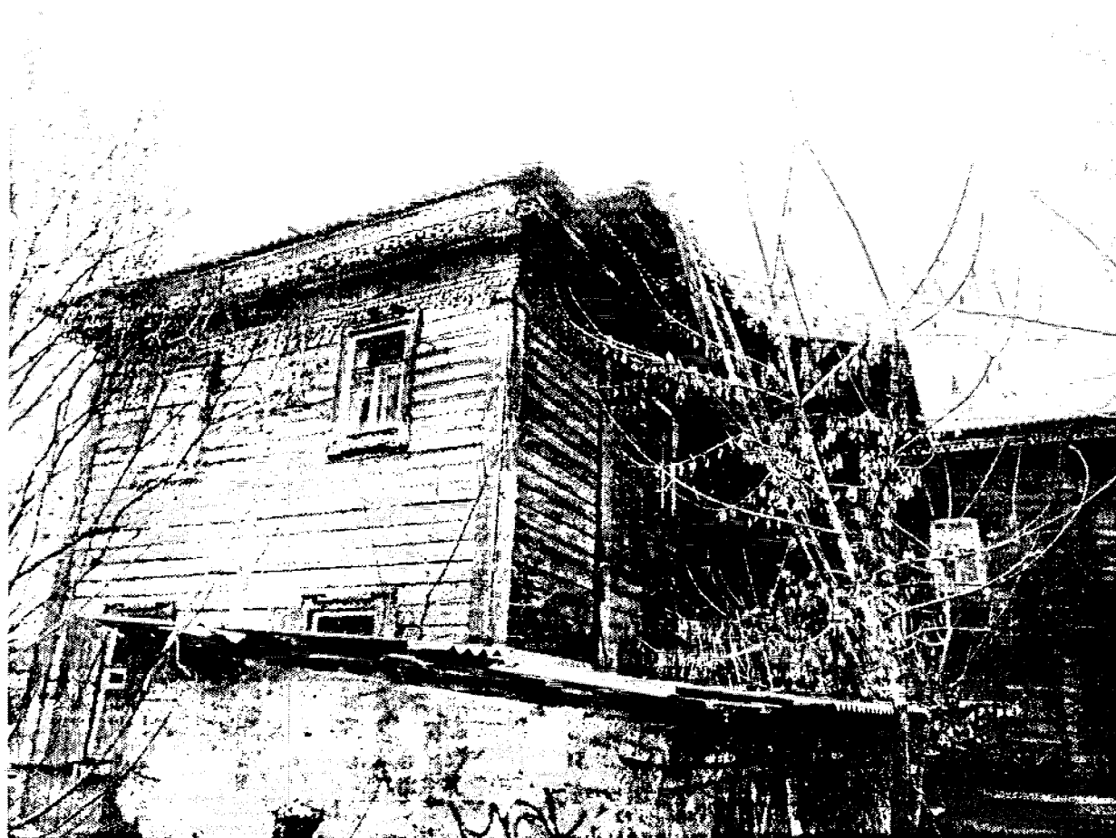
Фото 6. Юго-восточный фасад доходного дома (лит. а)
