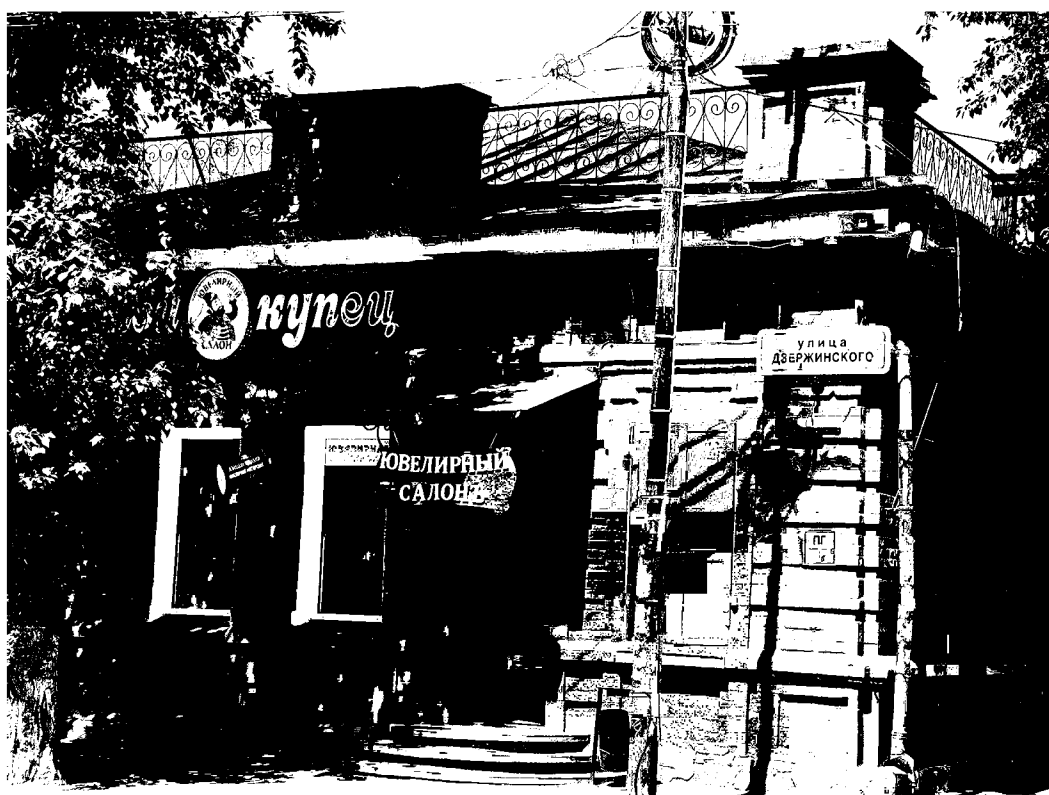
Фотография № 2. Вид с улицы Дзержинского на фрагмент фасада объекта культурного наследия
