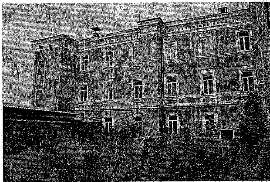
Фото 23. Дворовой юго-западный фасад. Правое крыло.
