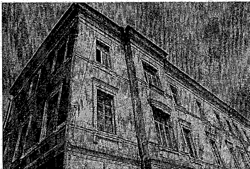
Фото 16. Фрагмент бокового юго-западного фасада.
