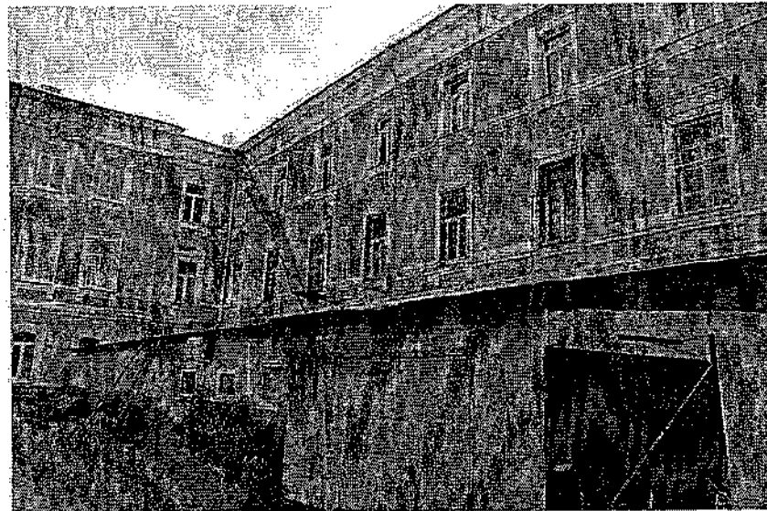
Фото 22. Дворовой северо-восточный фасад. Левое крыло.
