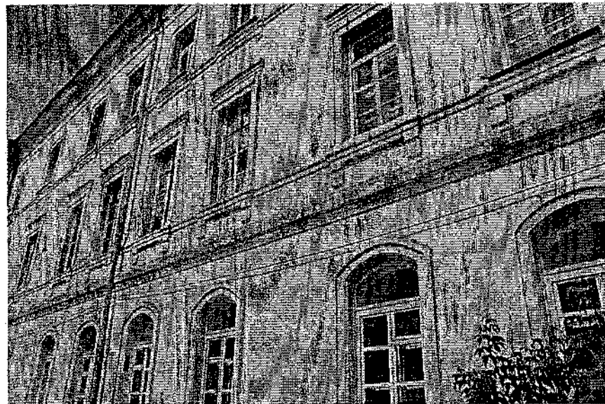
Фото 17. Фрагмент бокового юго-западного фасада.
