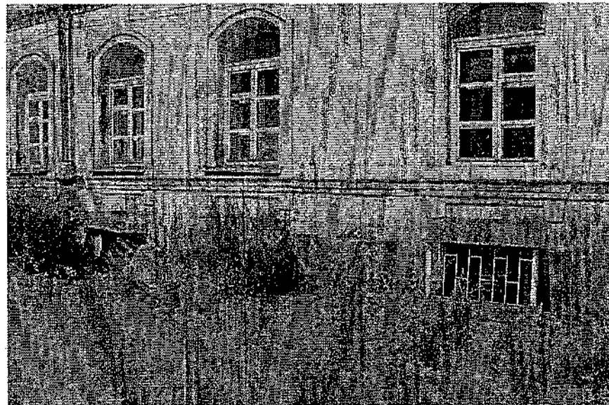
Фото 18. Фрагмент бокового юго-западного фасада.
