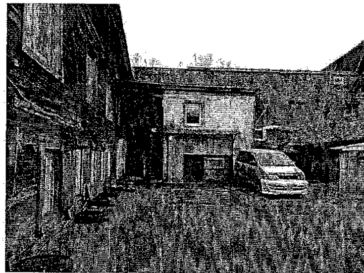
Фото 12. Северо-западный фасад дома под лит. а.
