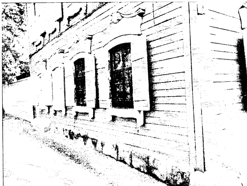
Фото 2 – Фрагмент северо-восточного фасада
