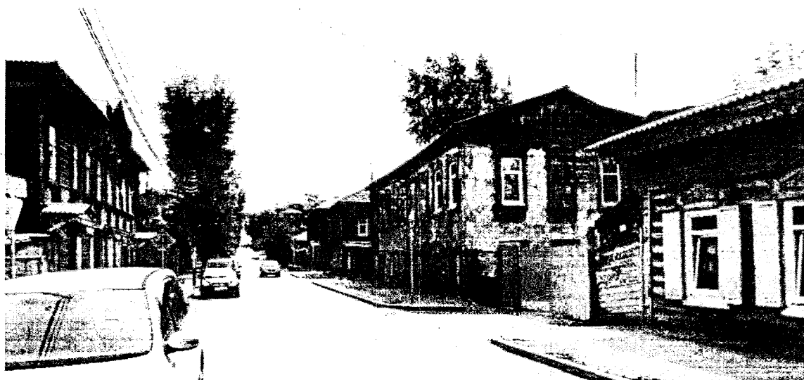
Фото 1 – ОКН в застройке ул. Грязнова. Вид с северо-запада
