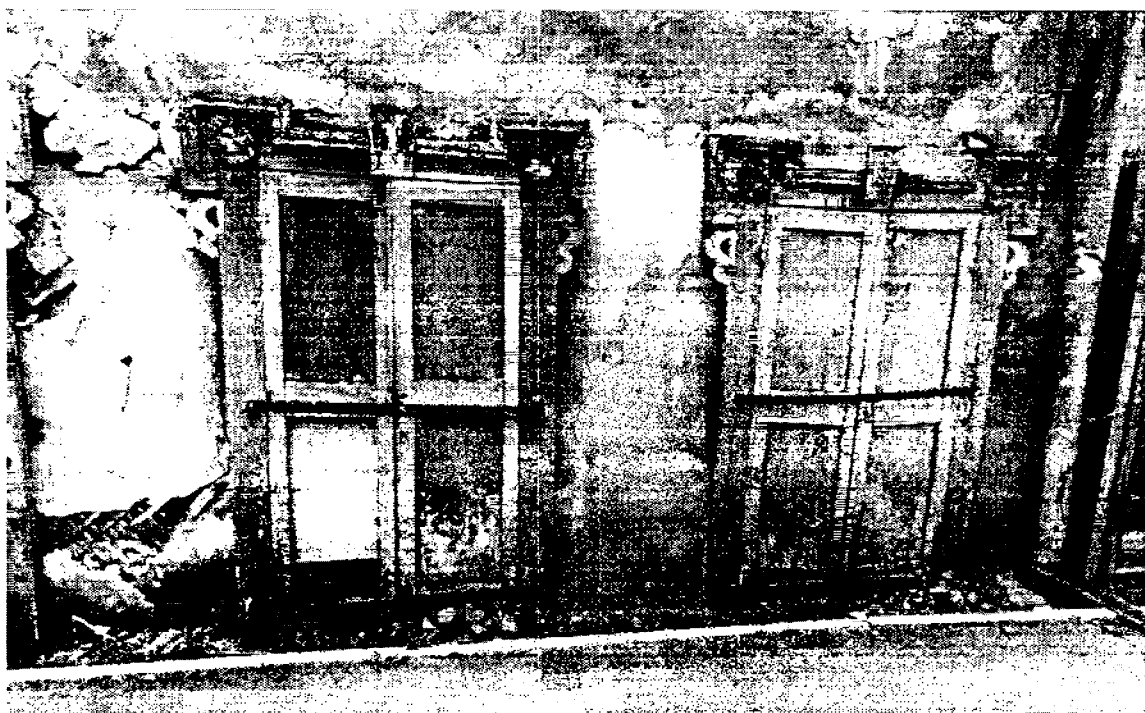
Фото 4 – Наличники оконного проема 1 этажа
