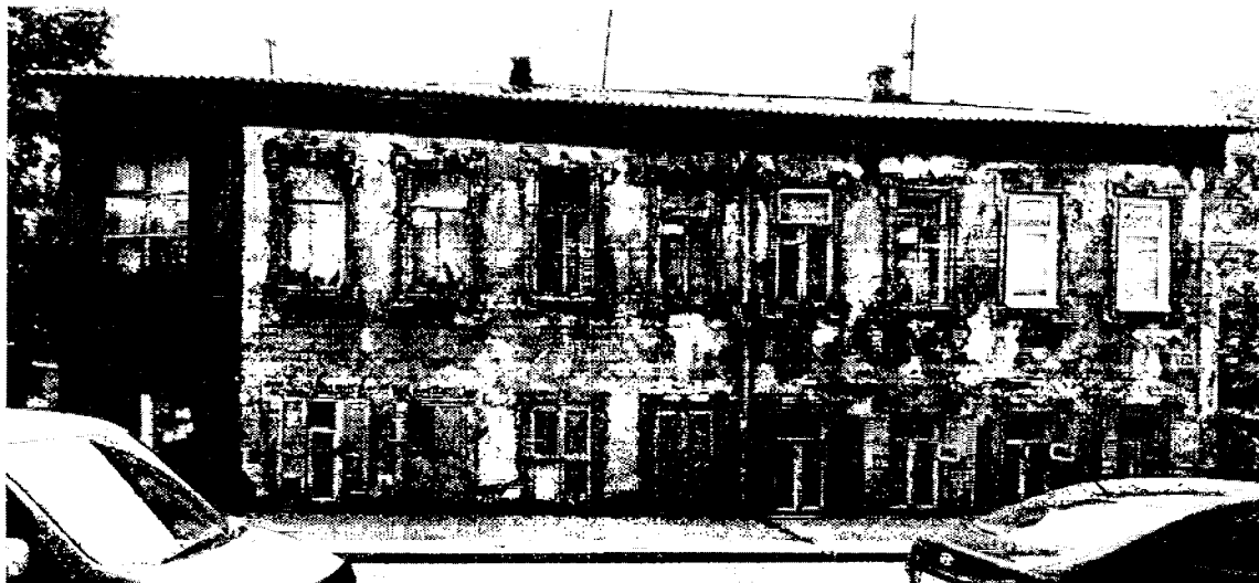
Фото 3 – Главный северо-восточный фасад
