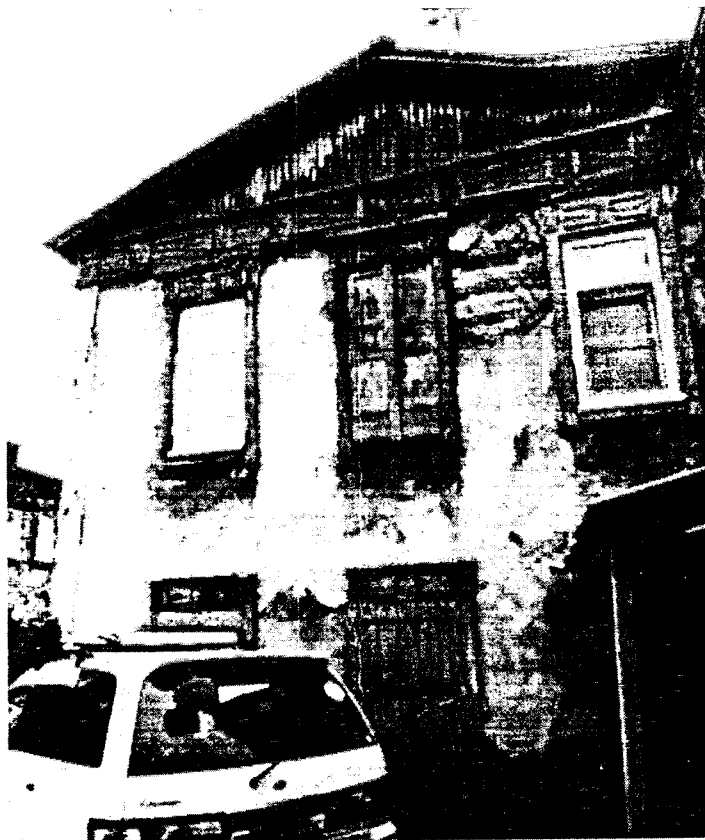
Фото 6 – Фрагмент бокового северо-западного фасада
