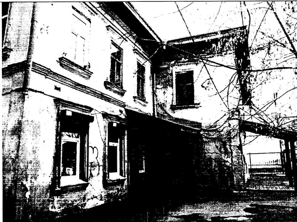
Фото 6 – Дворовой фасад, вид с юго-запада
