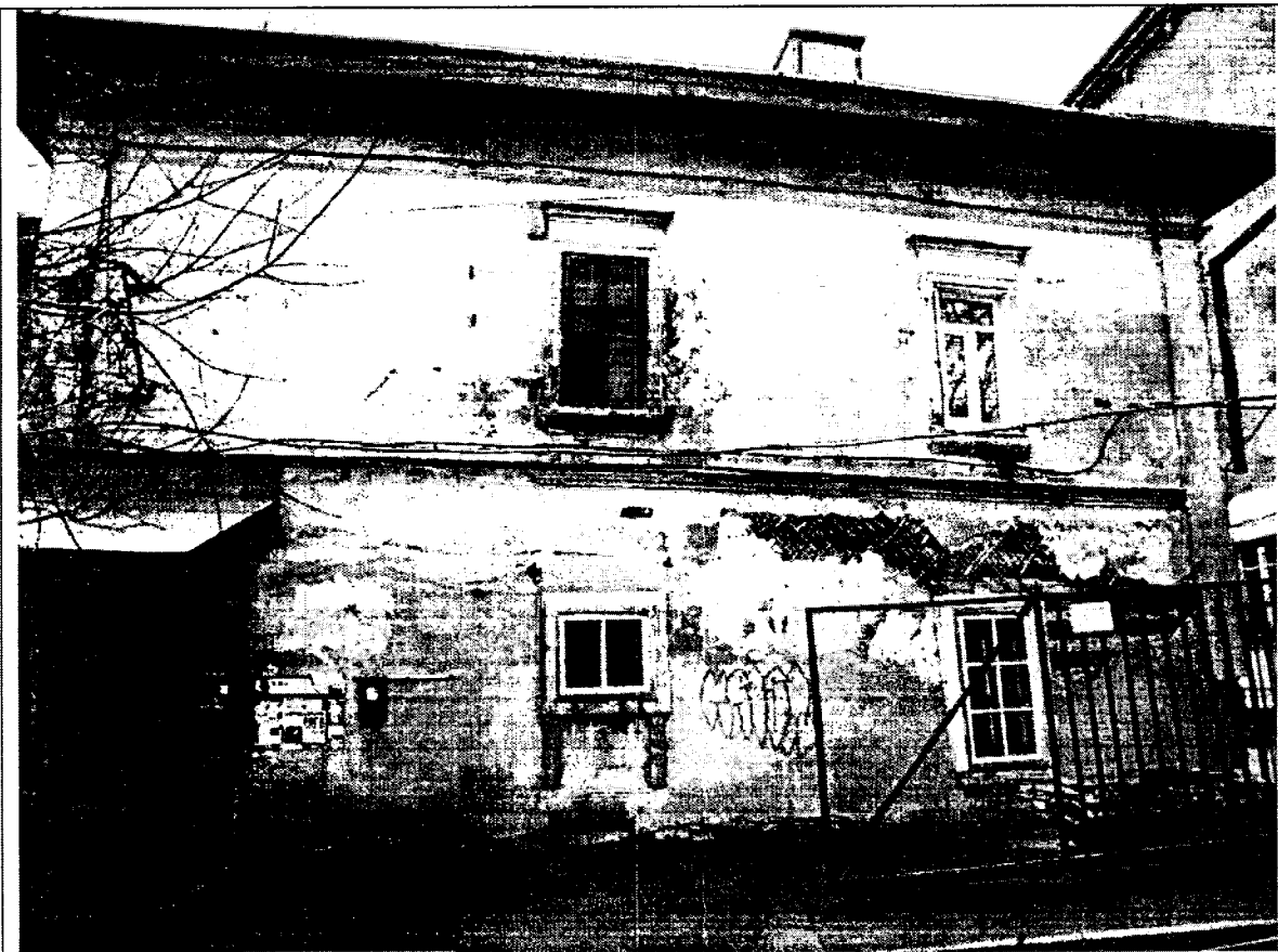
Фото 5 – Северо-западный фасад пристроя
