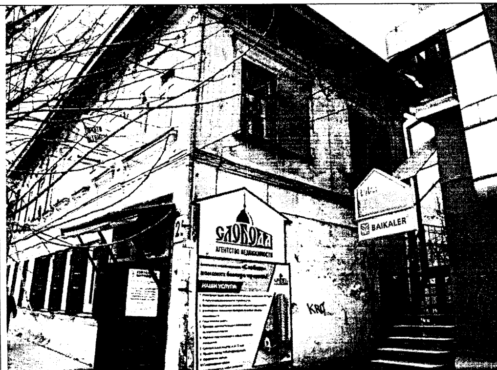
Фото 2 – Боковой северо-восточный фасад
