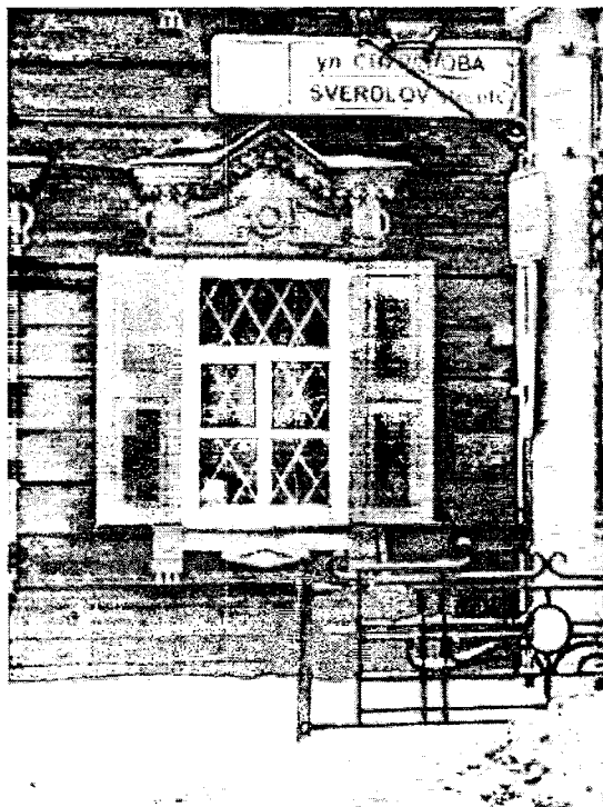
Фото 5 – Рядовой оконный проем 1 этажа главного фасада.
