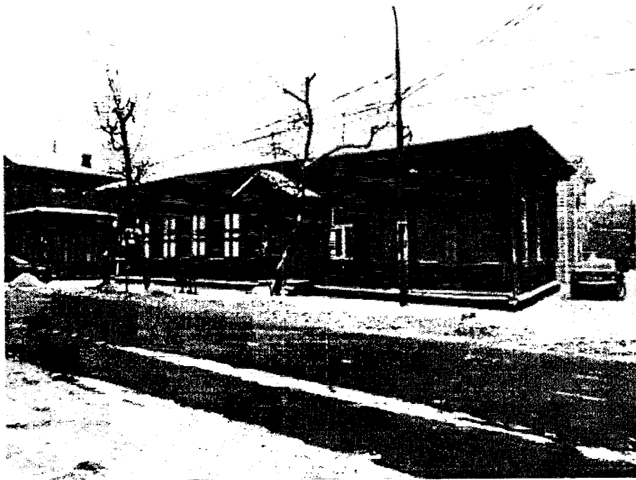
Фото 14 – Главный юго-восточный фасад
