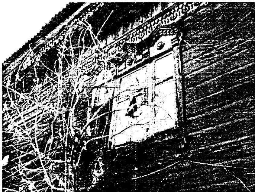
Фото 11 — Тройной оконный проем бокового фасада
