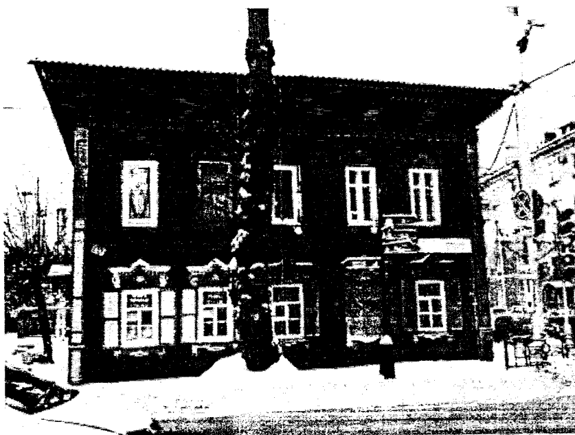
Фото 2 – Юго-восточный фасад по ул. Свердлова
