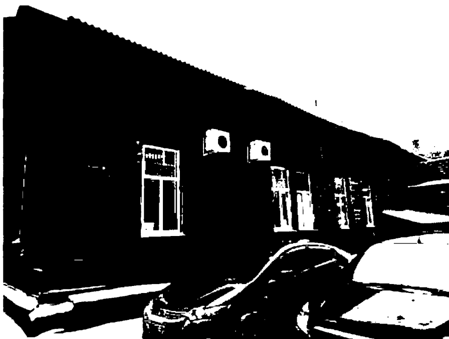
Фото 18 – Фрагмент дворового фасада
