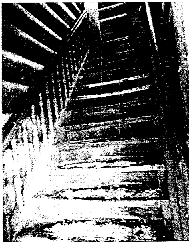
Фото 13 – Лестница в прируббе.
