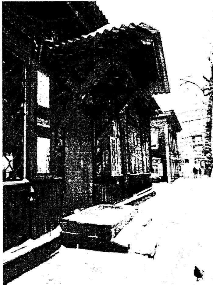
Фото 23 – Крыльцо парадного входа
