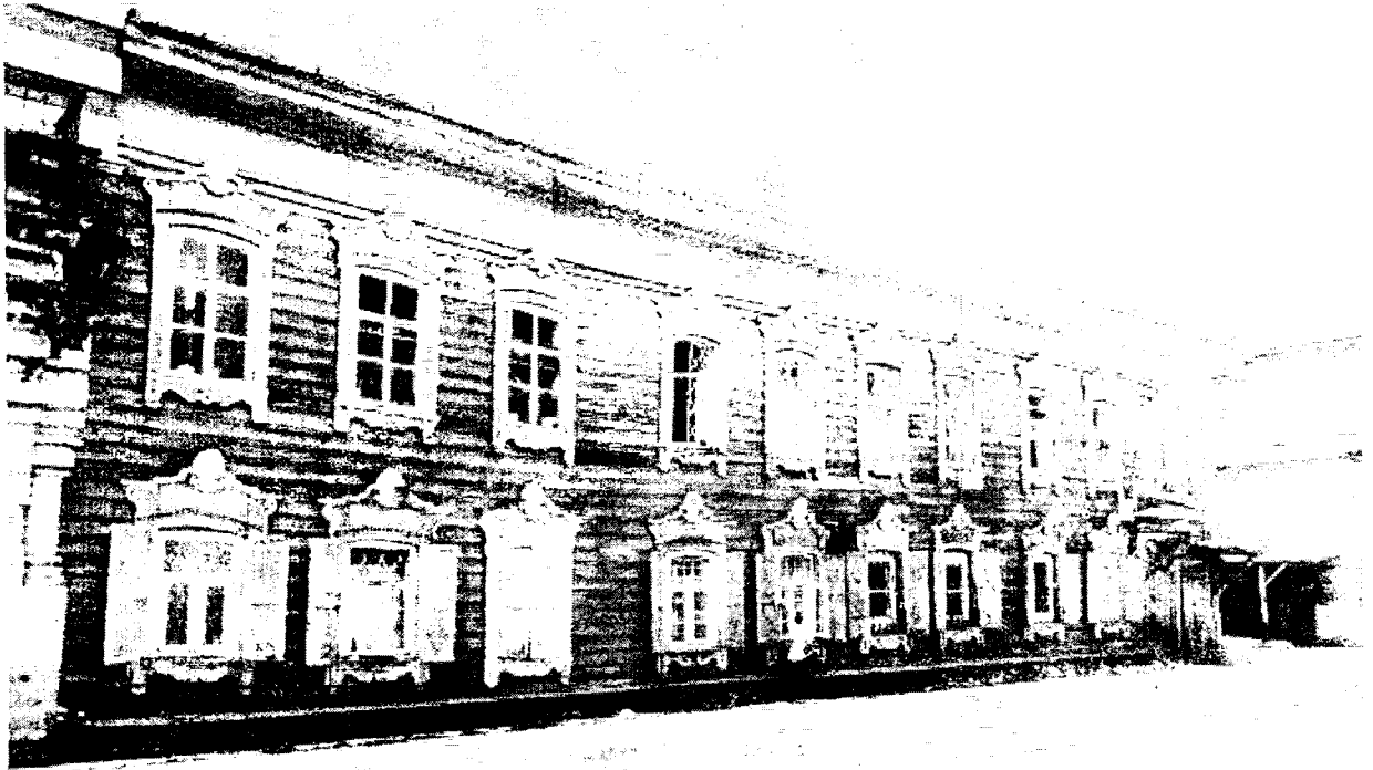
Фото 1 – Главный юго-восточный фасад
