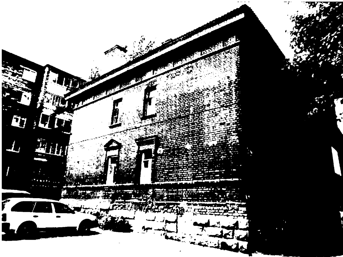
5. Боковой (восточный) фасад.
