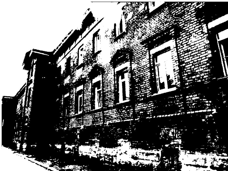
2. Фрагмент главного (северного) фасада – центральная часть.
