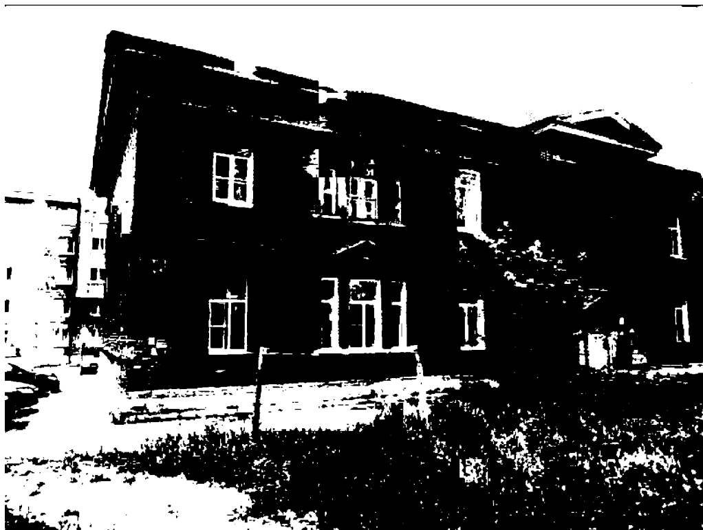
31) Юго-западный угол дома.
