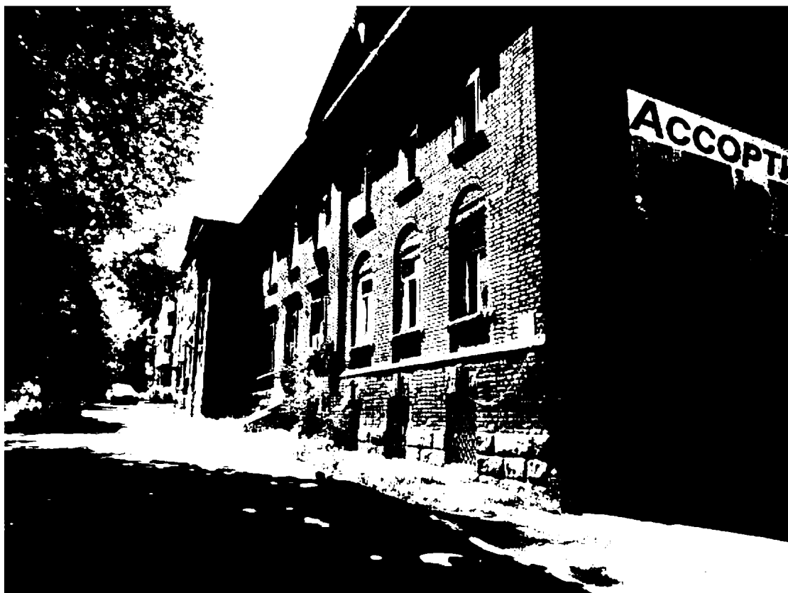
19. Восточный продольный фасад.
