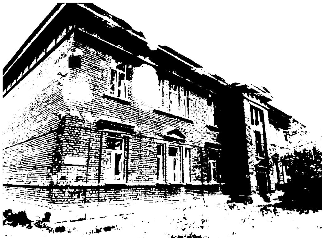
53) Фрагмент уличного (южного) фасада здания лит. Е.
