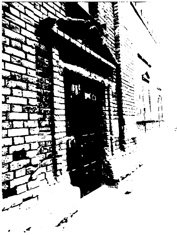
36) Портал правого входного ризалита со стороны улицы.
