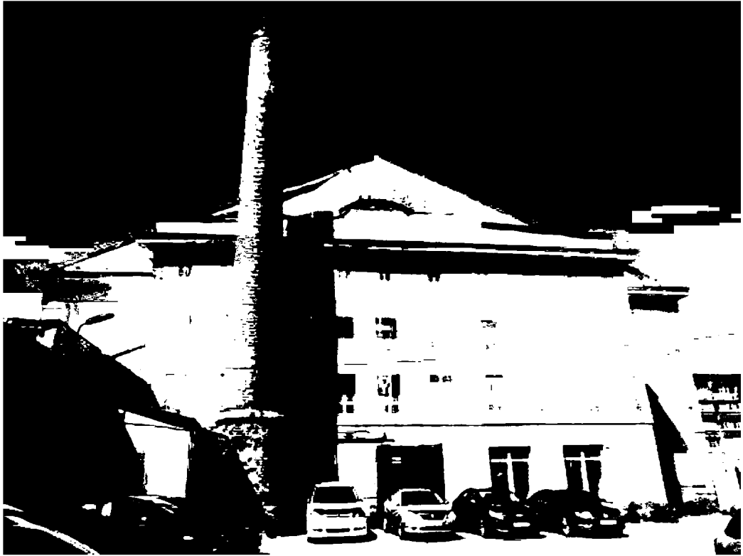
15. Боковой (восточный) фасад.
