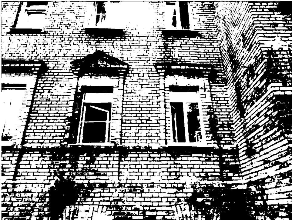
10. Оконные проемы 1 этажа. Подоконный пояс.
