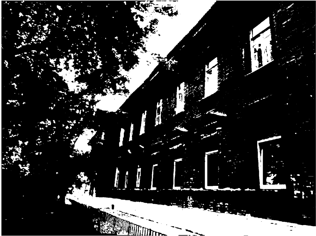
43) Фрагмент главного (южного) фасада здания лит. Д.
