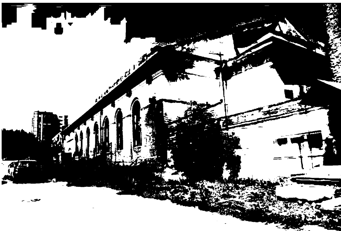
13. Торцевой (западный) фасад.
