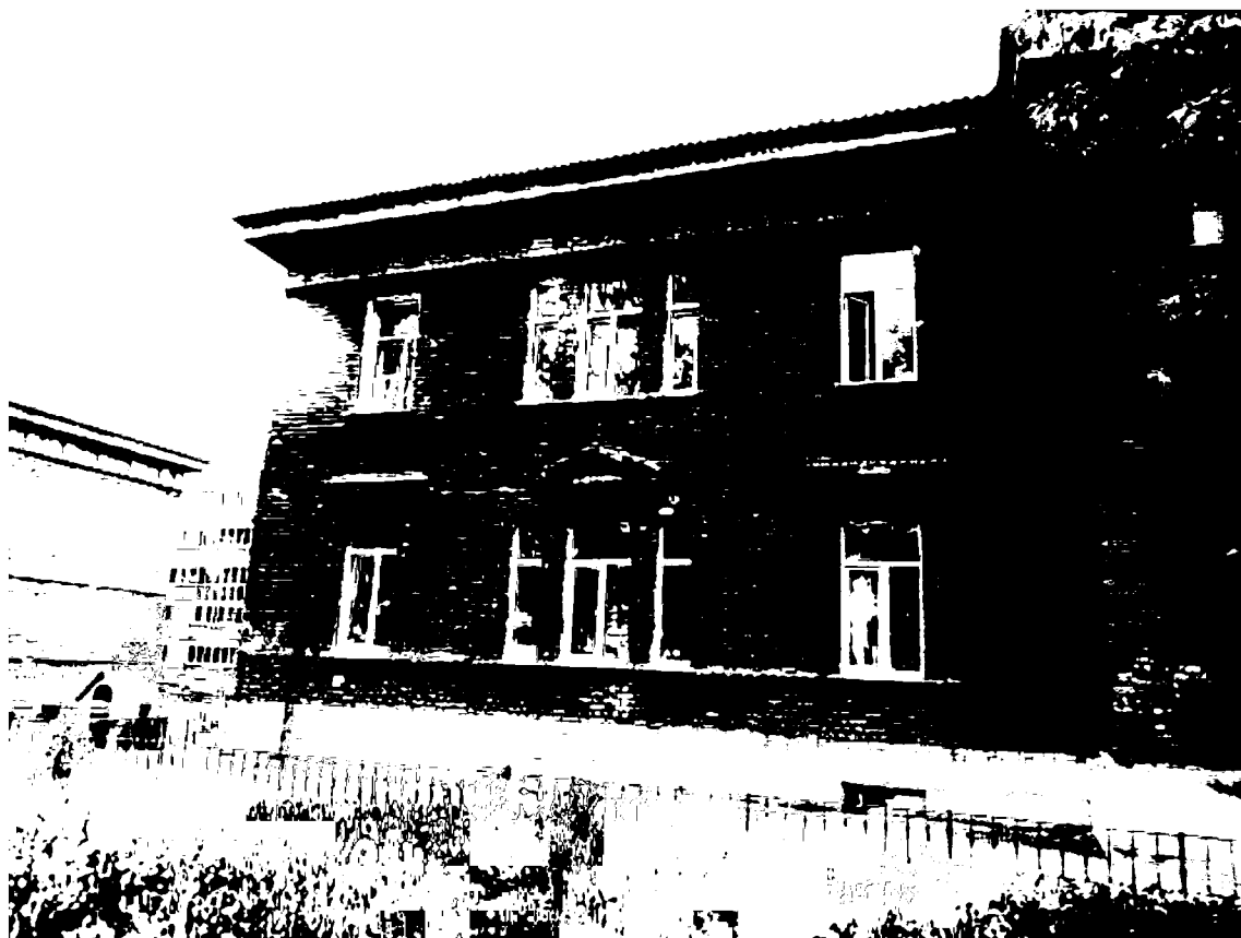
52) Группы строенных окон уличного фасада дома и рядовые оконные проемы.
