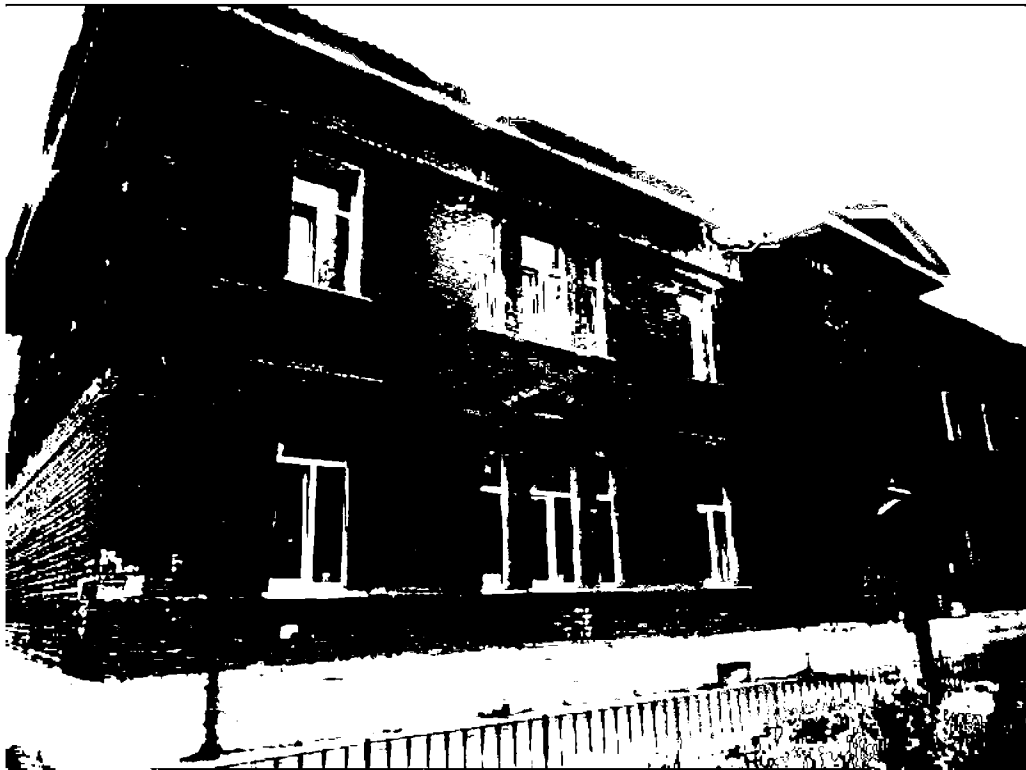
44) Фрагмент главного фасада. Юго-западный угол дома.
