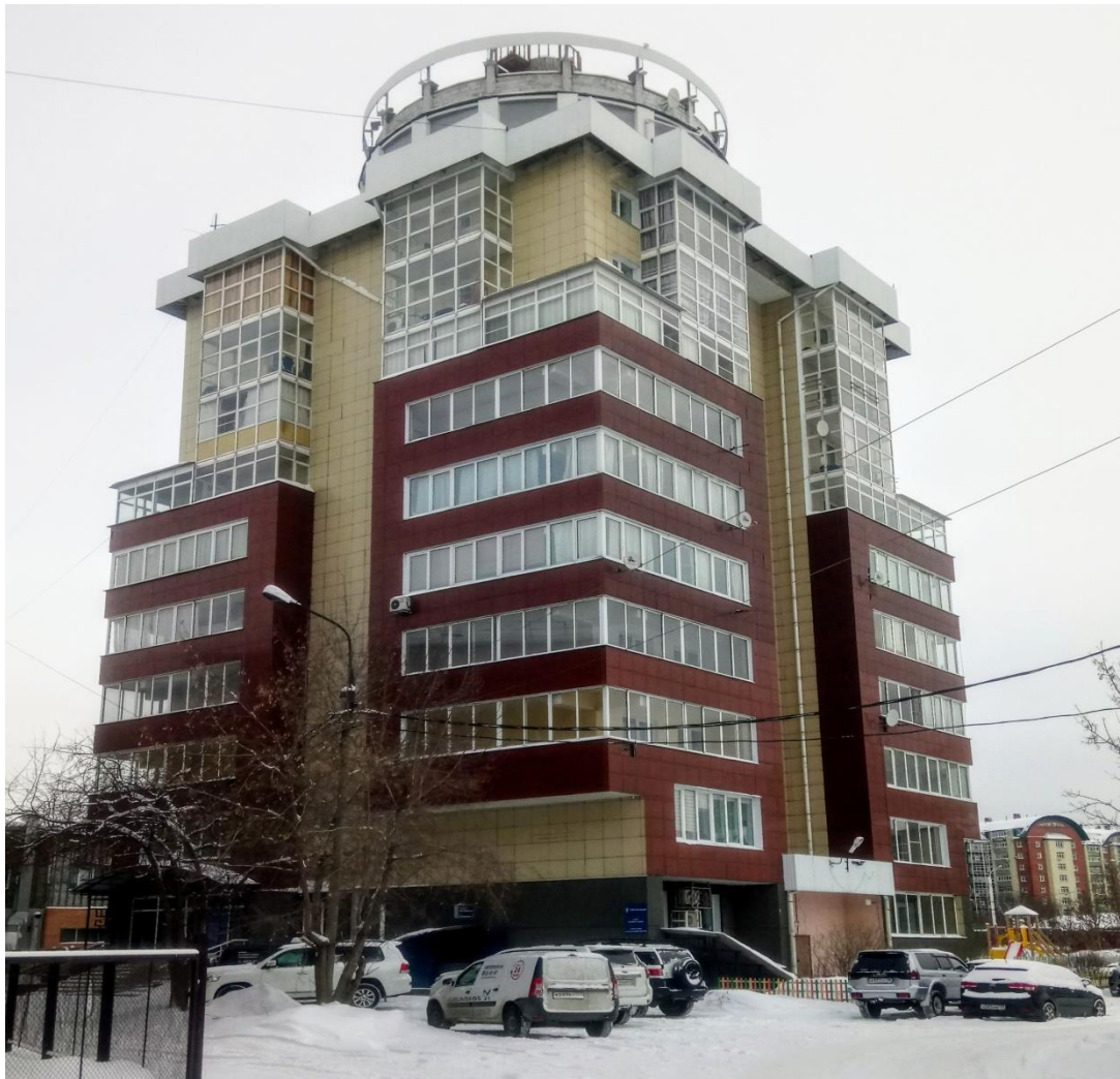
Фото 7. Многоквартирный жилой дом по адресу: г. Иркутск, ул. 4-я Советская, д. 48, возведенный с нарушением целевого использования земельного участка
