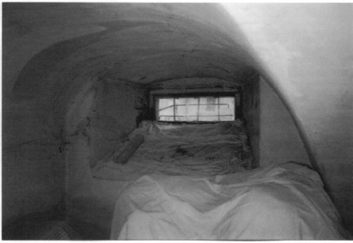
23.Окно второго света (частично заложено).
