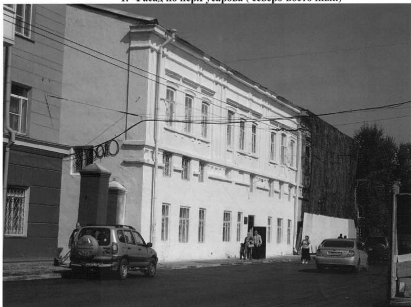
2. Фасад по ул. Желябова (юго-восточный)
