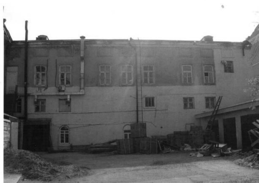
5. Дворовый северо-западный фасад
