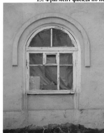
14. Оформление окна первого этажа фасада по пер.Гусарова
