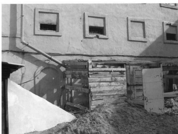
8. Фрагменты оформления юго-западного фасада, левый фланг
