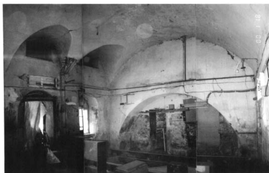
20. Фрагмент интерьера дворового помещения (№30а) торговых лавок (часть объема по пер. Гусарова). Коренной цилиндрический свод и конические распалубки над окнами второго света, заложённый арочный проём.
