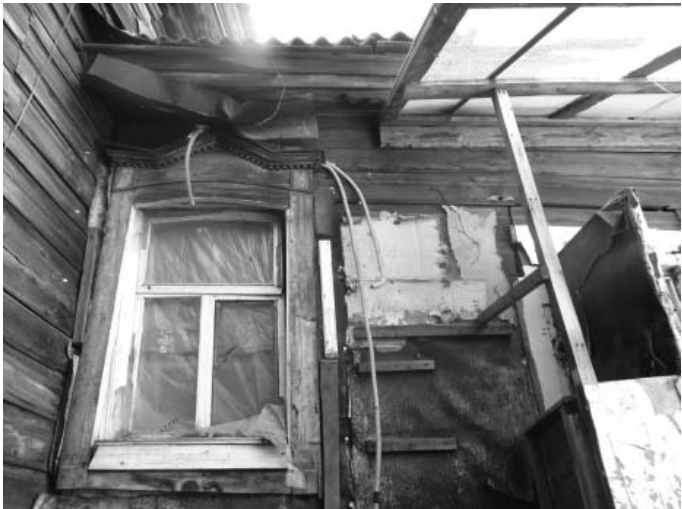
Фото 13 - Боковой юго-западный фасад (лит.А, А1)
