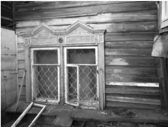
Фото 11 - Фрагмент стены дворового северо-западного фасада (лит.А)
