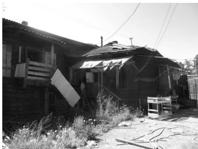
Фото 8 - Фрагмент дворового северо-западный фасад (лит. А1)
