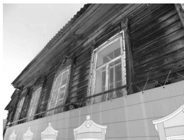
Фото 5 - Фрагмент главного юго-западного фасада (лит. А1)
