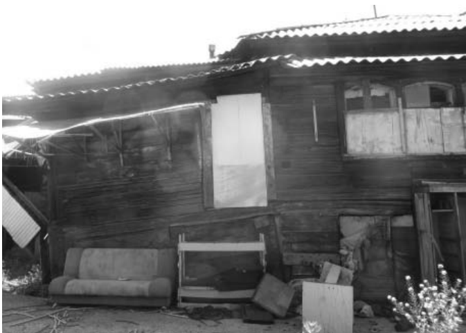
Фото 15 - Боковой юго-западный фасад (лит.А, А1)
