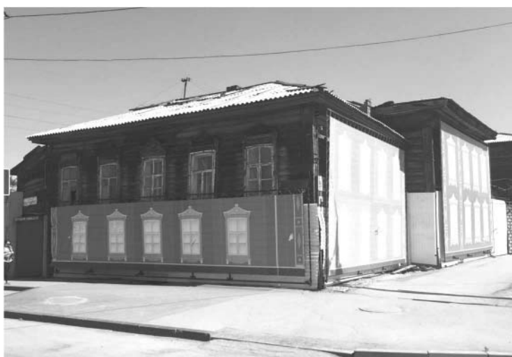
Фото 2 - Общий вид здания с южного угла
