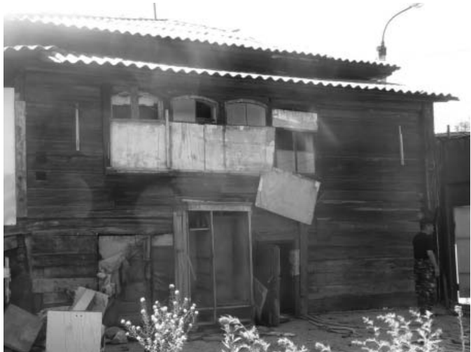
Фото 16 - Боковой юго-западный фасад (лит.А, А1)
