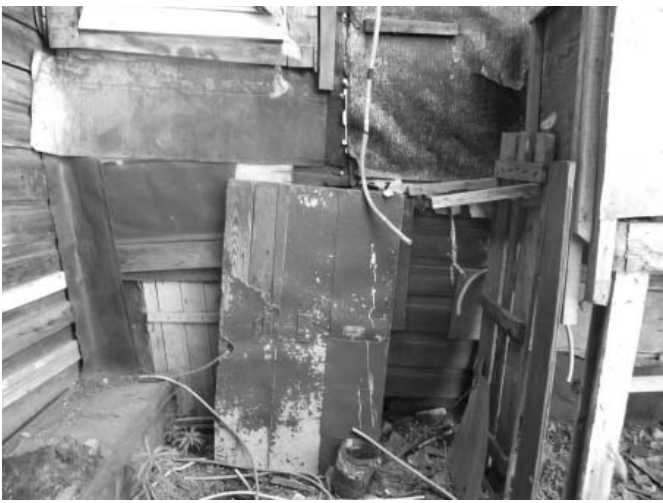
Фото 14 - Боковой юго-западный фасад (лит.А, А1)
