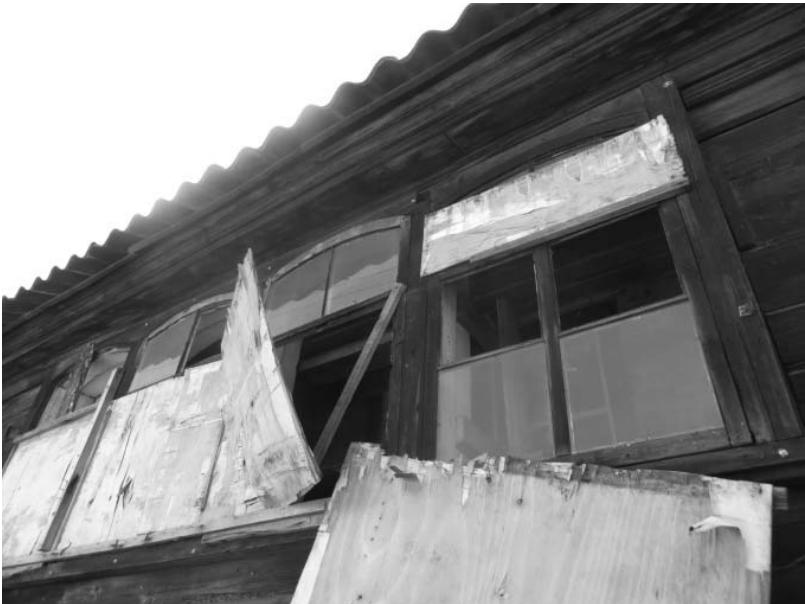
Фото 19 - Боковой юго-западный фасад (лит.А, А1)
