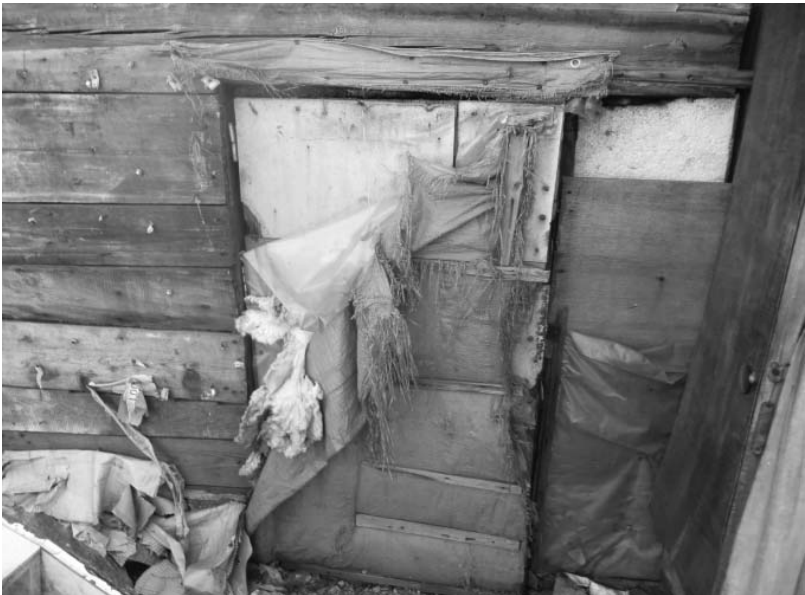
Фото 20 - Боковой юго-западный фасад (лит.А, А1)
