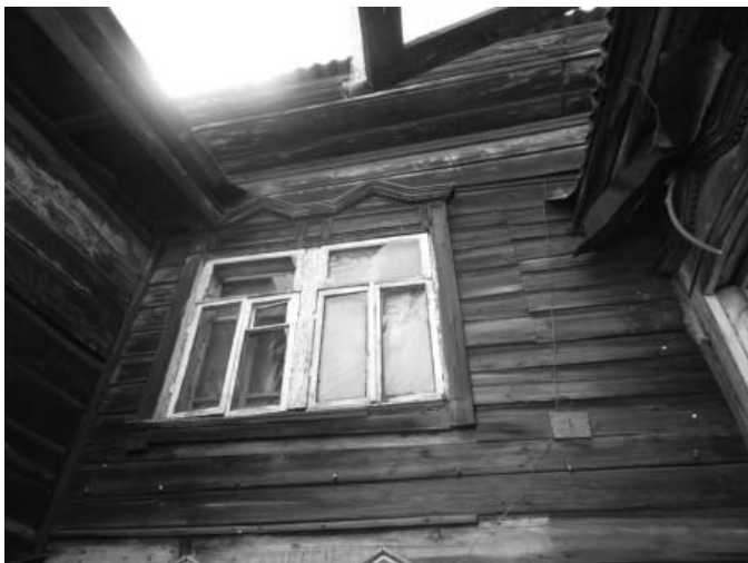
Фото 01 - Фрагмент стены дворового северо-западного фасада (лит.А)
