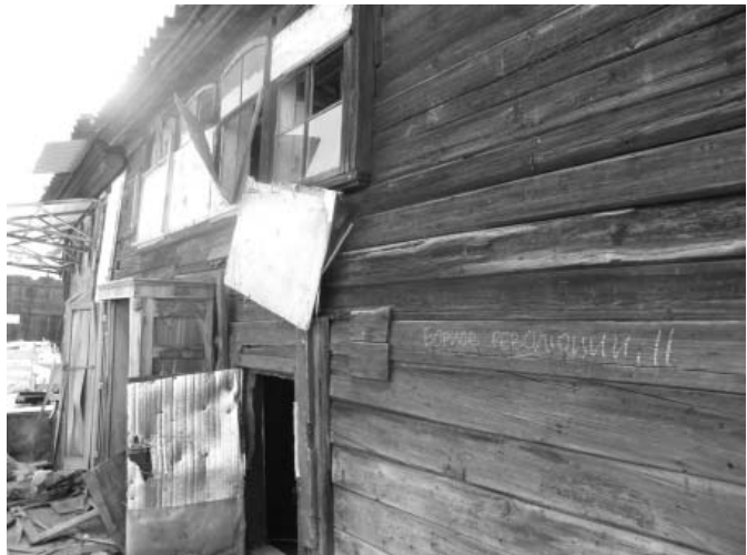
Фото 18 - Боковой юго-западный фасад (лит.А, А1)
