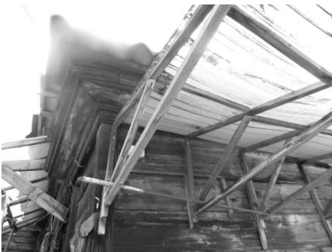
Фото 17 - Боковой юго-западный фасад (лит.А, А1)
