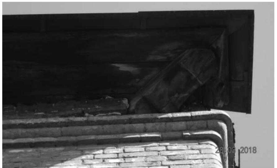
Фото 28 - Фигурный свес стропильной ноги. Угловой. Закругление угла и декора
