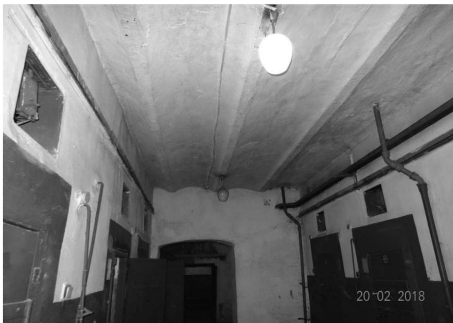
Фото 31 - Кирпичные сводки по металлическим балкам в помещении 1 этажа
