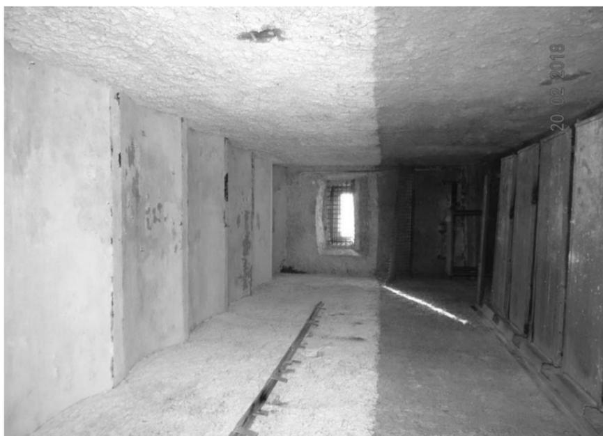
Фото 32 - Кирпичные сводки по металлическим балкам в помещении 1 этажа
