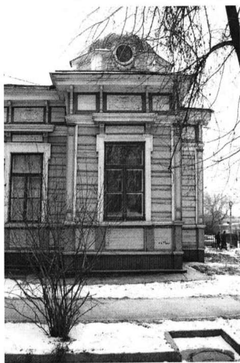
Северо-западный фасад. Ризалит.
