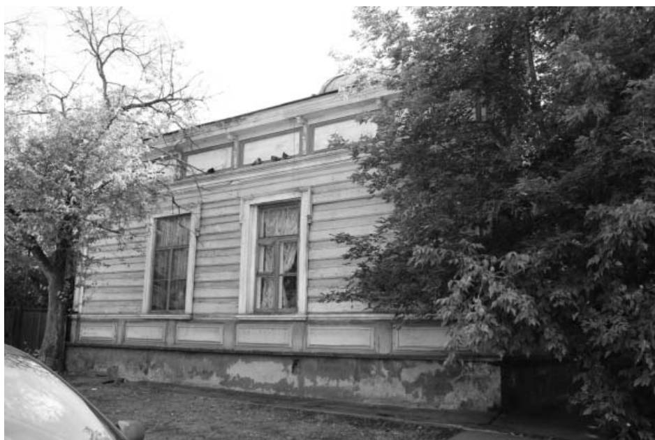
Фото Н.В. Шастун, сентябрь 2018 г. Фрагмент северо-восточного фасада.
