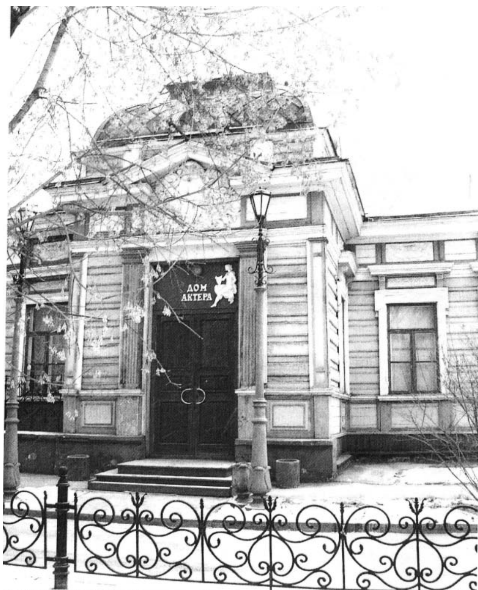
Северо-западный фасад. Центральный вход
