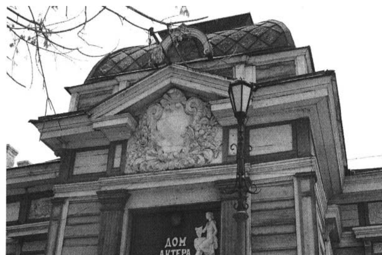
Северо-западный фасад. Коробовый купол.
