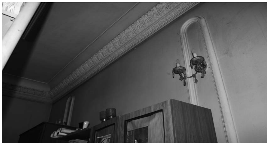
Фото Н.В. Шастун, сентябрь 2018 г. Фигурные филенчатые зеркала на стенах в пом. №3 (по плану МУП «БТИ г. Иркутска»)
