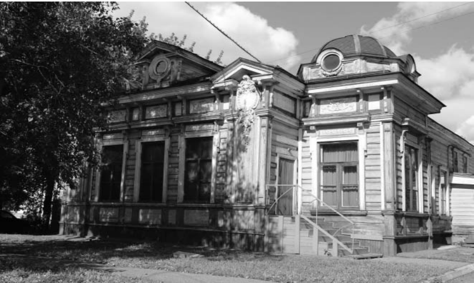
Фото Н.В. Шастун, сентябрь 2018 г. Юго-западный фасад. Вид с южного угла.
