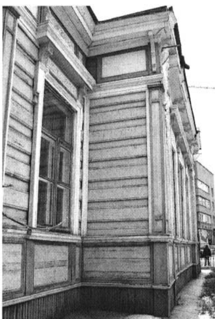
Юго-западный фасад. Угол ризалита.
