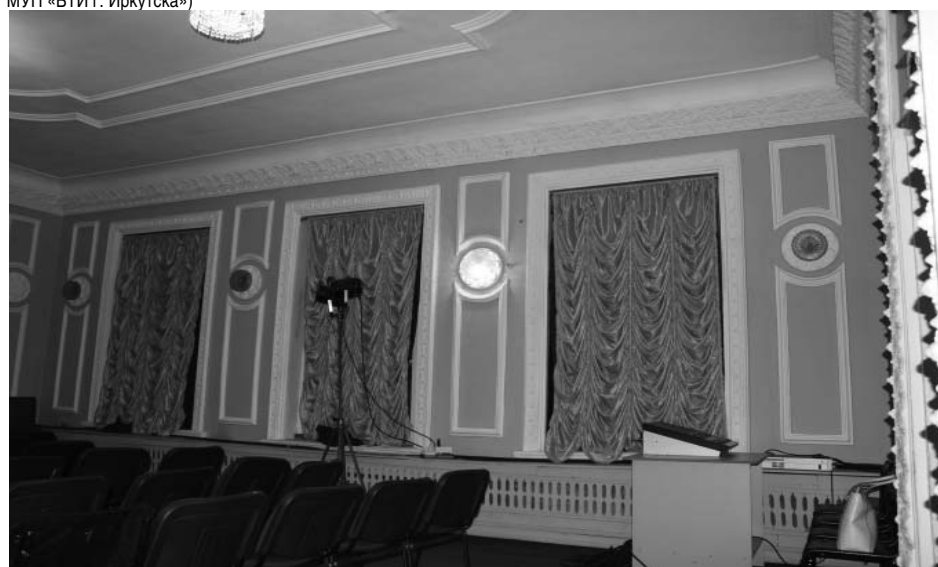
Фото Н.В. Шастун, сентябрь 2018 г. Карниз верх стен с двумя рядами листьев аканта под галтельными тягами в пом. №15 (по плану МУП «БТИ г. Иркутска»)
