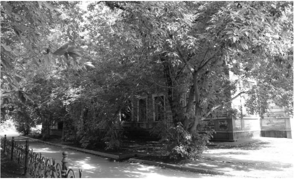
Фото Н.В. Шастун, сентябрь 2018 г. Северо-западный фасад. Вид с западного угла.
