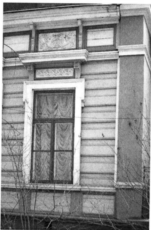
Северо-западный фасад. Наличник окна пристроя.
