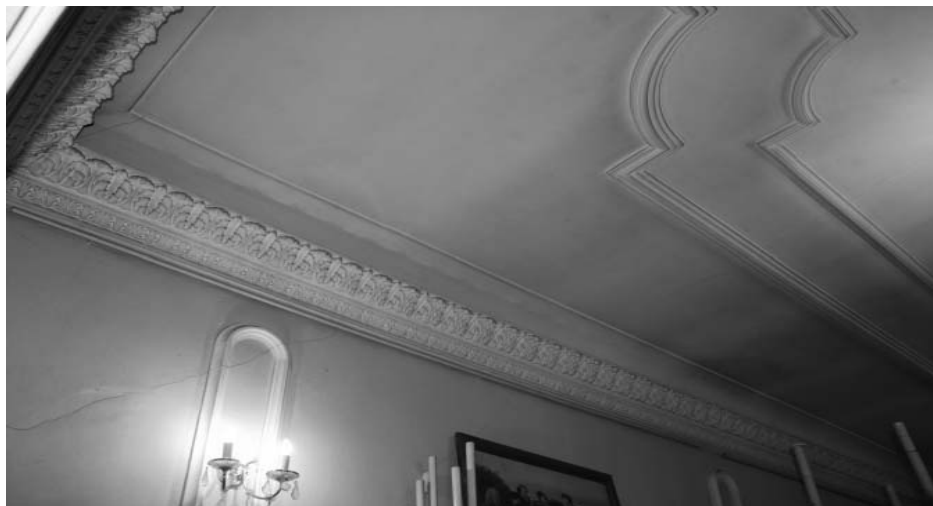
Фото Н.В. Шастун, сентябрь 2018 г. Карниз верх стен под галтельными тягами. Фигурные филенчатые зеркала в пом. №3 (по плану МУП «БТИ г. Иркутска»)
