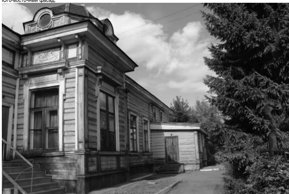
Фото Н.В. Шастун, сентябрь 2018 г. Юго-восточный фасад. Вид с южного угла.
