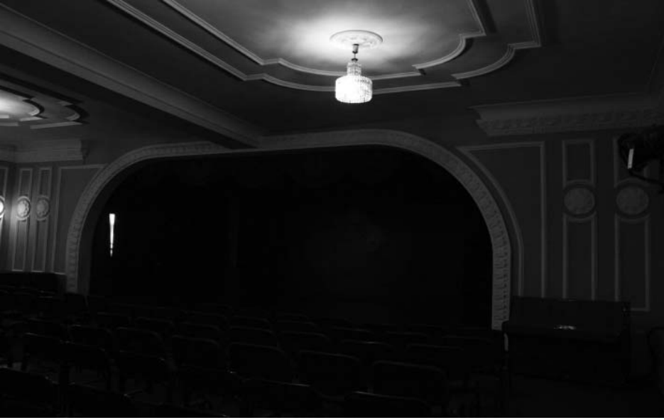
Фото Н.В. Шастун, сентябрь 2018 г. Коробовая арка. Потолочная балка с выкружками в примыкании к потолку. (по плану МУП «БТИ г. Иркутска»)
