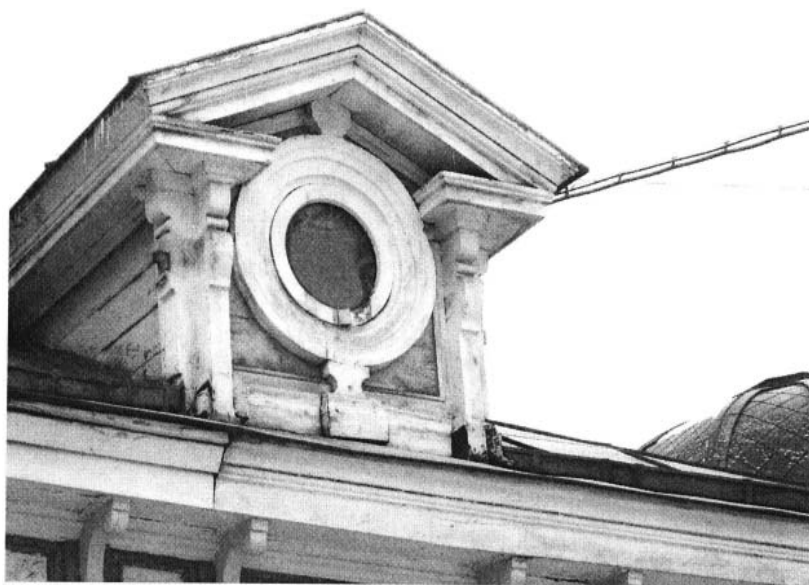
Юго-западный фасад.. Чердачный объем
