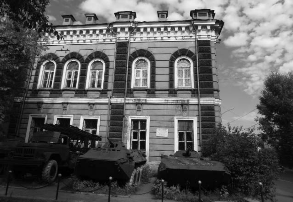
Фото 21 - Боковой юго-западный фасад (фрагмент)
