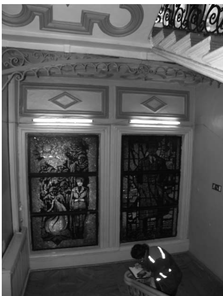
Фото 74 - Второй этаж. Помещение 8
