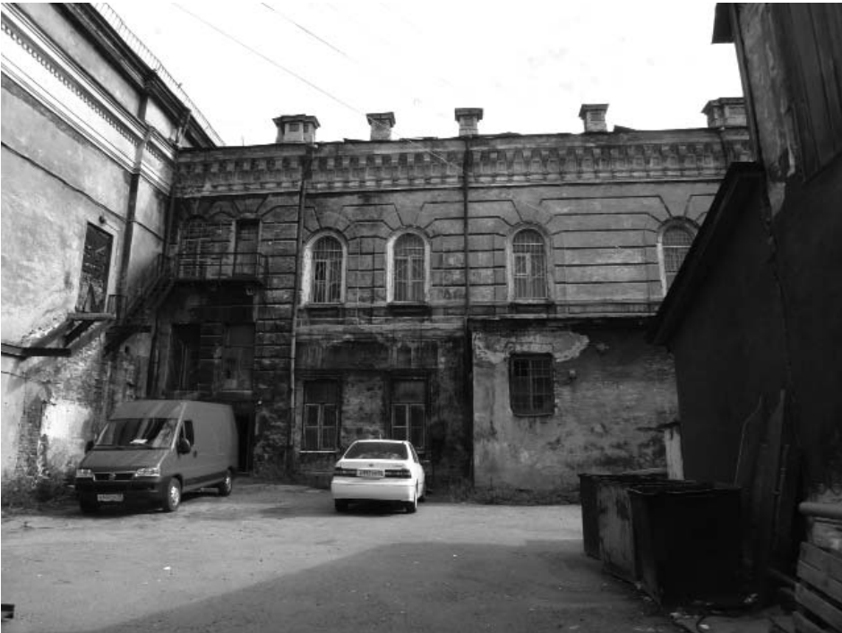
Фото 24 - Дворовый северо-западный фасад (фрагмент)
