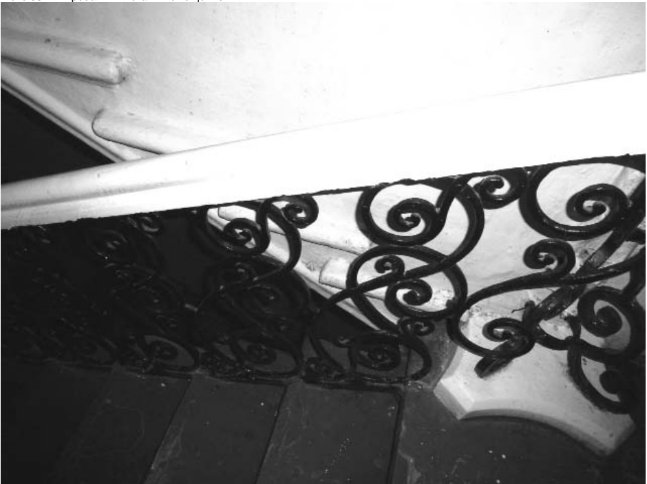
Фото 96 - Антресольный этаж. Помещение 1. Ограждение лестницы
