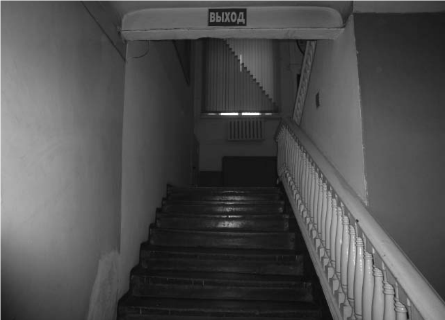
Фото 42 - Лестница из подвала в вестибюль
