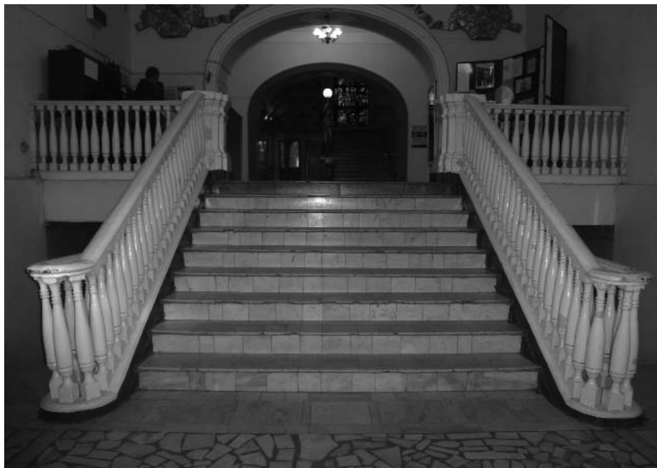
Фото 43 - Первый этаж. Помещение 1. Трехмаршевая лестница
