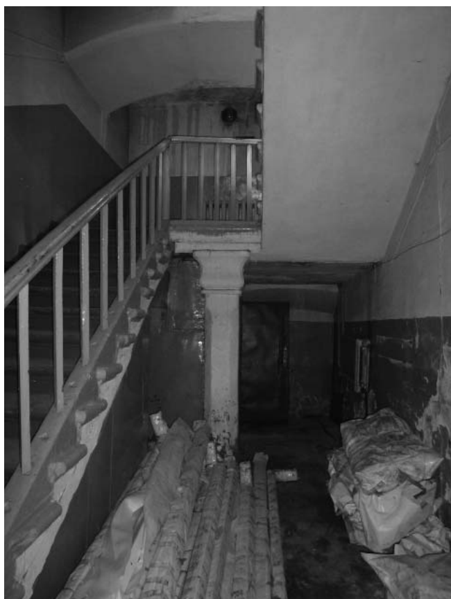
Фото 58 - Первый этаж. Помещение 25 черная лестница
