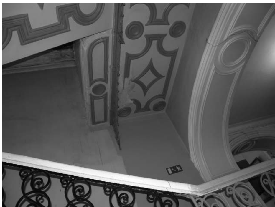
Фото 73 - Второй этаж. Помещение 8
