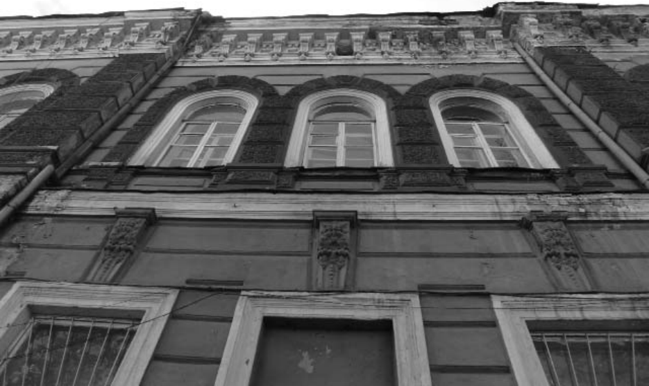
Фото 20 - Окна второго этажа
