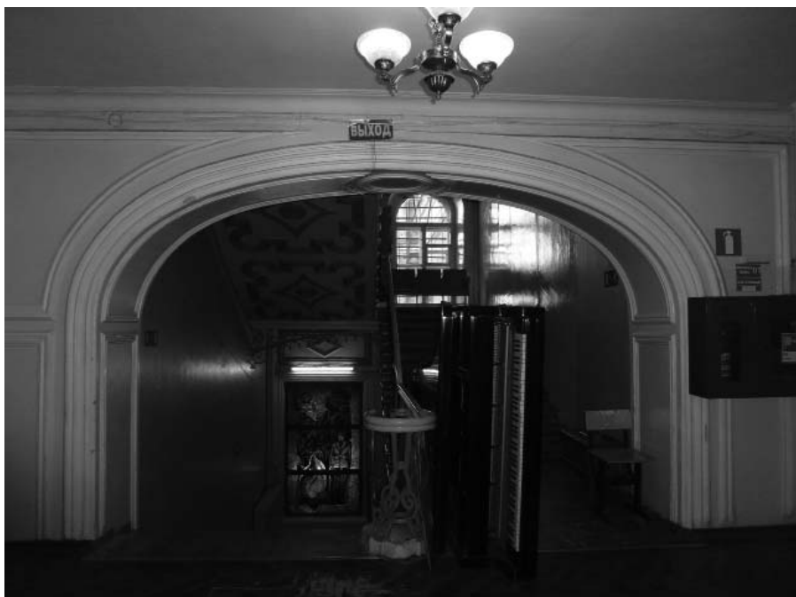
Фото 77 - Второй этаж. Помещение 10. Коробовая арка
