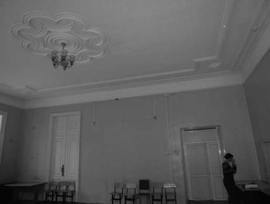
Фото 52 - Первый этаж. Помещение 3
