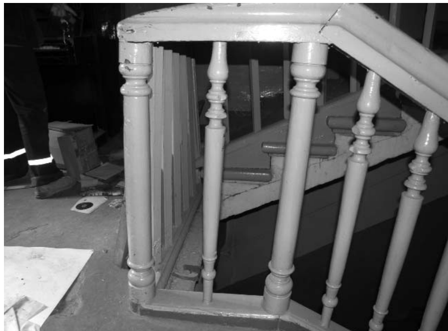
Фото 83 - Второй этаж. Помещение 16. Ограждение черной лестницы
