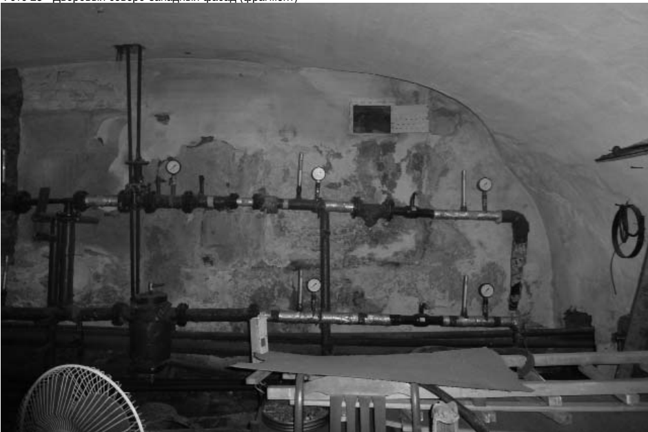
Фото 26 - Подвал. Коробовый свод (пом. 1, 2)
