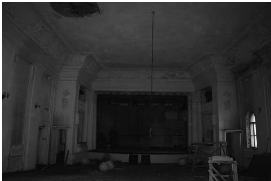
Фото 84 - Второй этаж. Помещение 21. Большой зал
