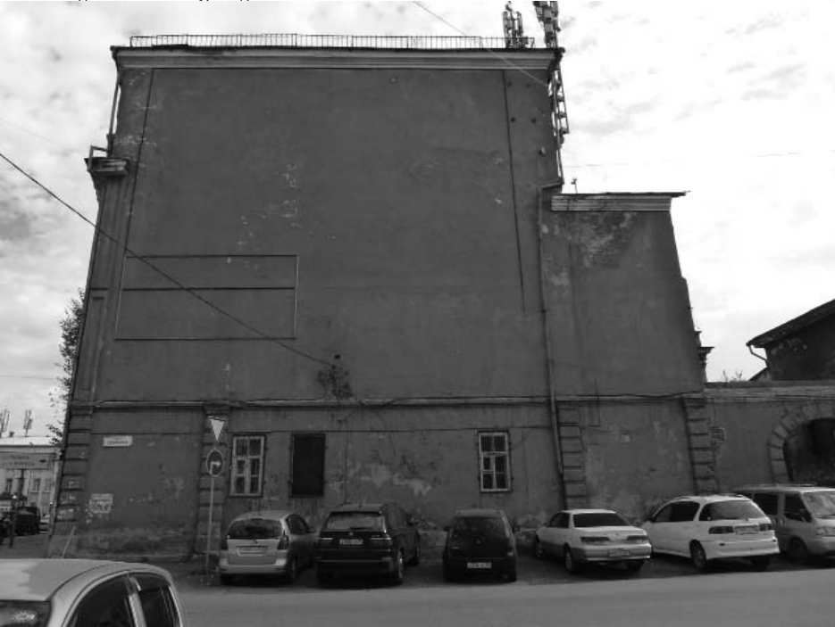
Фото 23 - Фасад по пер. Ударника
