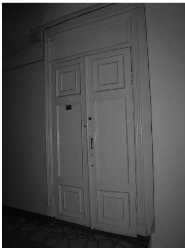
Фото 57 - Первый этаж. Помещение 45. Дверь
