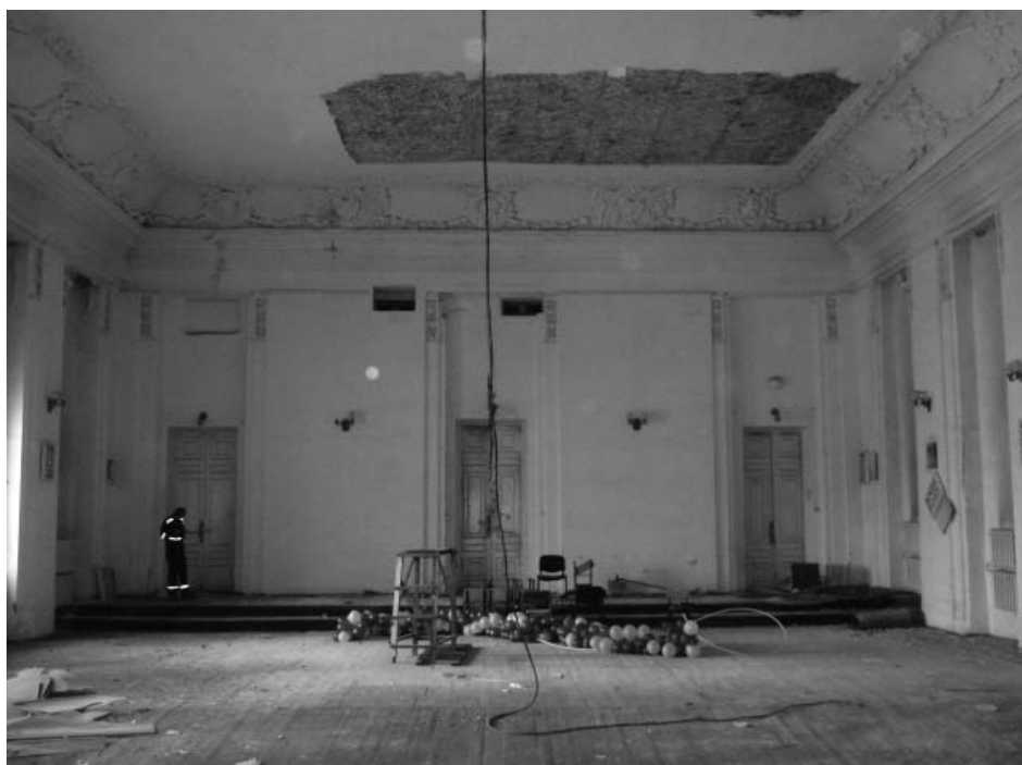
Фото 86 - Второй этаж. Помещение 21. Большой зал
