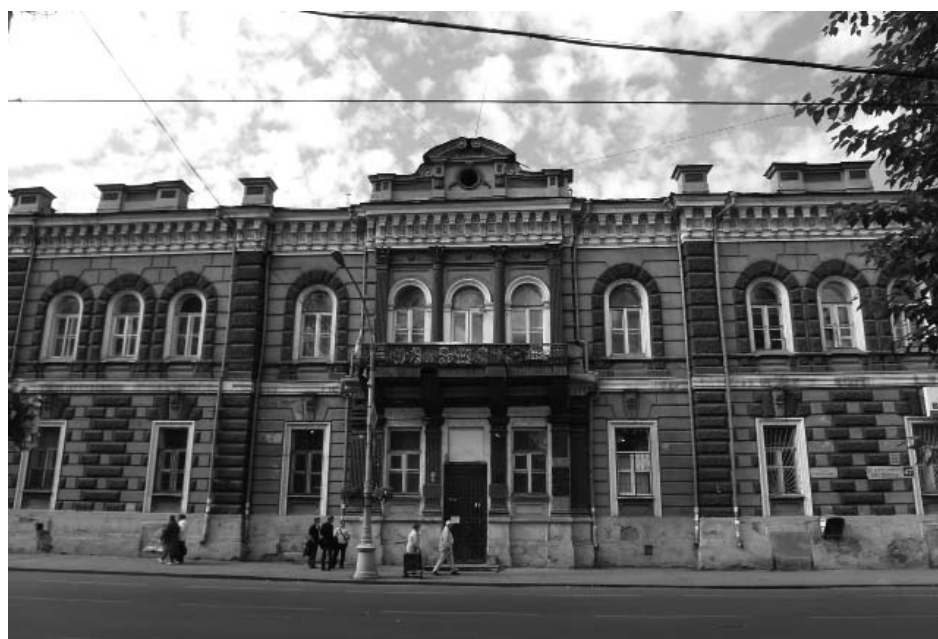
Фото 4 - Главный (юго-восточный) фасад с ул. К.Маркса
