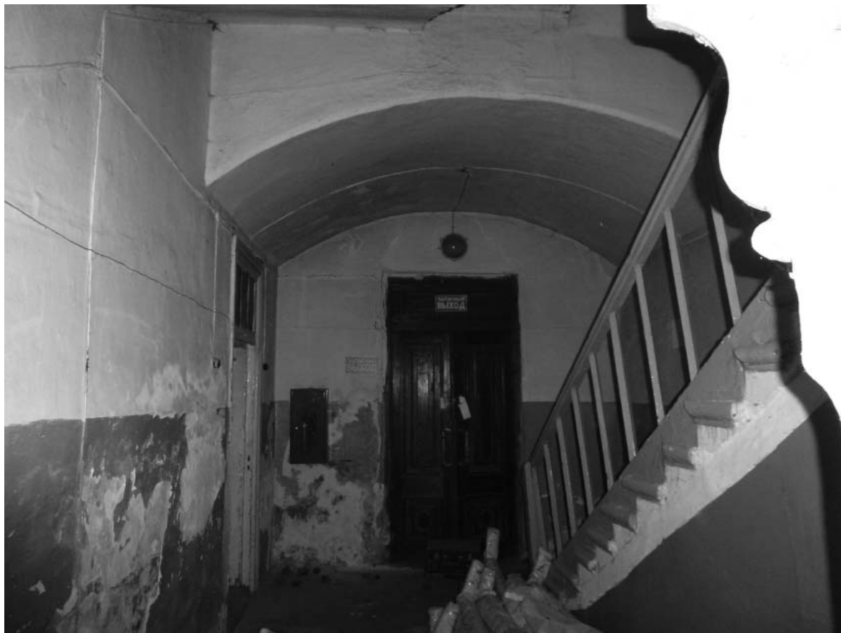
Фото 59 - Первый этаж. Помещение 25
