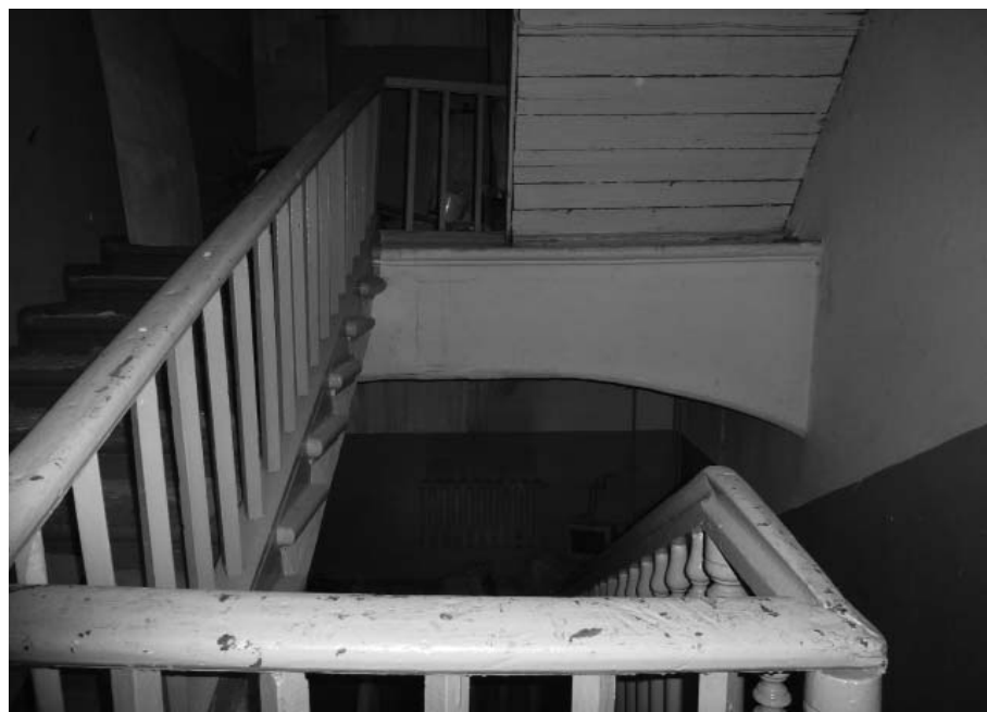
Фото 82 - Второй этаж. Помещение 16 черная лестница
