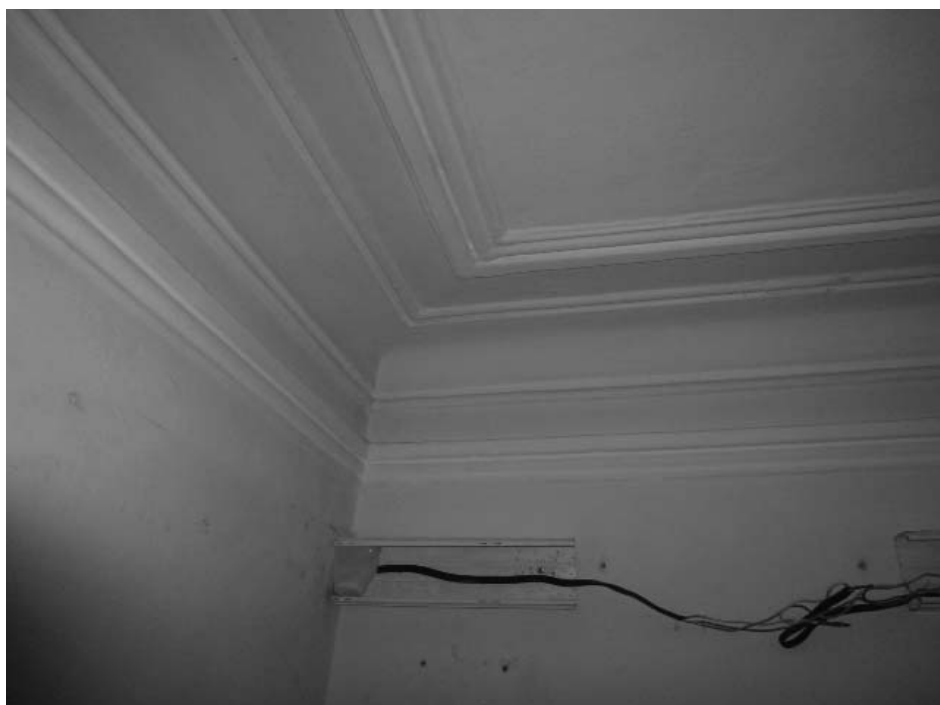
Фото 98 - Антресольный этаж. Помещение 2. Галтель потолка
