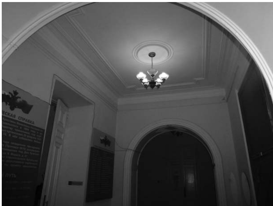
Фото 49 - Первый этаж. Помещения 16, 18
