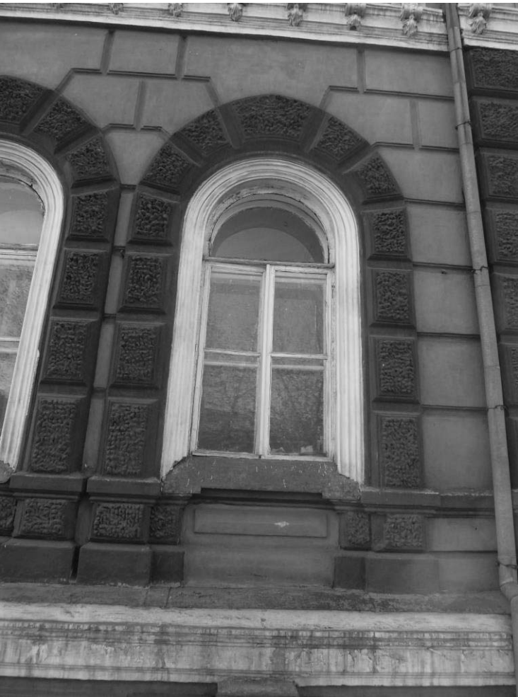
Фото 9 - Окно второго этажа
