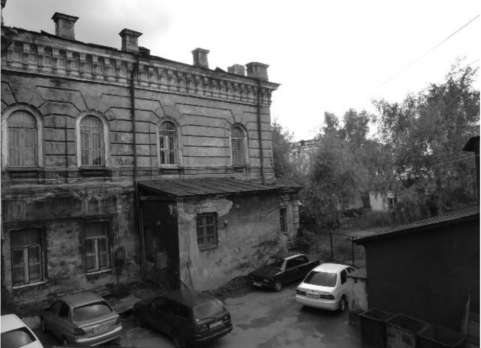
Фото 25 - Дворовый северо-западный фасад (фрагмент)
