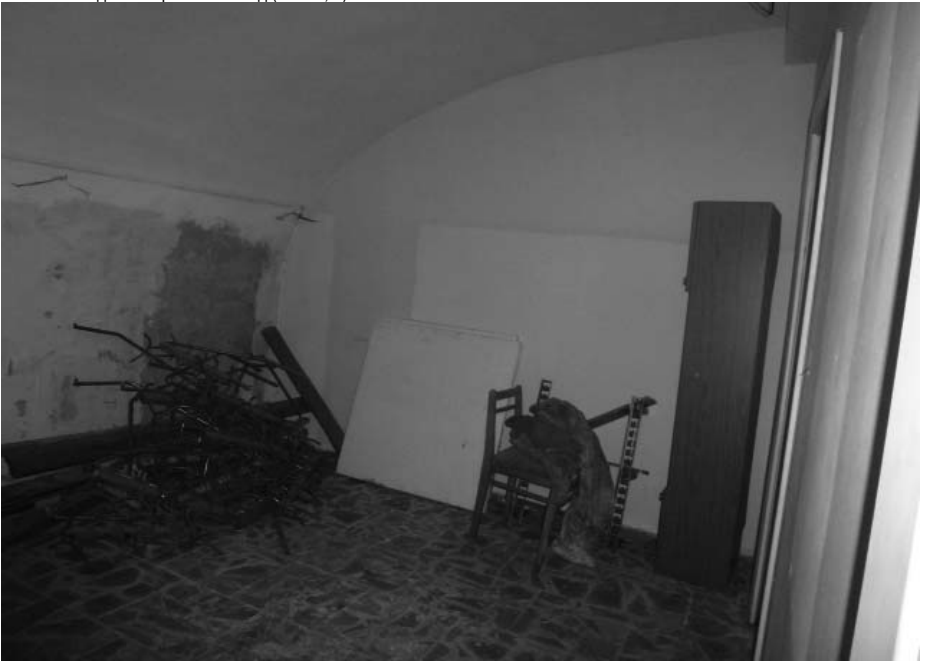
Фото 27 - Подвал. Коробовый свод (пом. 3, 4, 5, 6)
