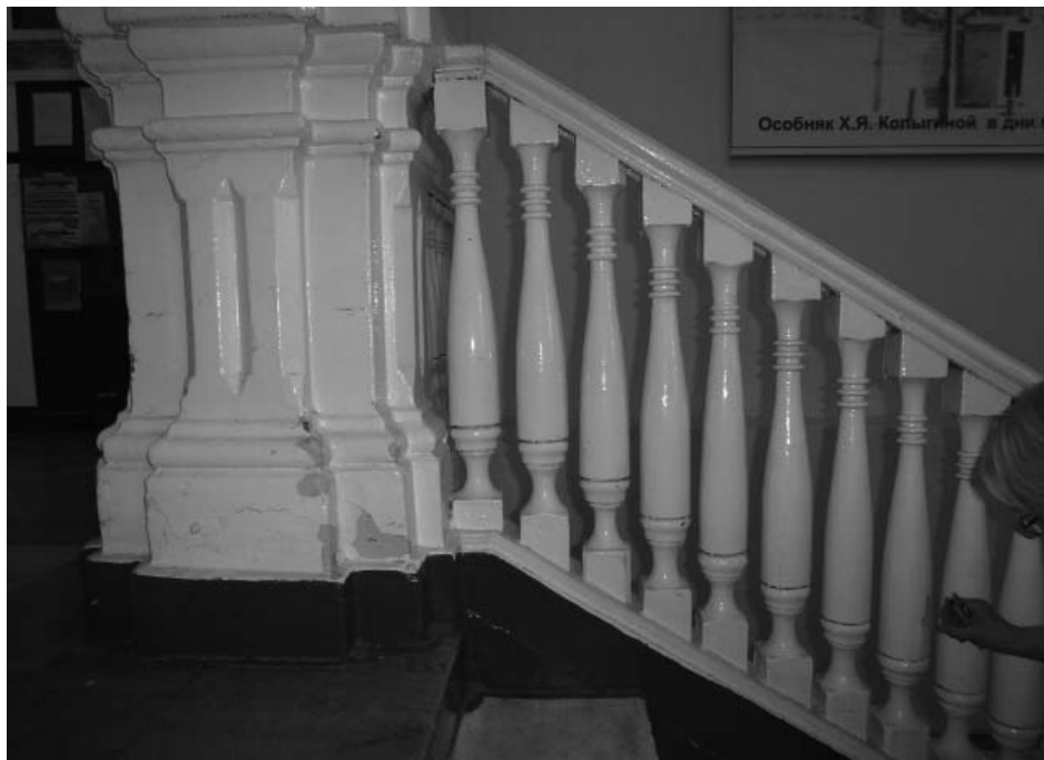
Фото 44 - Первый этаж. Помещение 1. Ограждение лестницы
