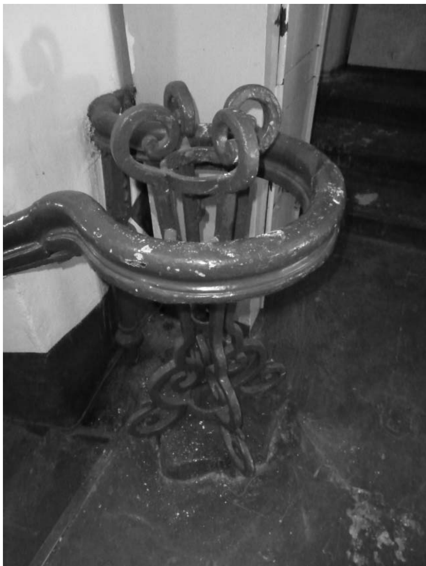
Фото 97 - Антресольный этаж. Помещение 1. Перила ограждения
