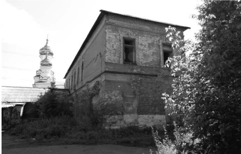
Фото Н.В. Шастун, август 2018 г. (Лит. К) Вид на здание с северо-восточного угла.
