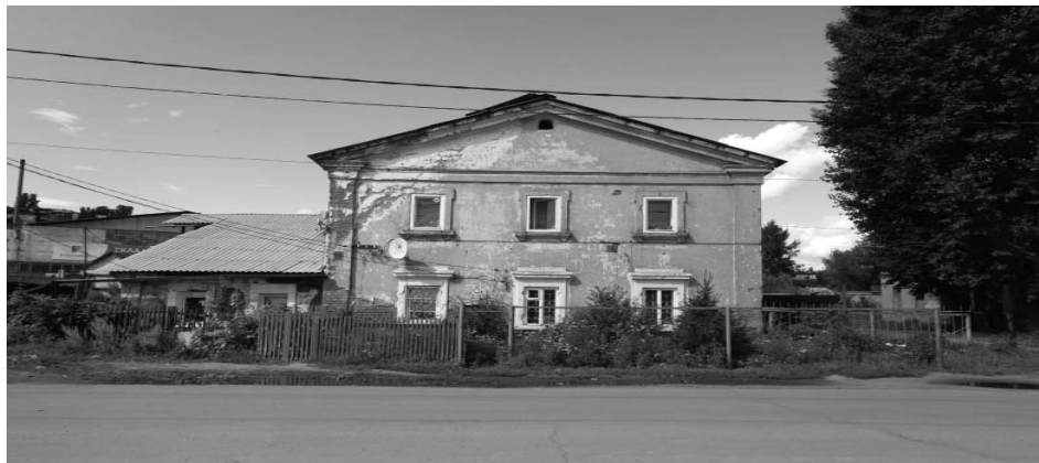
Фото Н.В. Шастун, август 2018 г. (Лит. А) Главный (южный) фасад.
