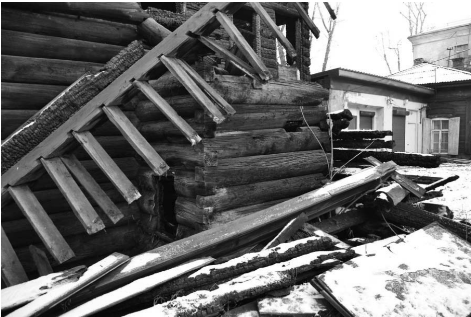
Фото 17 - Сохранившаяся часть прируба юго-западного фасада. 2017 г.
