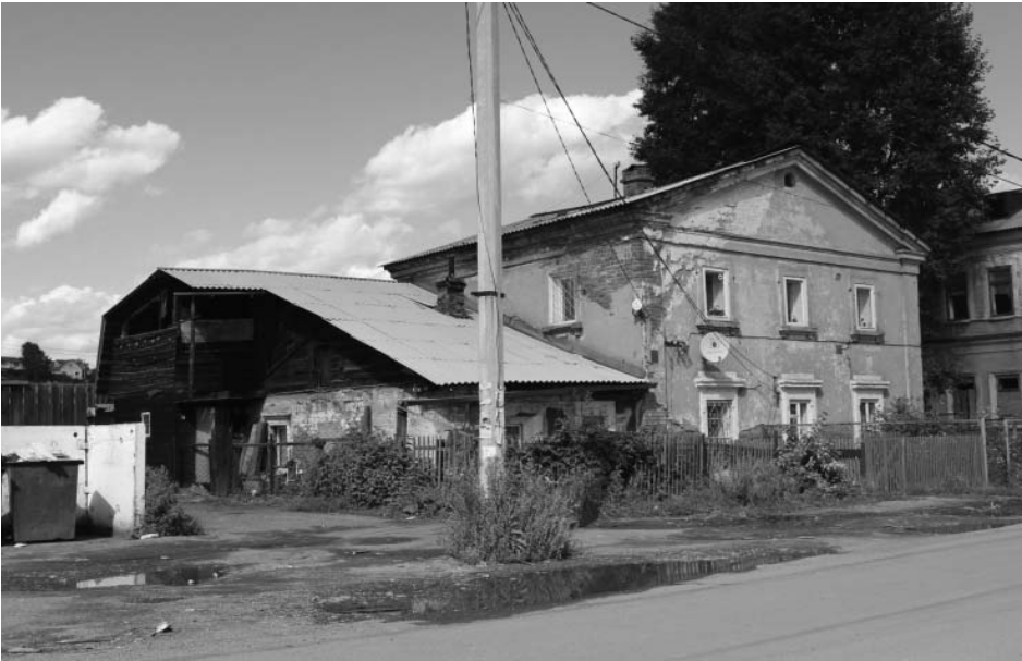
Фото Н.В. Шастун, август 2018 г. (Лит. А) Общий вид здания с юго-западного угла.
