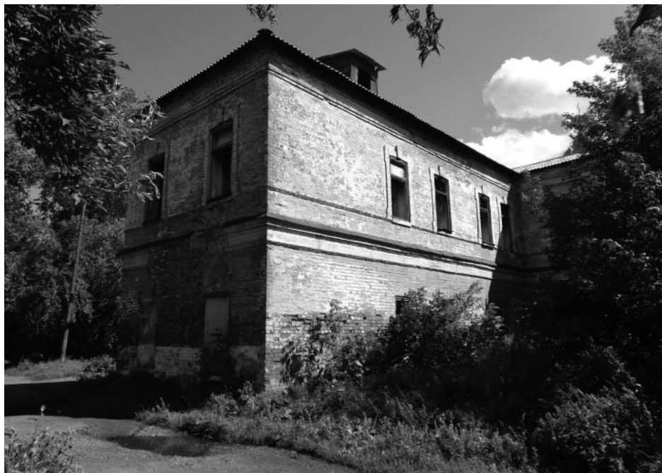
Фото Н.В. Шастун, август 2018 г. (Лит. К) Вид на здание с северо-западного угла.
