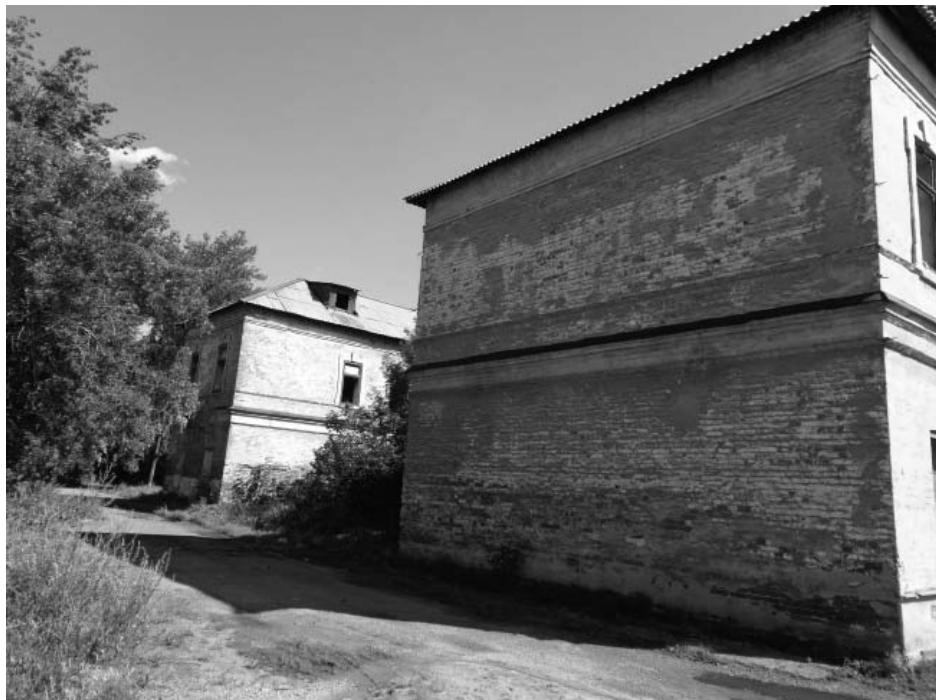
Фото Н.В. Шастун, август 2018 г. (Лит. К) Вид на здание с северо-западного угла.
