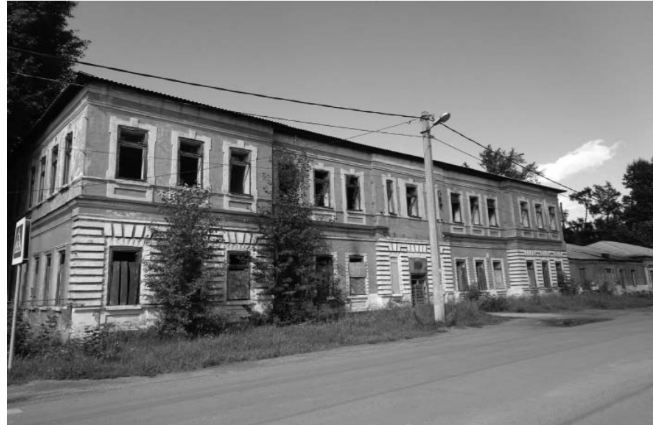
Фото Н.В. Шастун, август 2018 г. (лит. К) Главный (южный) фасад.
