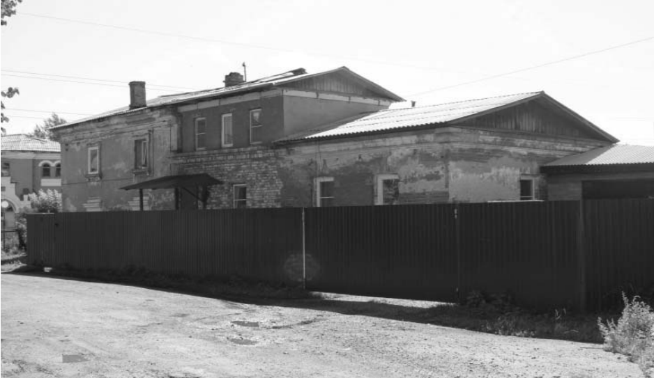
Фото Н.В. Шастун, август 2018 г. (Лит. А) Общий вид здания с северо-восточного угла.
