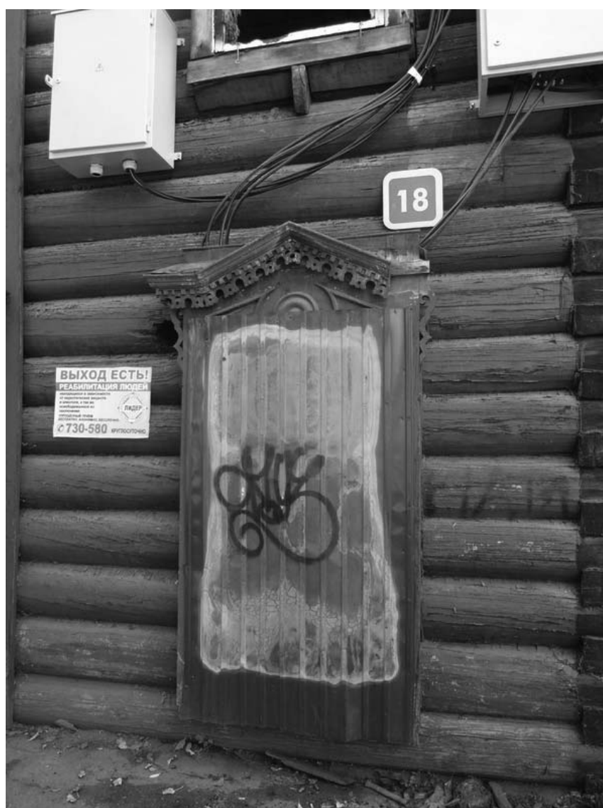
Фото 15 - Наличник первого этажа главного фасада. 2017 г.
