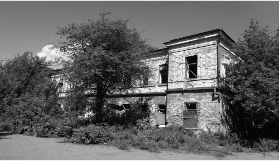
Фото Н.В. Шастун, август 2018 г. (Лит. Ж) Западный фасад.
