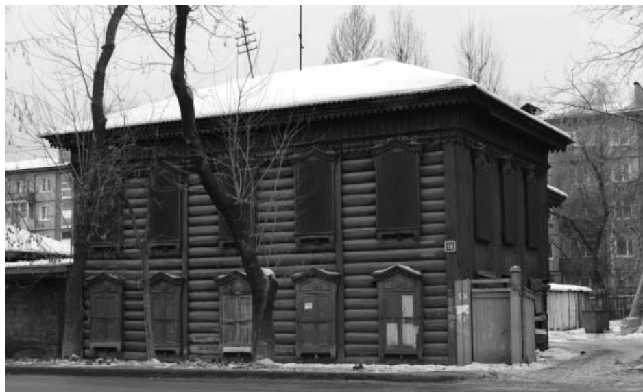
Фото 8 - Северо-восточный фасад. 2012 г.
