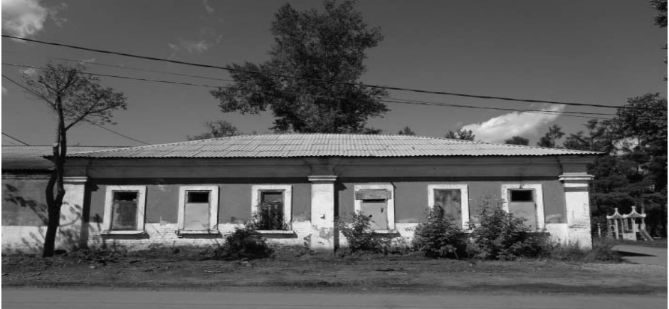
Фото Н.В. Шастун, август 2018 г. (Лит. З) Главный (южный) фасад.
