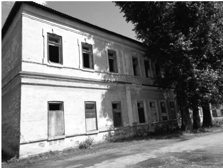
Фото Н.В. Шастун, август 2018 г. (лит. К) Западный фасад. Вид с северо-западного угла.
