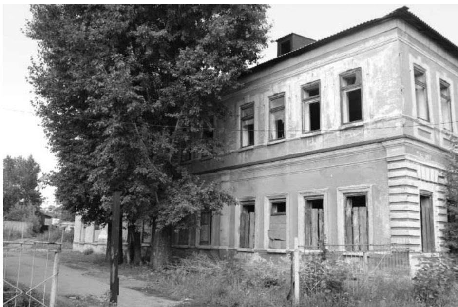
Фото Н.В. Шастун, август 2018 г. (лит. К) Западный фасад. Вид с юго-западного угла.
