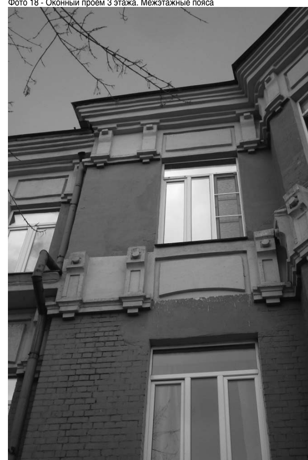
Фото 19 - Фрагмент главного фасада, ризалит. Карниз междуэтажного пояса 2 и 3 этажей сбит1
