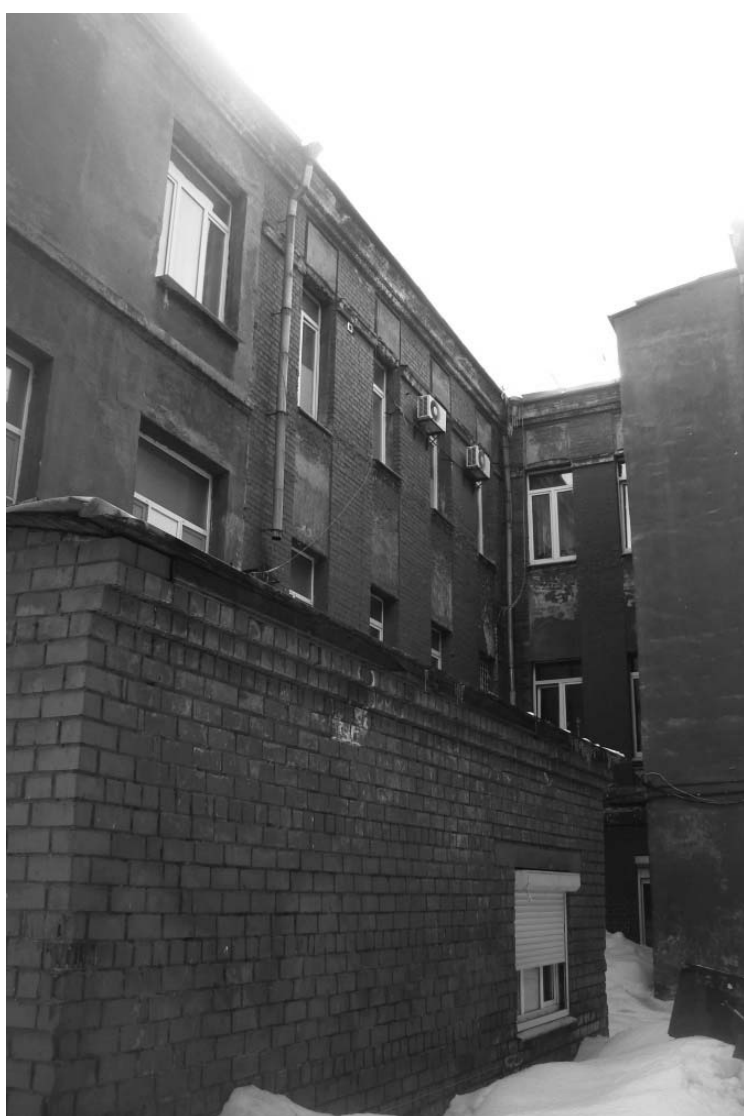
Фото 9 - Боковой (северо-восточный) фасад главного корпуса
