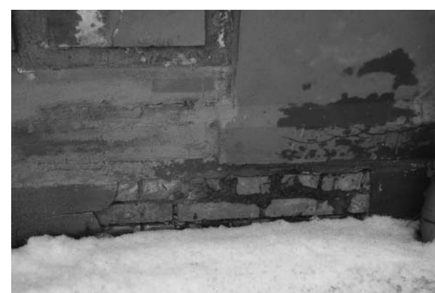
Фото 20 - Цоколь на дворовом фасаде. Деструкция лицевого слоя позволяет увидеть кирпичную кладку цоколя1
