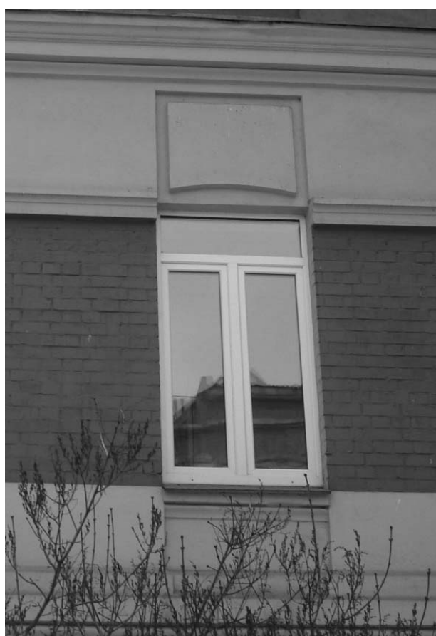
Фото 17 - Оконный проем 2 этажа. Межэтажные пояса
