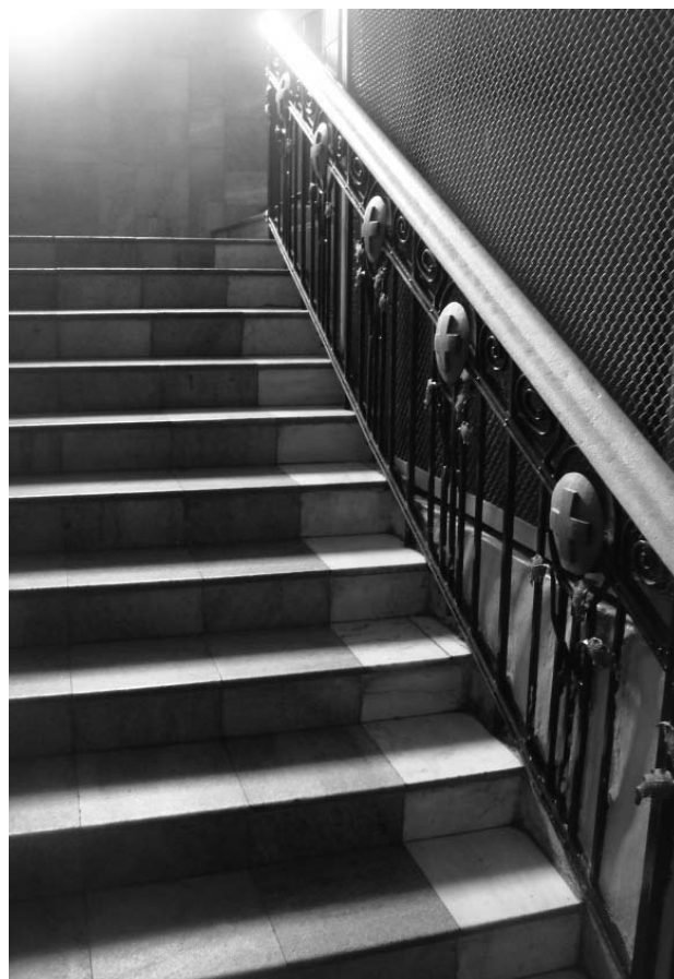
Фото 27 - Фрагмент трёхмаршевой лестницы в пом. №44
