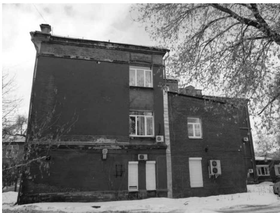
Фото 13 - Юго-восточный фасад главного корпуса
