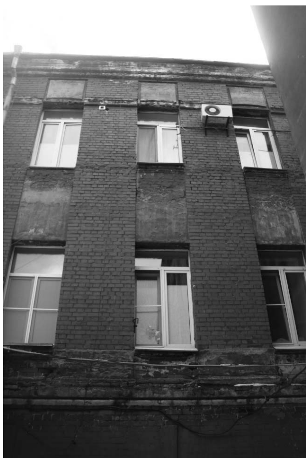
Фото 22 - Фрагменты дворовых фасадов главного корпуса: деструкция штукатурного слоя
