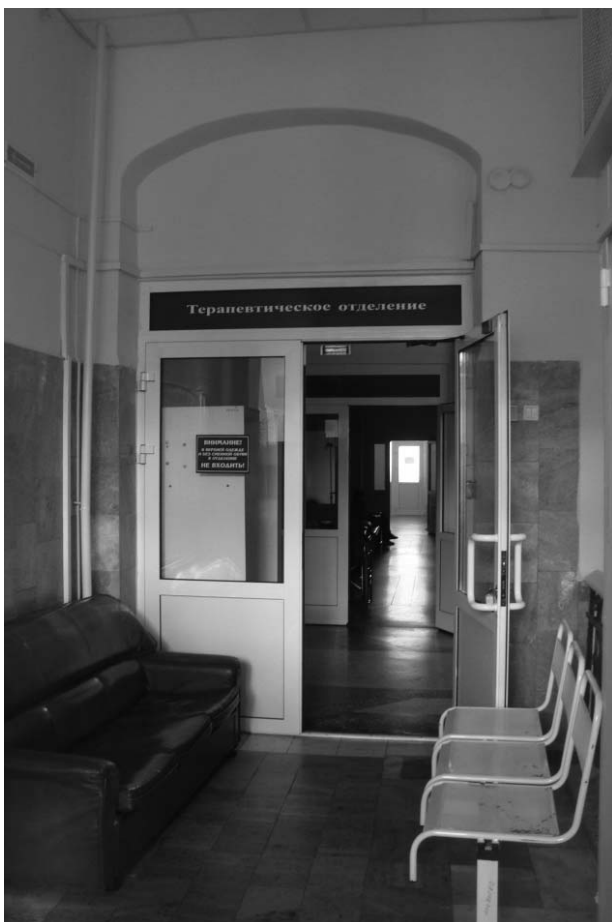
Фото 24 - Арочный проем в пом. №44 1 этажа
