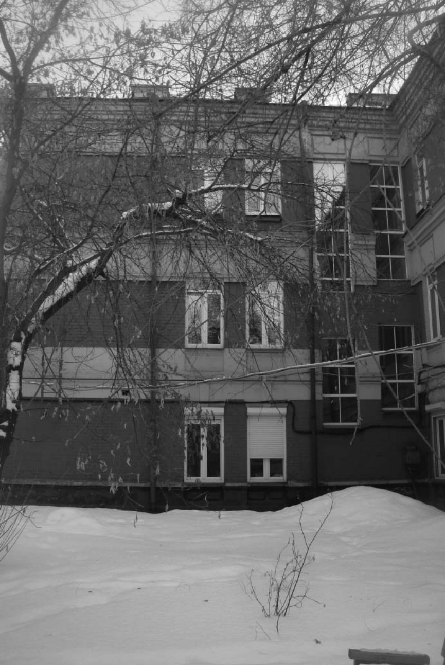
Фото 6 - Фрагмент бокового (северо-западного) фасада1
