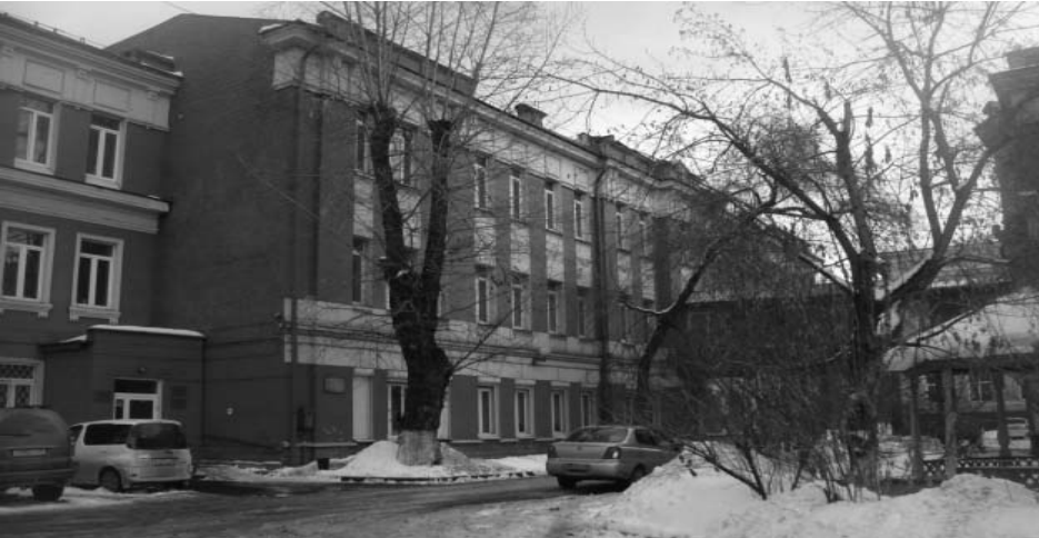
Фото 2 - Фрагмент главного (юго-западного) фасада главного корпуса
