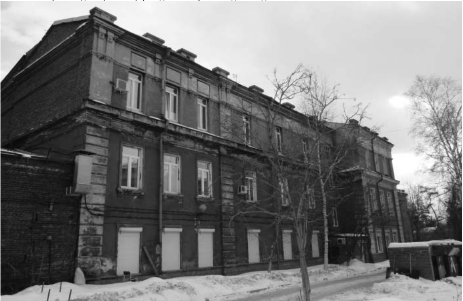
Фото 5 - Фрагмент бокового (северо-западного) фасада. Вид с севера
