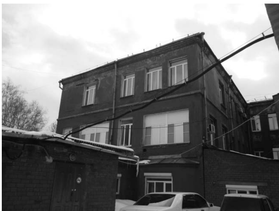
Фото 10 - Северо-восточный фасад дворового крыла. Эркер в 1 этаже
