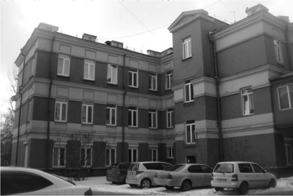
Фото 9 - Общий вид на здание с востока
