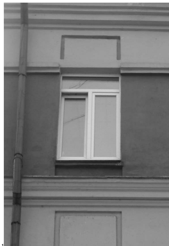
Фото 18 - Оконный проем 3 этажа. Межэтажные пояса
