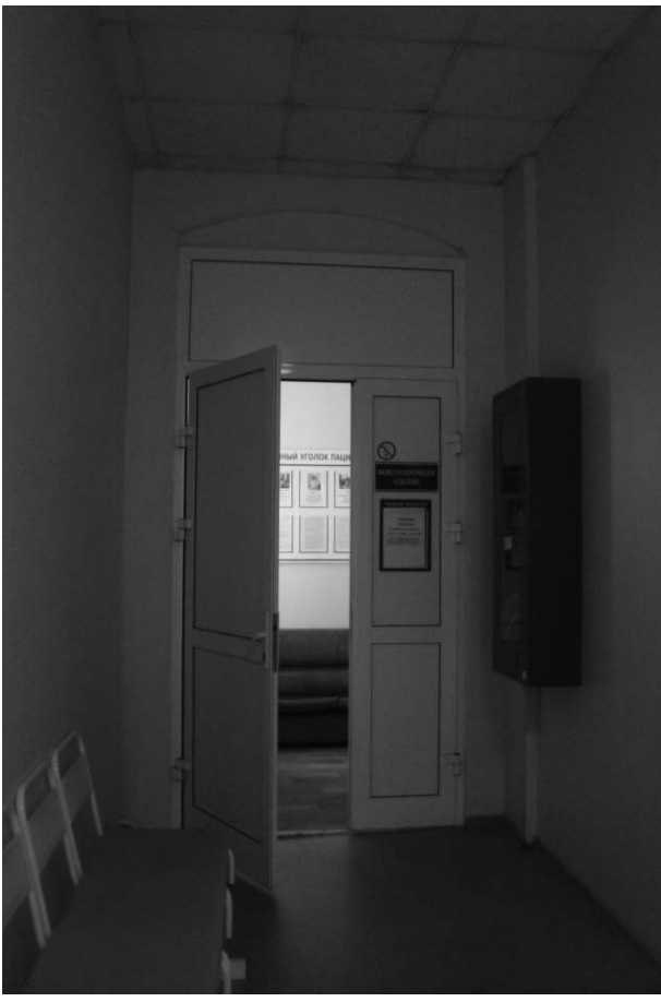
Фото 23 - Арочный проем в пом. №10 1 этажа
