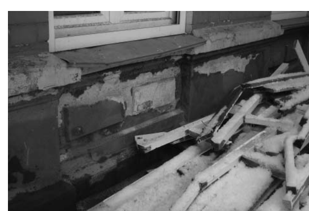
Фото 19 - Фрагмент главного фасада, ризалит. Карниз междуэтажного пояса 2 и 3 этажей сбит1
