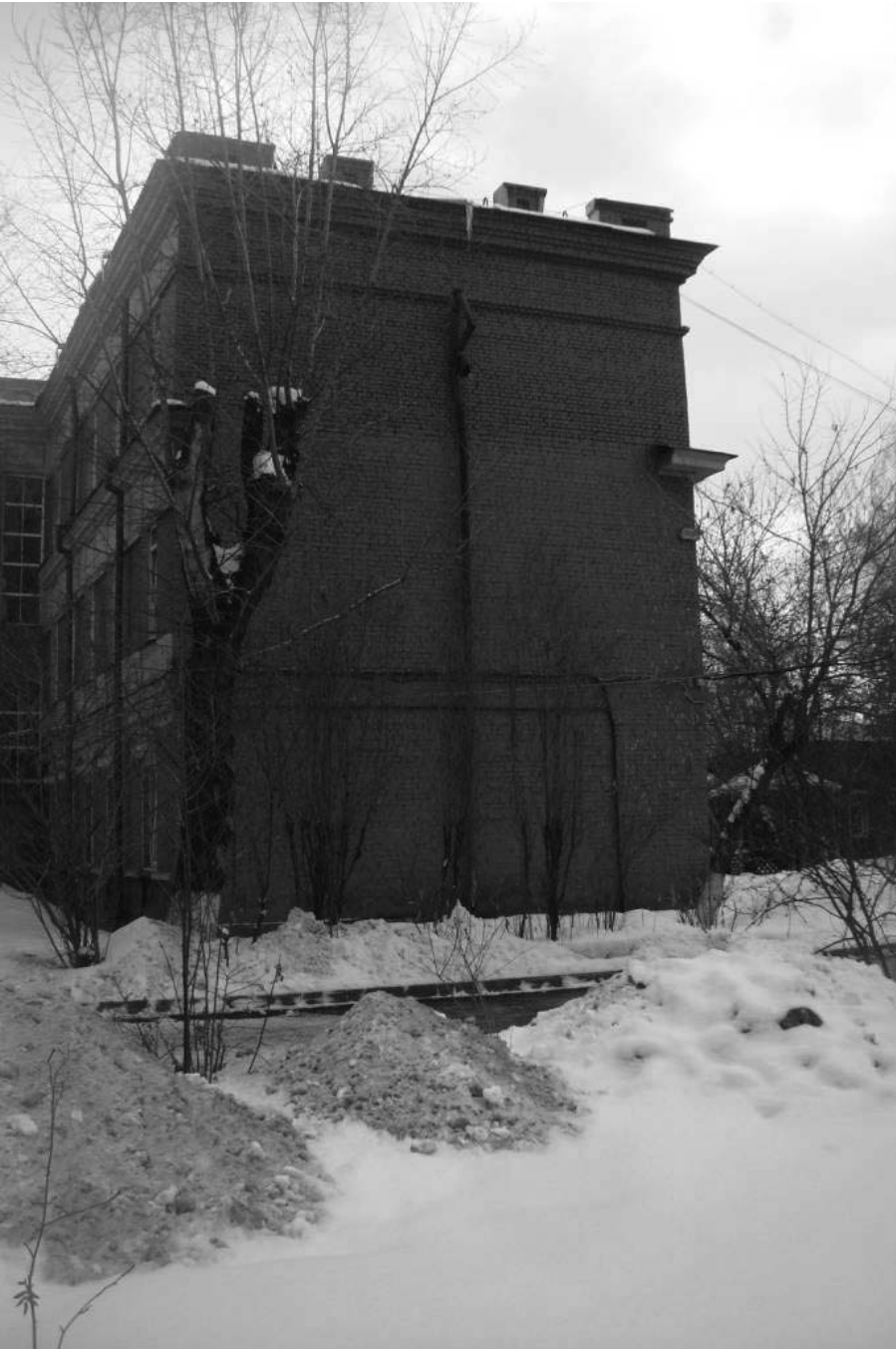
Фото 7 - Фрагмент бокового (северо-западного) фасада
