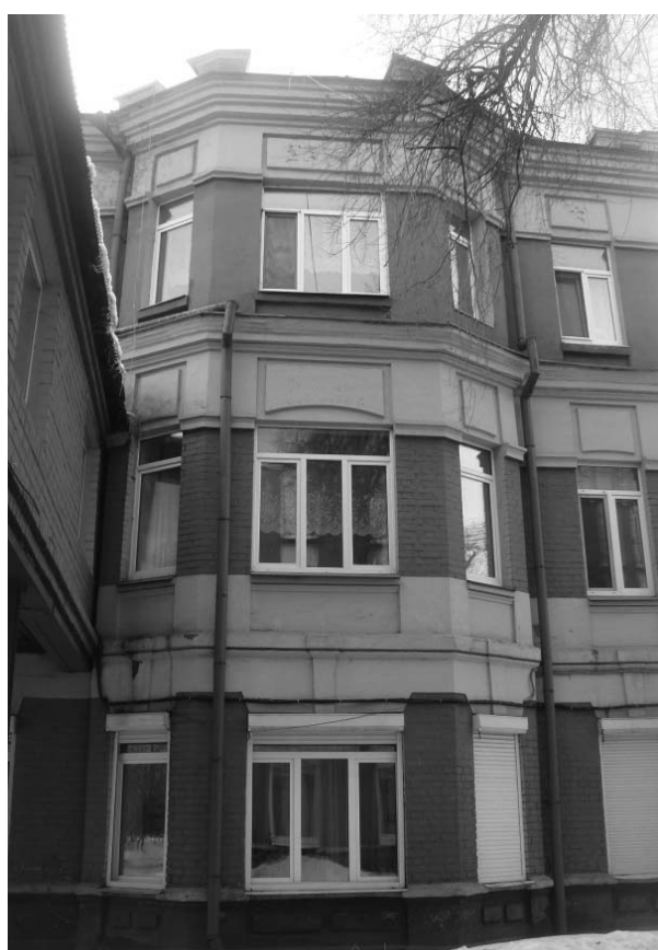
Фото 14 - Эркер по центральной оси дворового фасада 1
