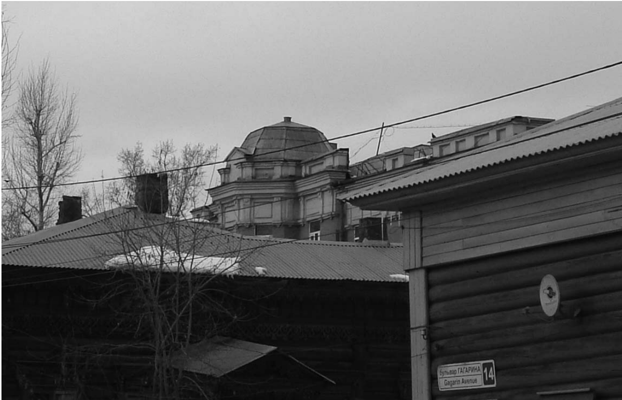
Фото 21 - Купол над эркером главного фасада. Аттиковые стенки
