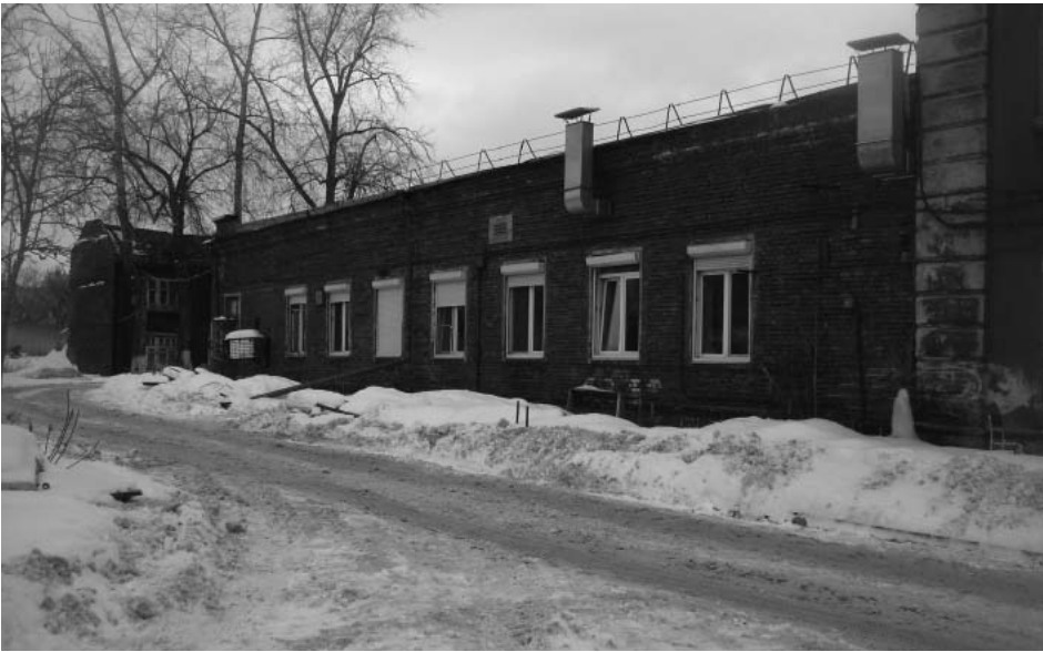
Фото 6 - Фрагмент северо-западного фасада. Крыло 1938 г. постройки
