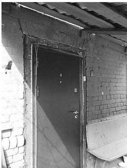
Фото 12. Входной пристрой. Дверной проем
