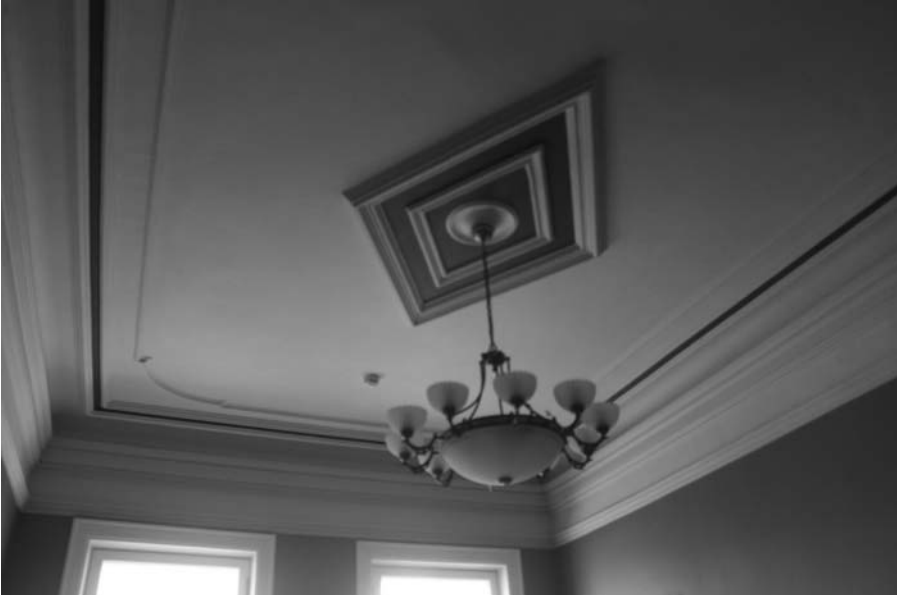
Фото А.А. Жильцов, июнь 2018 г. Лит. А.Декоративные сложно профилированные потолочные и карнизные настенные тяги, образующие угловое сопряжение в виде падуги; потолочная розетка в пом. № 5 (по плану МУП «БТИ г. Иркутска») на 2 этаже.
