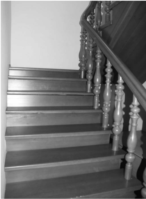
Фото А.А. Жильцов, июнь 2018 г. Лит. А. Ограждение лестницы на второй этаж в виде деревянного балясника с угловыми столбиками, вид из пом. № 8 (по плану МУП «БТИ г. Иркутска») на 1 этаже
