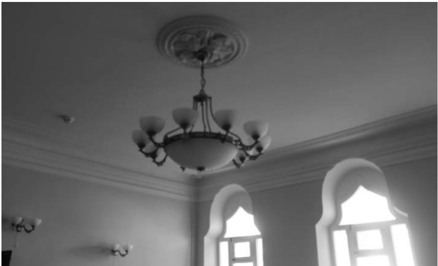
Фото А.А. Жильцов, июнь 2018 г. Лит. А. Профилированные гипсовые тяги по потолку и карнизу стен, потолочная розетка в пом. № 2 (по плану МУП «БТИ г. Иркутска») на 1 этаже.
