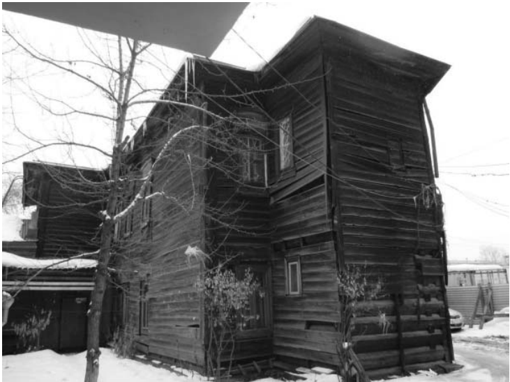
Фото 5. Дворовый (юго-западный) фасад основного объема
