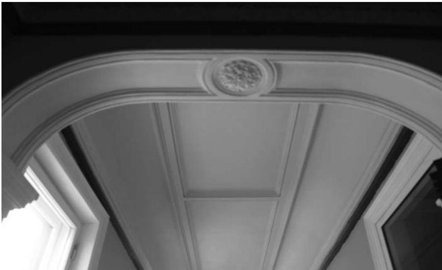
Фото А.А. Жильцов, июнь 2018 г. Лит. А. Аркикоробовой формы, украшенные по внутреннему своду профилированными тягами и центральной розеткой в виде цветка в пом. № 1 (по плану МУП «БТИ г. Иркутска») на 2 этаже.
