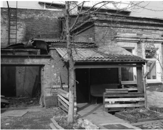
Фото 10. Входной пристрой. Юго-восточный фасад
