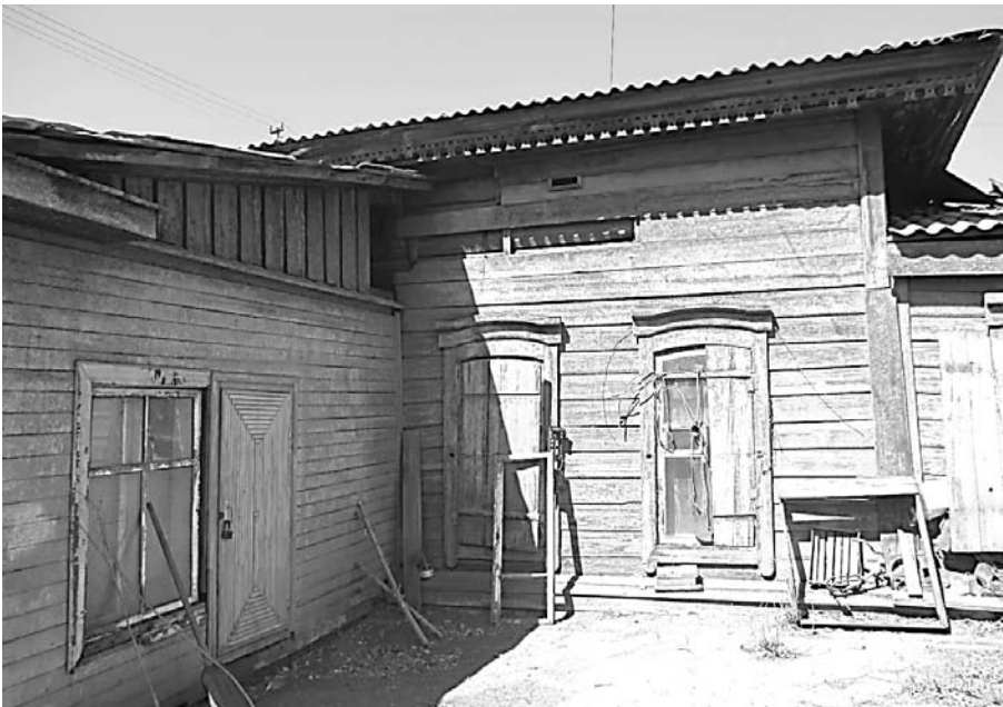
Фото 9 - Фрагмент бокового (юго-восточного) фасада основного объема лечебницы (лит. А, А1, А2) и северо-восточного фасада позднего входного пристроя
