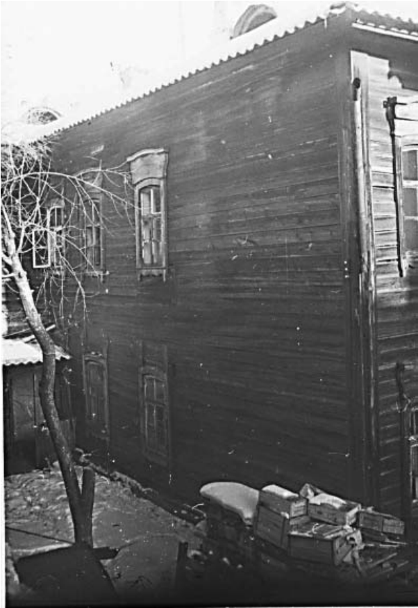
Фото 9. Боковой (северо-западный) фасад основного объема. Архив ЦСН
