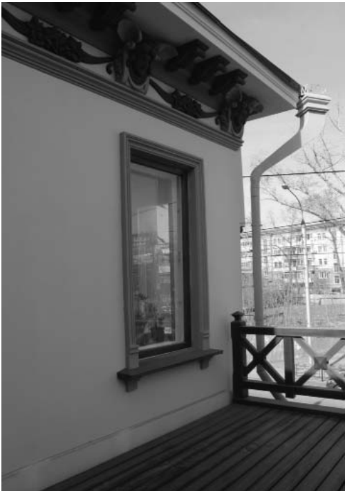
Фото А.А. Жильцов, июнь 2018 г. Лит. А. Фрагмент юго-восточного фасада, вид с балкона-галереи вдоль части фасада.
