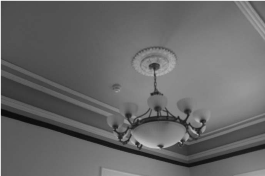
Фото А.А. Жильцов, июнь 2018 г. Лит. А.Профилированные тяги по потолку; профилированные тяги по верху стен; потолочная розетка в пом. № 10 (по плану МУП «БТИ г. Иркутска») на 2 этаже.
