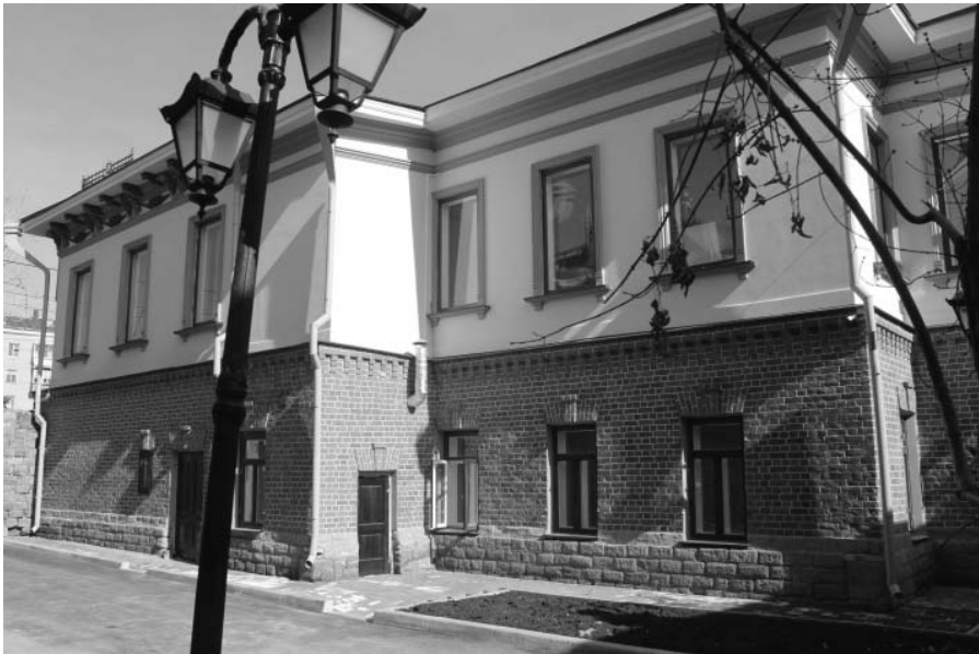
Фото А.А. Жильцов, июнь 2018 г. Лит. А. Северо-западный фасад.
