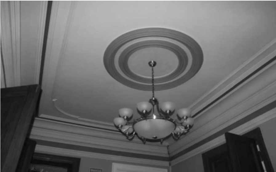
Фото А.А. Жильцов, июнь 2018 г. Лит. А.Декоративные сложно профилированные потолочные и карнизные настенные тяги, образующие угловое сопряжение в виде падуги; потолочная розетка в пом. № 4 (по плану МУП «БТИ г. Иркутска») на 2 этаже.
