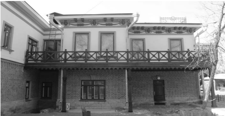
Фото А.А. Жильцов, июнь 2018 г. Лит. А. Фрагмент юго-восточного фасада.
