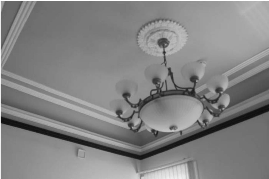
Фото А.А. Жильцов, июнь 2018 г. Лит. А.Профилированные тяги по потолку; профилированные тяги по верху стен; потолочная розетка в пом. № 12 (по плану МУП «БТИ г. Иркутска») на 2 этаже.
