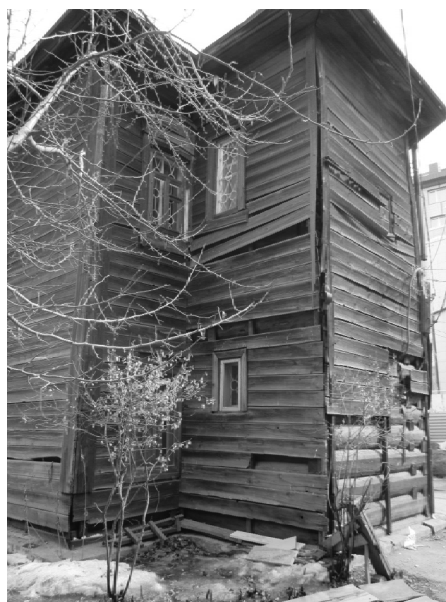
Фото 17. Дворовый разновысокий прируб со скошенным углом. Северо-западный фасад
