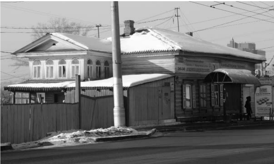
Фото 5 - Общий вид с юго-восточного угла
