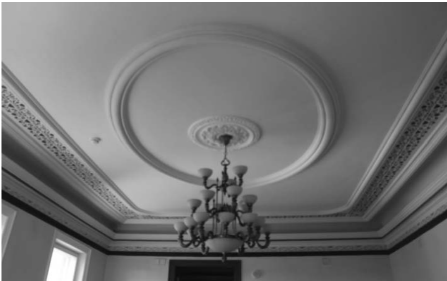
Фото А.А. Жильцов, июнь 2018 г. Лит. А. Декоративные сложно профилированные потолочные и карнизные настенные тяги, образующие угловое сопряжение в виде падуги; трафаретный потолочный орнамент; центральная потолочная розетка сложного рисунка в пом. № 16 (по плану МУП «БТИ г. Иркутска») на 2 этаже.
