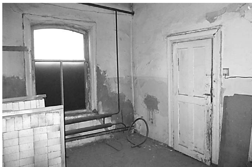
Фото 20 - Фрагменты интерьера пониженного прируба. Наличники оконных и дверных проемов.
