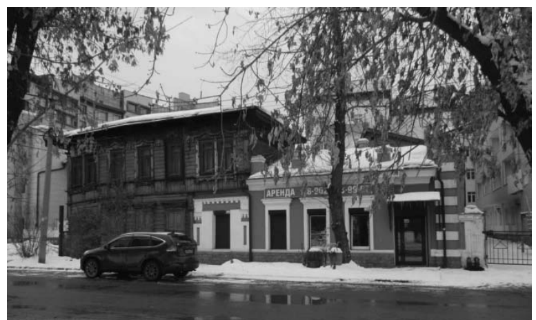
Фото 1. Главный (юго-восточный) фасад. Общий вид
