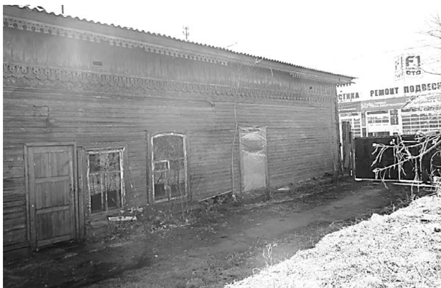
Фото 17 - Боковой (северо-западный) фасад здания лечебницы (лит. А, А1, А2). Основной объем лечебницы
