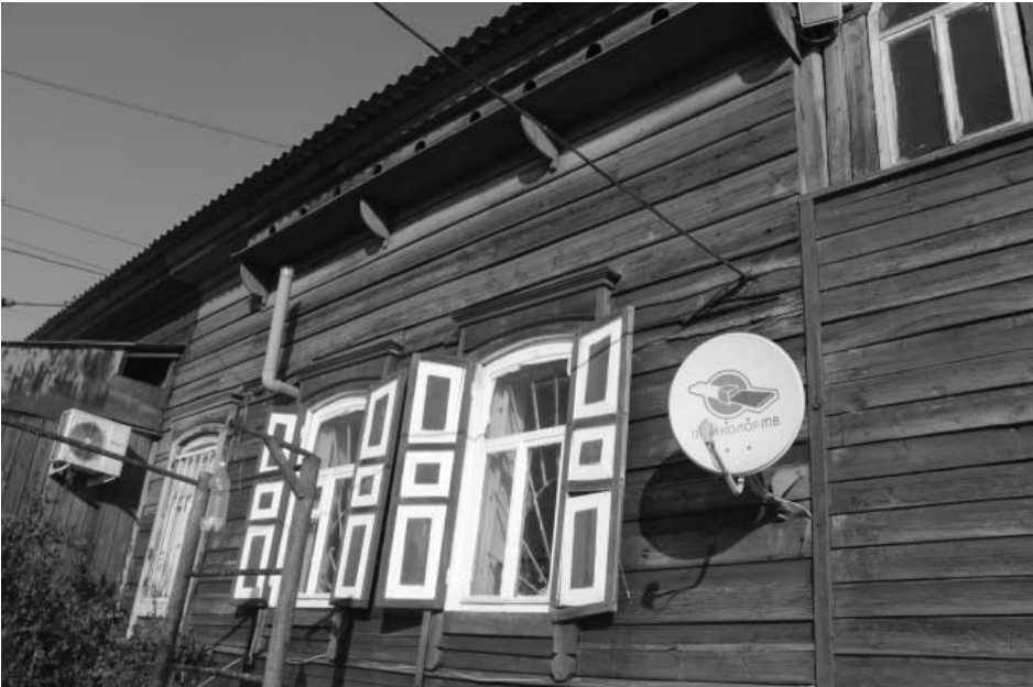
Фото 3 - Фрагмент юго-западного фасада
