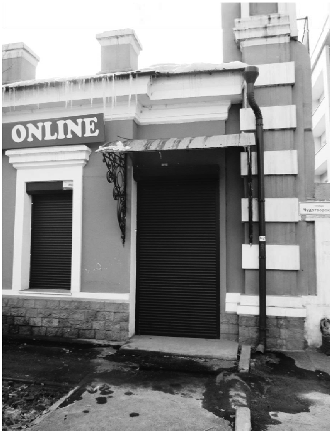
Фото 5. Главный (юго-восточный) фасад основного объема. Парадный вход
