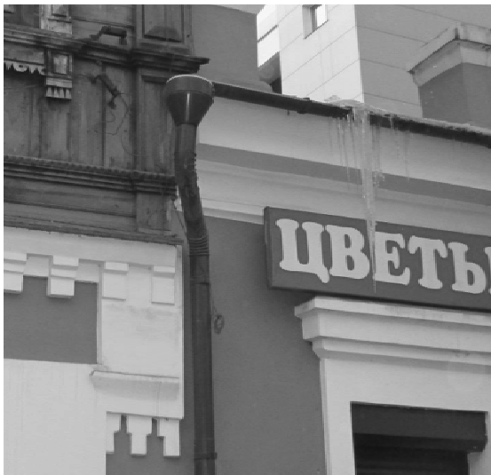
Фото 4. Главный (юго-восточный) фасад основного объема. Карниз, фриз лавки
