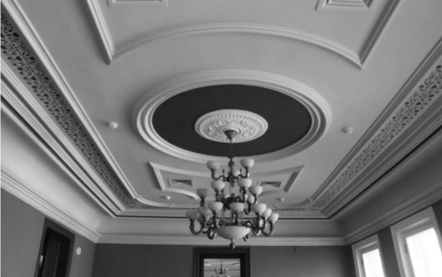
Фото А.А. Жильцов, июнь 2018 г. Лит. А.Зеркальная дверь; декоративные сложно профилированные потолочные и карнизные настенные тяги, образующие угловое сопряжение в виде падуги; трафаретный потолочный орнамент; центральная потолочная розетка сложного рисунка в пом. № 3(по плану МУП «БТИ г. Иркутска») на 2 этаже.
