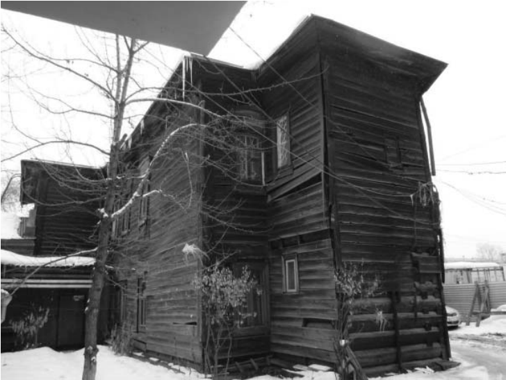
Фото 4. Дворовый (юго-западный) фасад основного объема
