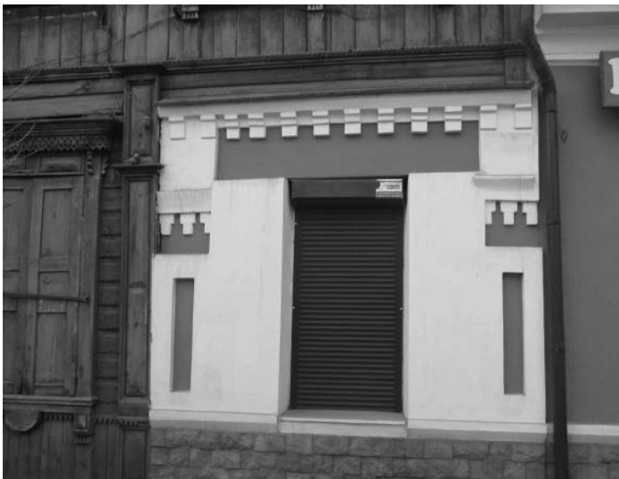
Фото 3. Боковой пристрой (застроенный сквозной проезд в усадьбу)
