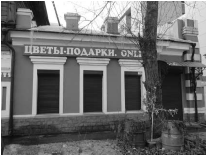
Фото 2. Главный (юго-восточный) фасад кирпичной лавки
