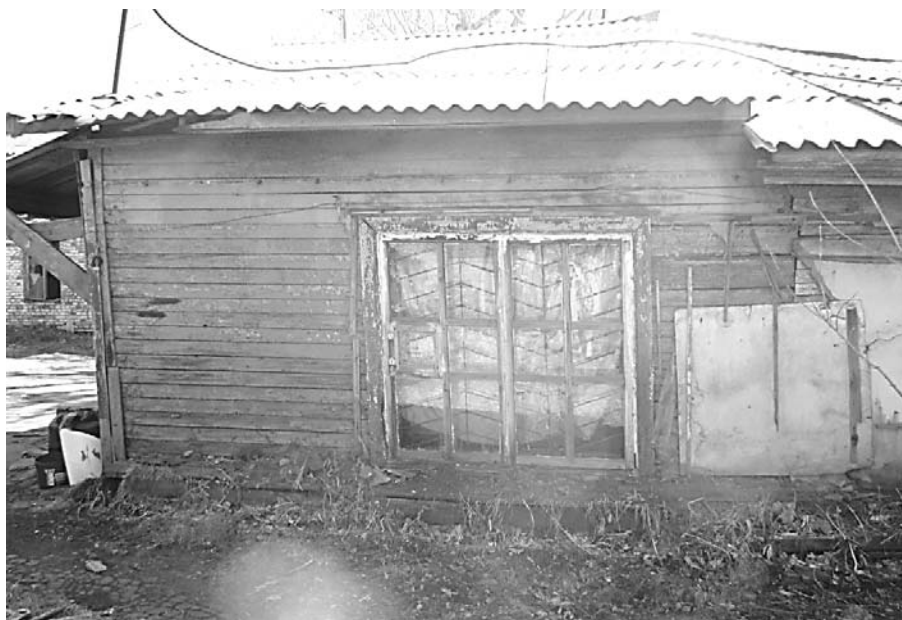
Фото 14 - Боковой (северо-западный) фасад здания лечебницы (лит. А, А1, А2). Поздний перестроенный дворовый пристрой
