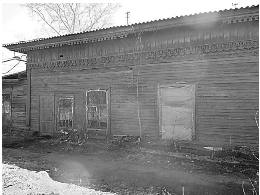
Фото 16 - Боковой (северо-западный) фасад здания лечебницы (лит. А, А1, А2). Основной объем лечебницы
