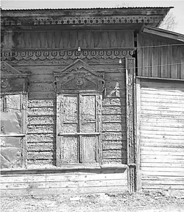
Фото 5 - Фрагмент главного (юго-западного) фасада лечебницы (лит. А, А1, А2). Наличник окна, лопатка, обшивка основного объема
