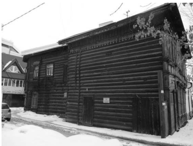
Фото 12. Боковой разновысокий пристрой с парадным входом (лит. а1). Юго-восточный фасад
