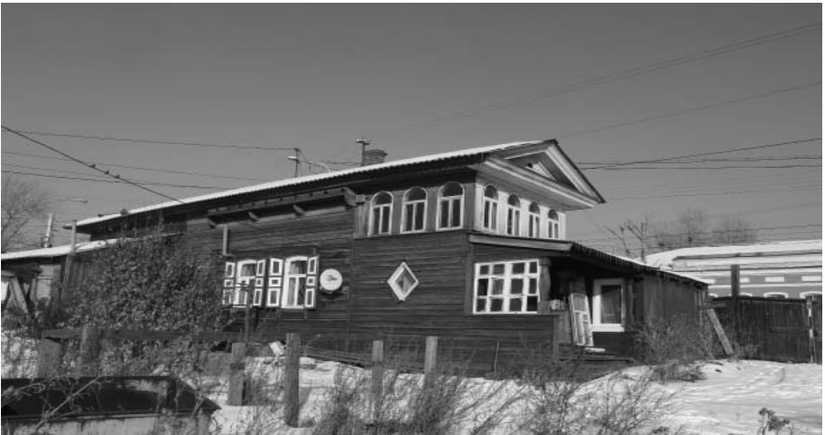
Фото 8 - Вид на здания с южного угла
