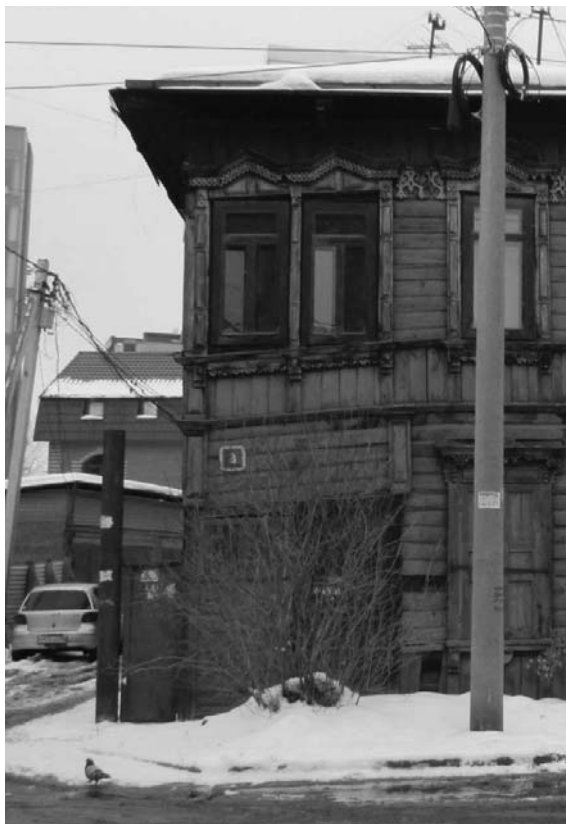
Фото 11. Боковой разновысокий пристрой с парадным входом (лит. а1). Северо-восточный фасад
