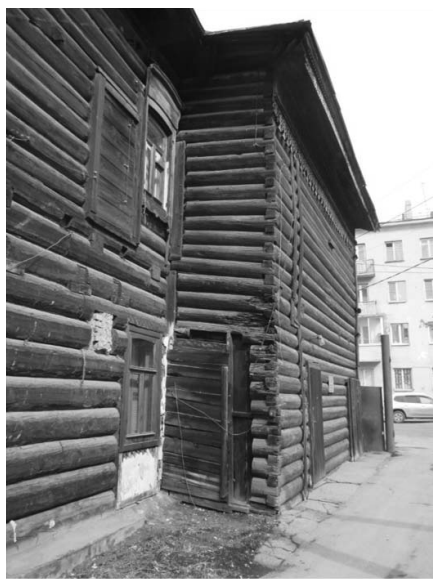
Фото 13. Боковой разновысокий пристрой с парадным входом (лит. а1). Юго-западный фасад
