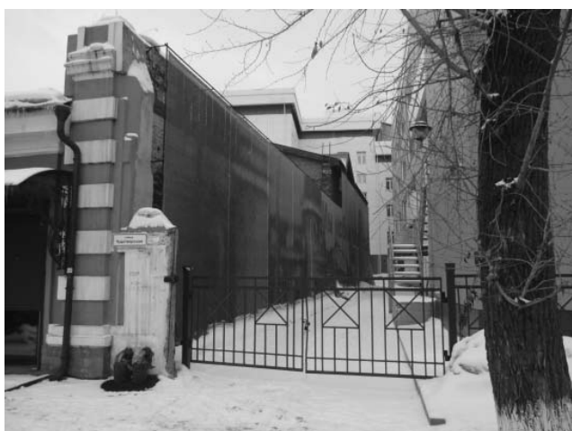
Фото 14. Дворовый жилой пристрой. Северо-западный фасад
