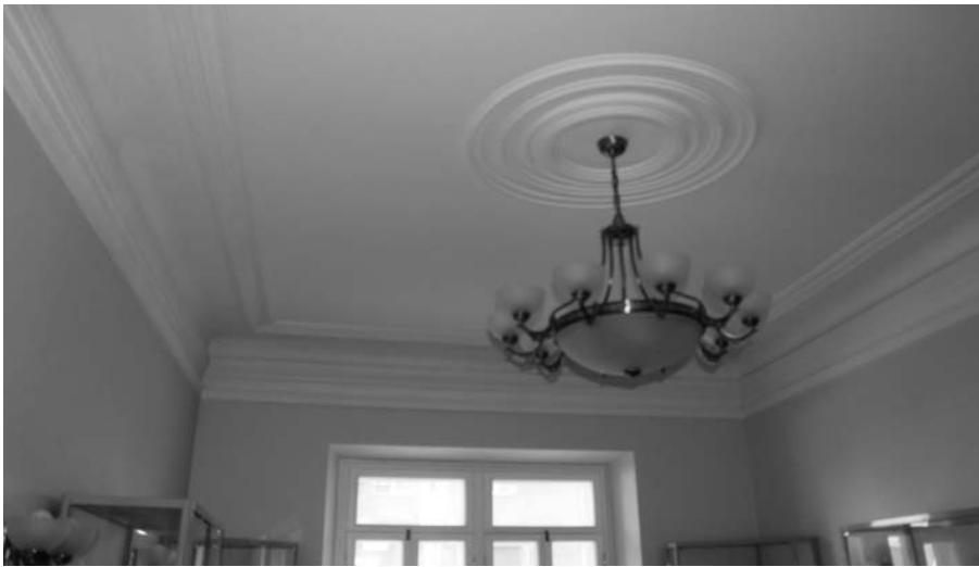
Фото А.А. Жильцов, июнь 2018 г. Лит. А. Профилированные гипсовые тяги по потолку и карнизу стен, потолочная розетка в пом. № 6 (по плану МУП «БТИ г. Иркутска») на 1 этаже.
