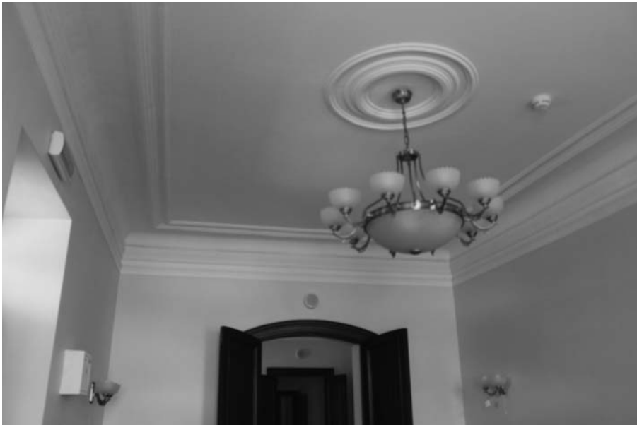
Фото А.А. Жильцов, июнь 2018 г. Лит. А. Профилированные гипсовые тяги по потолку и карнизу стен, потолочная розетка в пом. № 5 (по плану МУП «БТИ г. Иркутска») на 1 этаже.
