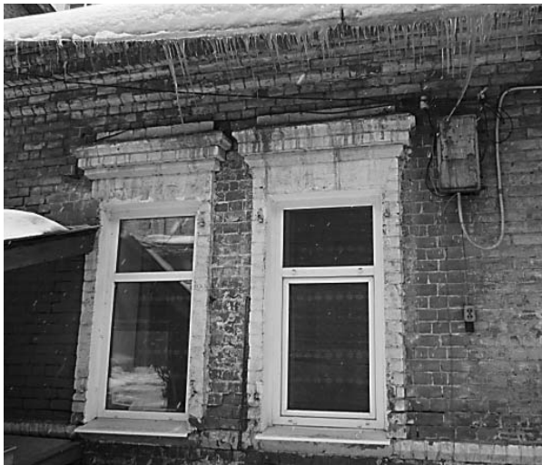
Фото 11. Дворовый жилой пристрой. Оконные проемы
