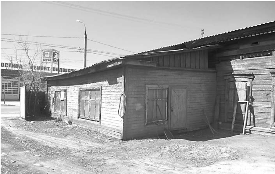
Фото 7 - Фрагмент бокового (юго-восточного) фасада лечебницы (лит. А, А1, А2). Поздний входной пристрой
