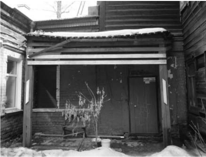
Фото 6. Дворовый (юго-западный) фасад основного объема
