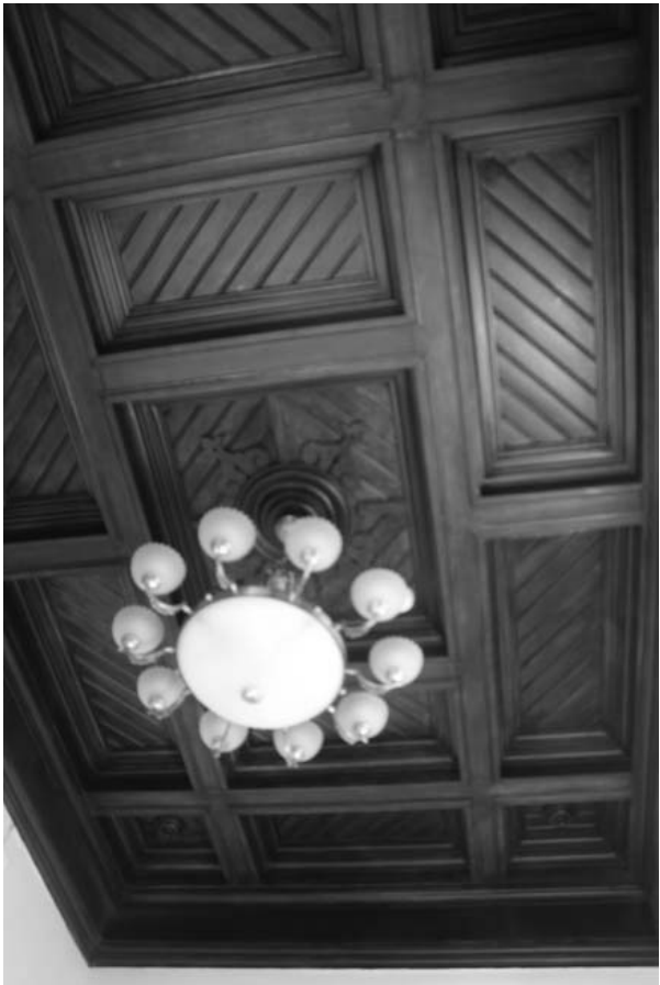
Фото А.А. Жильцов, июнь 2018 г. Лит. А. Дубовый кессонный потолок с пропиленной резьбой в центральной части, с крупной центральной и угловыми токарными розетками в пом. № 15 (по плану МУП «БТИ г. Иркутска») на 2 этаже.
