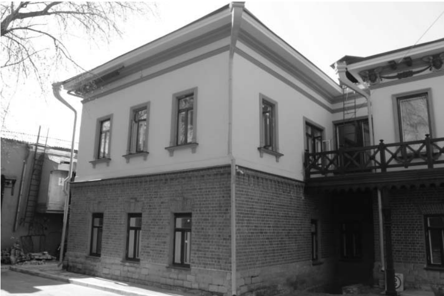
Фото А.А. Жильцов, июнь 2018 г. Лит. А. Фрагмент юго-восточного фасада.
