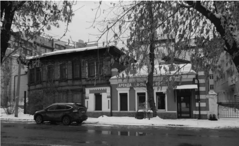
Фото 2. Главный (юго-восточный) фасад. Общий вид
