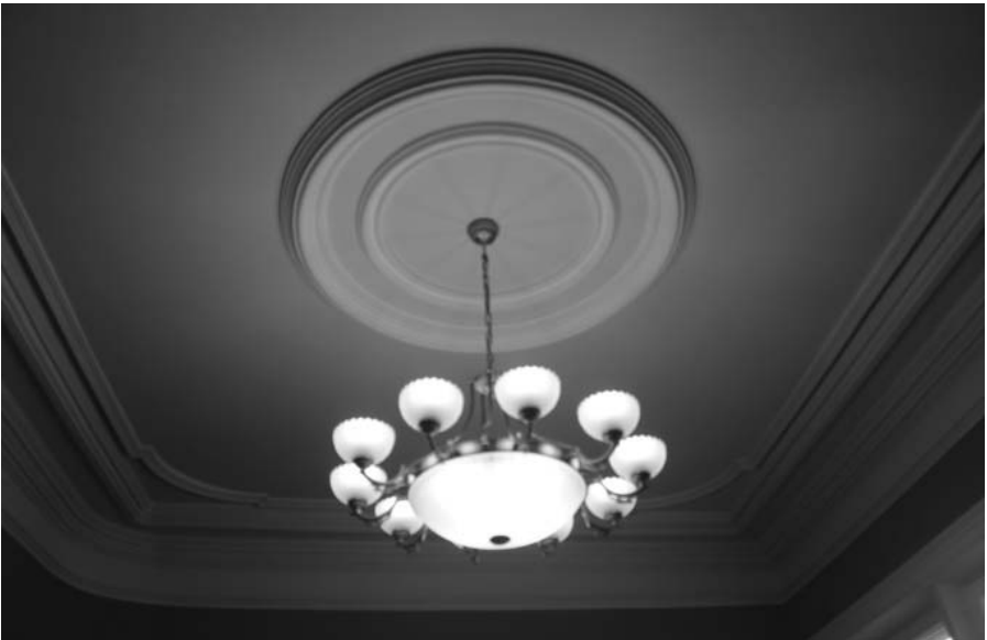
Фото А.А. Жильцов, июнь 2018 г. Лит. А.Два скругленных угла (у внутренних перегородок); декоративные сложно профилированные потолочные и карнизные настенные тяги, образующие угловое сопряжение в виде падуги; потолочная розетка в пом. № 6 (по плану МУП «БТИ г. Иркутска») на 2 этаже.
