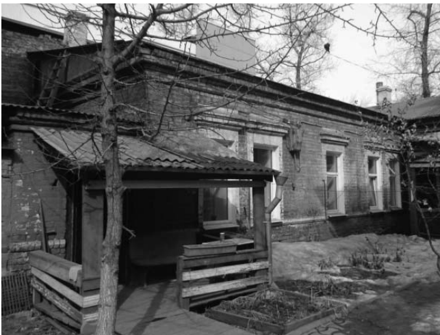
Фото 9. Дворовый жилой пристрой. Юго-восточный фасад
