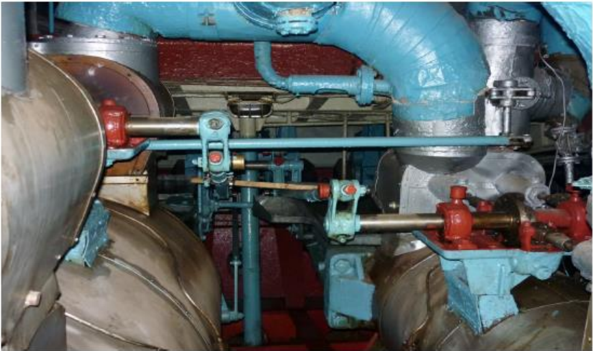
ПРИЛОЖЕНИЕ 2. ФОТОФИКСАЦИЯ. Фото № 29. Парораспределительный механизм, а слева и справа цилиндры низкого и высокого давления паровой машины. Фото А.А. Жильцов.
