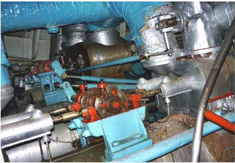
ПРИЛОЖЕНИЕ 2. ФОТОФИКСАЦИЯ. Фото № 28. Парораспределительный механизм. Фото А.А. Жильцов.
