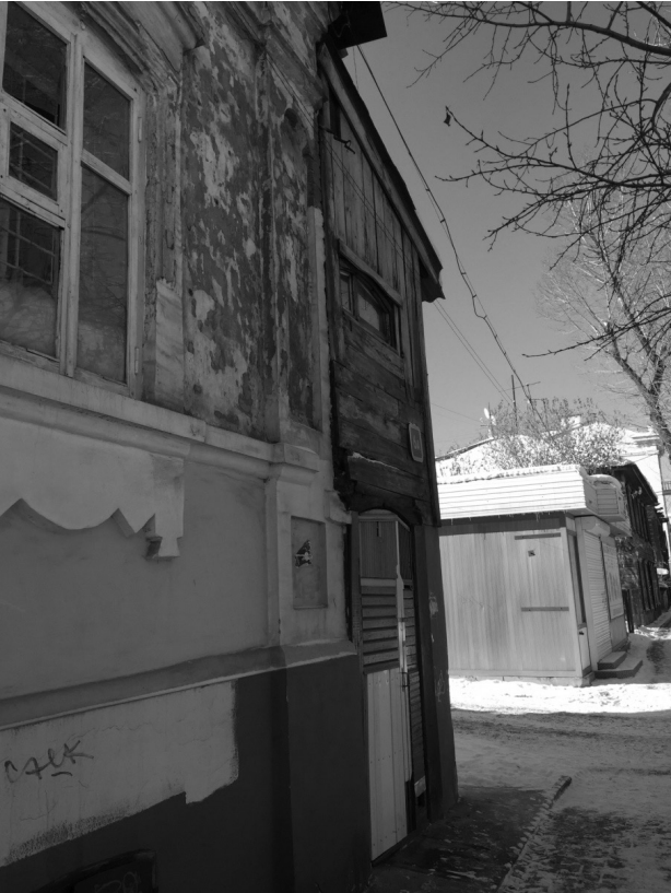
Фото 2. Главный северо-восточный фасад.
