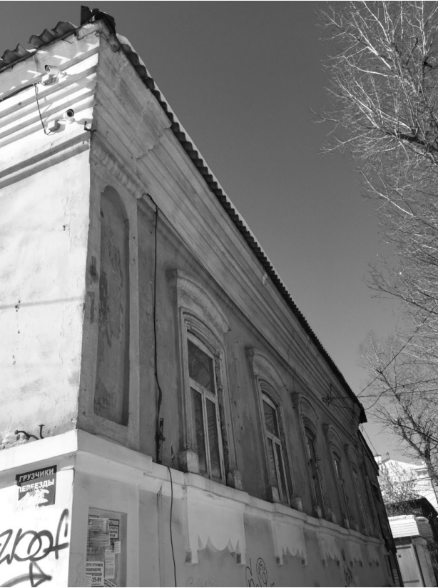
Фото 1. Главный северо-восточный фасад.
