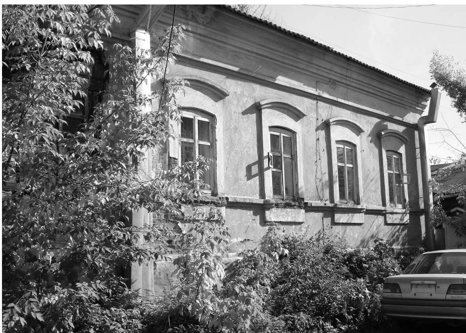
Архивное фото 4. Юго-западный фасад.
