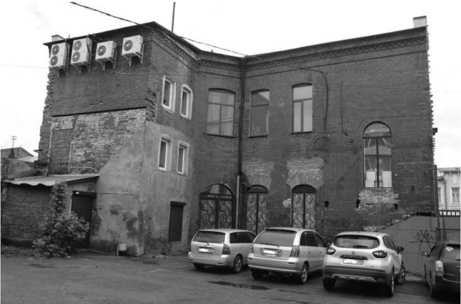
Фото А.А. Жильцов, июнь 2017 г. Дворовый (юго-западный) фасад.
