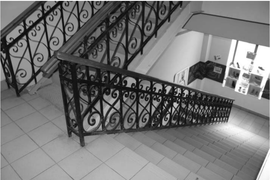
Фото А.А. Жильцов, июнь 2017 г. Главная лестница с профилированным деревянным поручнем и кованым ажурным ограждением.
