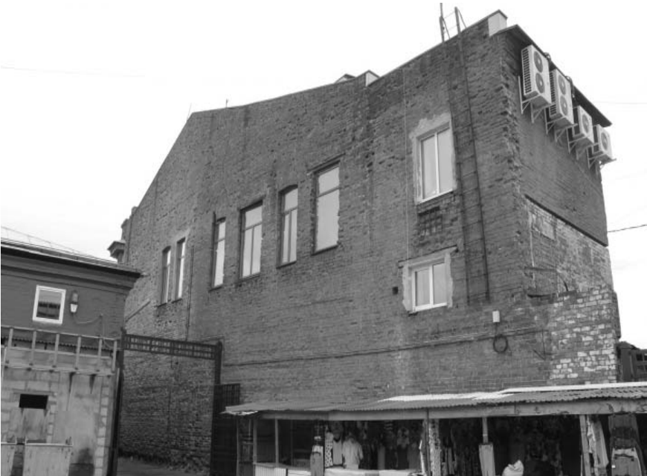
Фото А.А. Жильцов, июнь 2017 г. Боковой (северо-западный) фасад.
