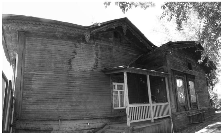
Фрагмент бокового (юго-восточного) фасада. Вход. Следы замачивания стен здания.
