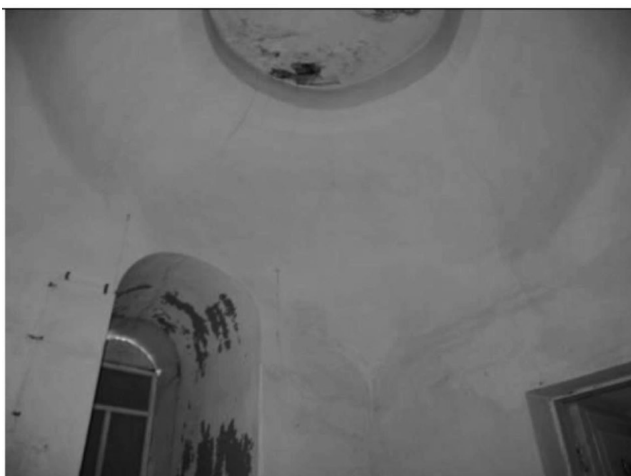
39. Интерьер; перекрытие притвора на втором этаже куполом на тропках
