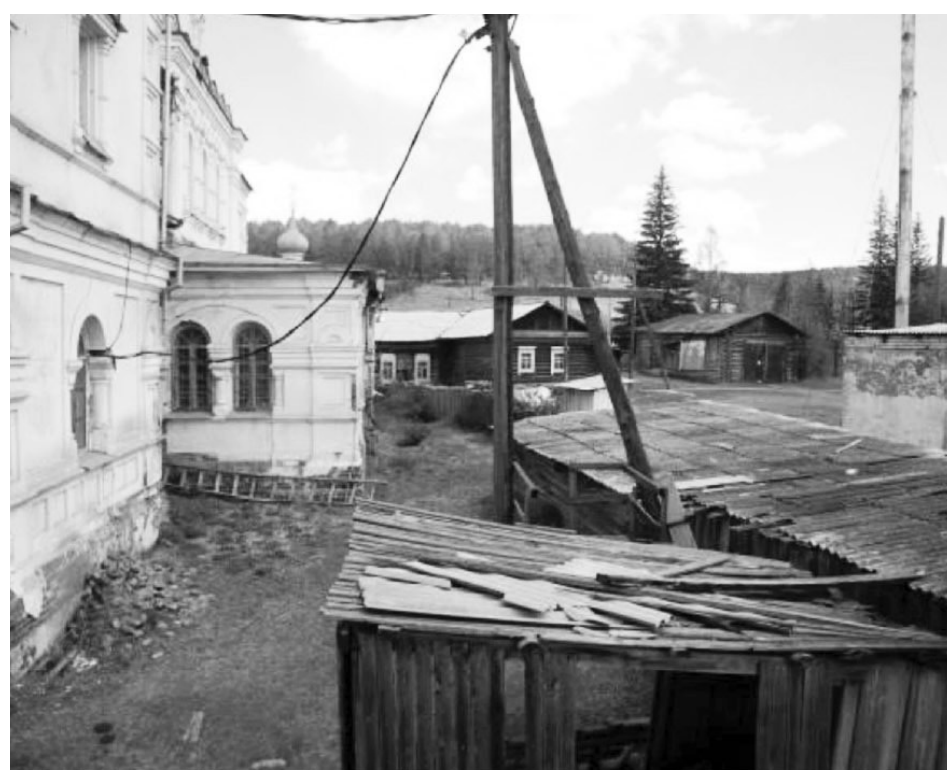
50. Вид на территорию с южной стороны собора
