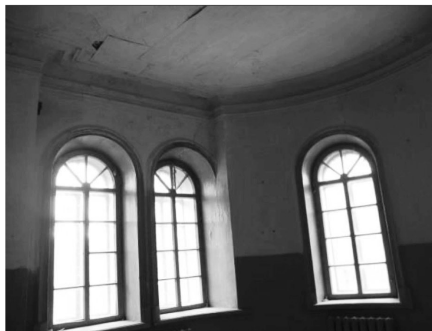
35. Интерьер; окна и перекрытие апсиды северного придела
