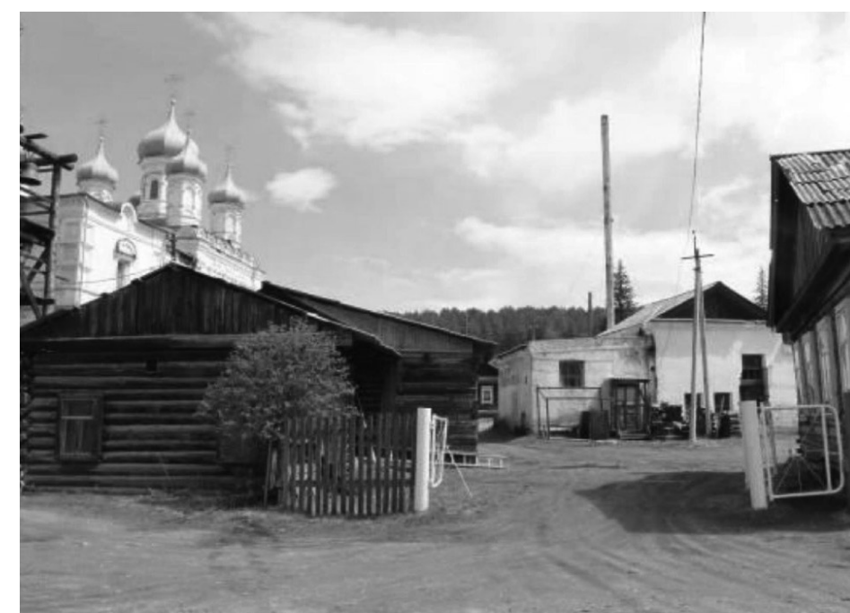
51. Вид на территорию с южной стороны собора
