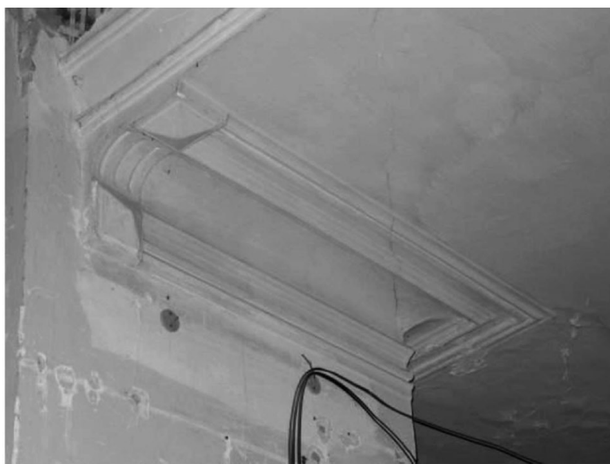
38. Интерьер; фрагмент торцовой стены арки между храмом и трапезной на первом этаже
