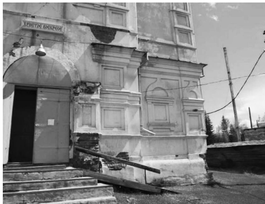
24. Фрагмент западного фасада; портал
