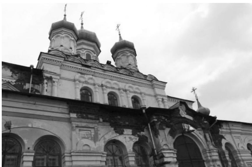
15. Фрагмент южного фасада; боковой придел и четверик храма
