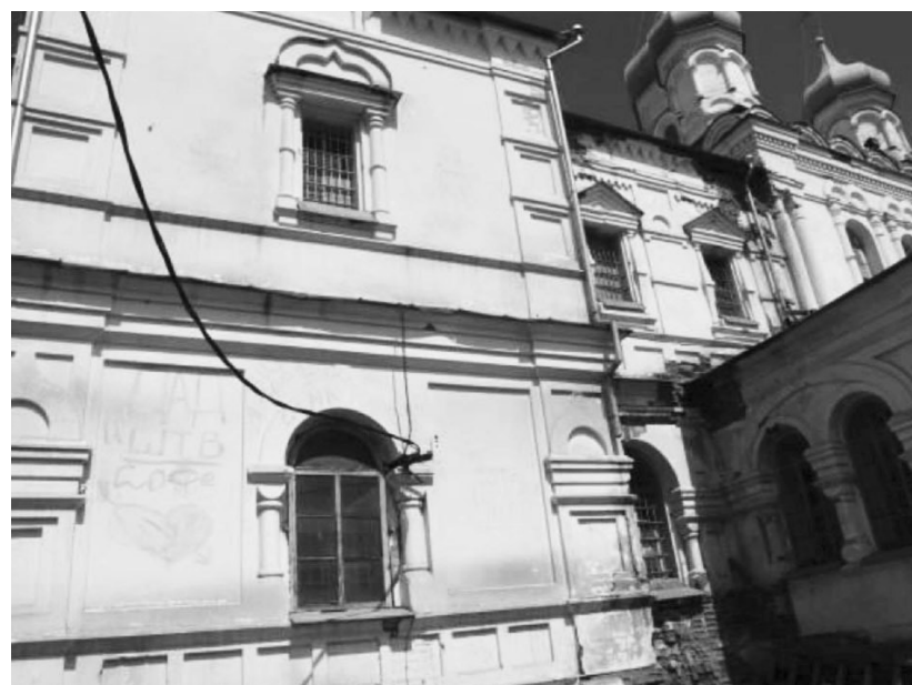
16. Фрагмент южного фасада, притвор и трапезная
