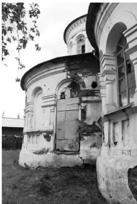
14. Фрагмент восточного фасада; служебный вход в главную апсиду
