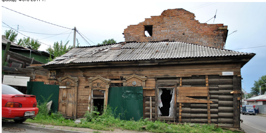
Фото 5. Ул. Грязнова, 34, лит. А. ОКН «Застройка ул. Грязнова. Усадьба Ковалёвой: два жилых дома». Северо-восточный фасад. Фото 2017 г.
