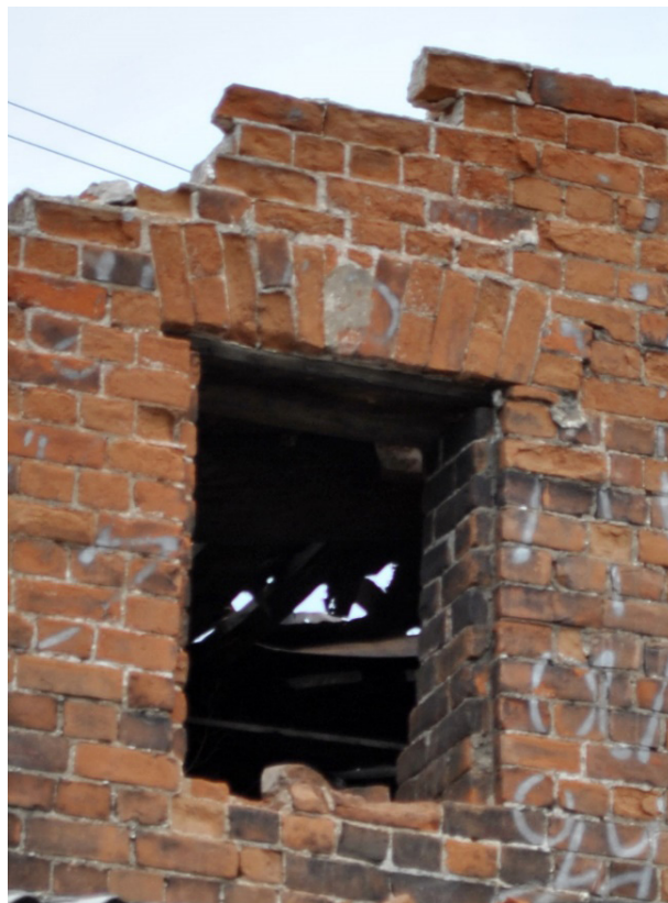
Фото 19. Ул. Грязнова, 34, лит. Б. ОКН «Застройка ул. Грязнова. Усадьба Ковалёвой: два жилых дома». Общий вид со двора. Фрагмент северо-восточного фасада. Чердачное окно. Фото 2017 г.
