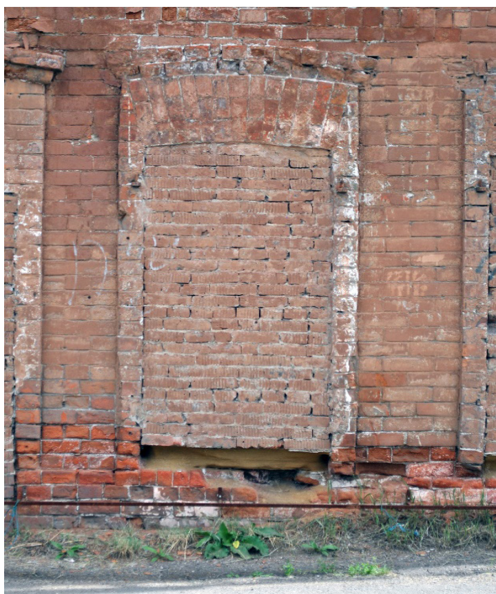
Фото 17. Ул. Грязнова, 34, лит. Б. ОКН «Застройка ул. Грязнова. Усадьба Ковалёвой: два жилых дома». Общий вид со двора. Фрагмент северо-западного фасада. Заложённый оконный проём первого этажа. Фото 2017 г.
