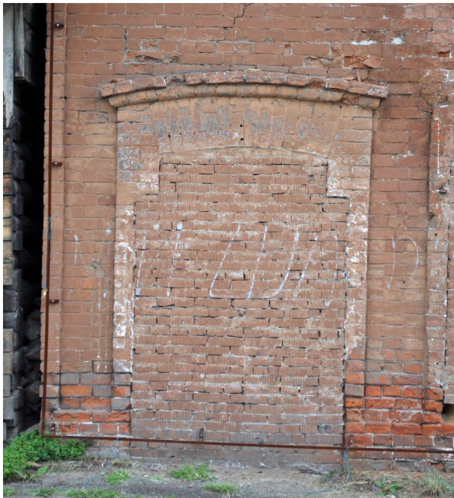
Фото 16. Ул. Грязнова, 34, лит. Б. ОКН «Застройка ул. Грязнова. Усадьба Ковалёвой: два жилых дома». Общий вид со двора. Фрагмент северо-западного фасада. Заложённый дверной проём, угловая лопатка. Фото 2017 г.
