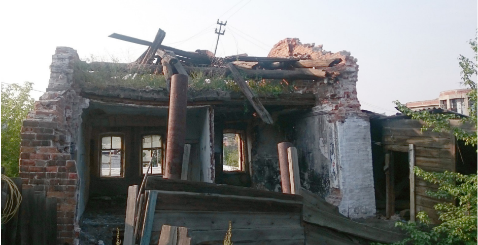
Фото 14. Ул. Грязнова, 34, лит. Б. ОКН «Застройка ул. Грязнова. Усадьба Ковалёвой: два жилых дома». Общий вид со двора. Фрагмент юго-восточного фасада. Фото 2017 г.
