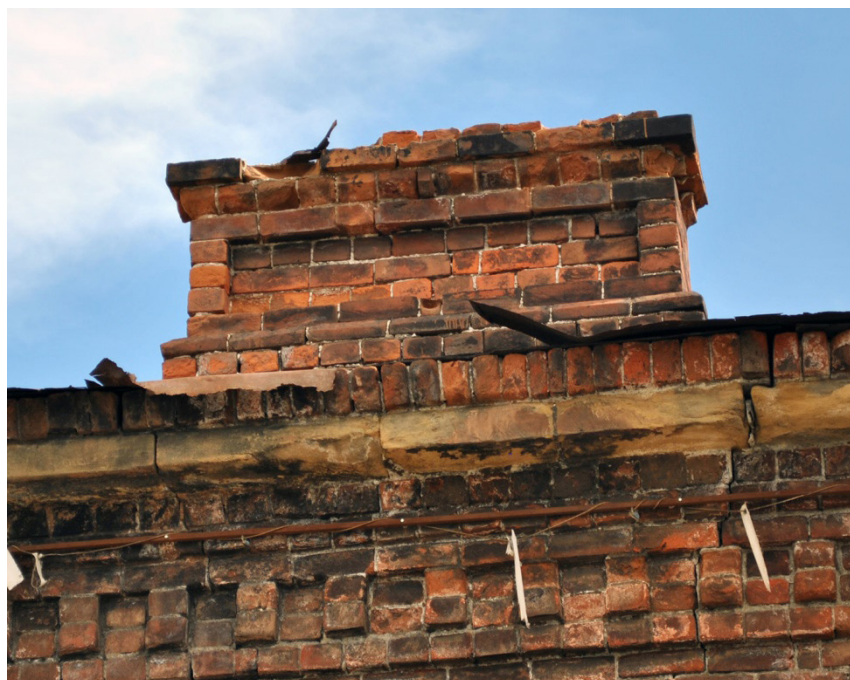
Фото 21. Ул. Грязнова, 34, лит. Б. ОКН «Застройка ул. Грязнова. Усадьба Ковалёвой: два жилых дома». Фрагмент северо-западного фасада. Фриз, карниз, аттик. Фото 2017 г.
