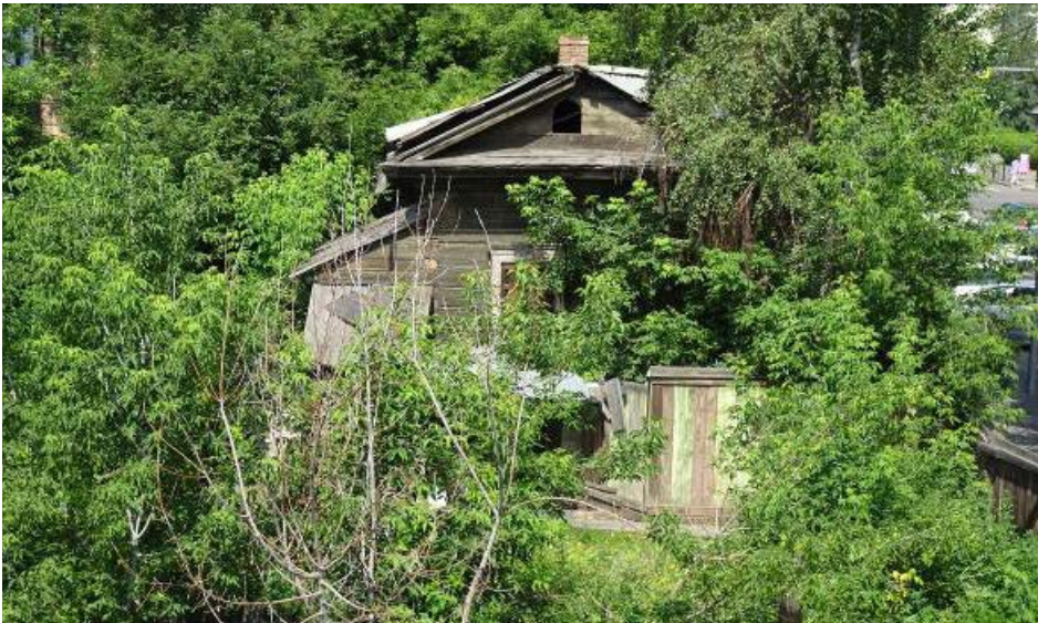
Фото 4 - Юго-восточный фасад здания лит. А. Пристрои лит. а, а1
