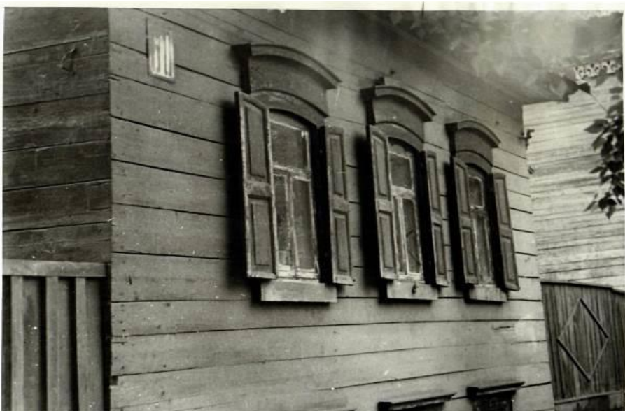
Фото III - Фрагмент главного фасада. Оконные проемы первого этажа
