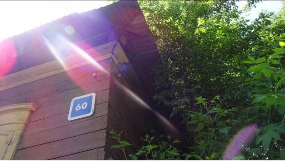
Фото 14 - Северный угол дома лит. А: карниз
