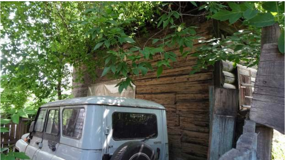
Фото 9 - Боковой северо-западный фасад лит. А. Вид на дом с запада
