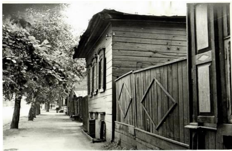
Фото IV - Главный фасад дома лит. А, вид по ул. Декабрьских Событий, с северо-запада
