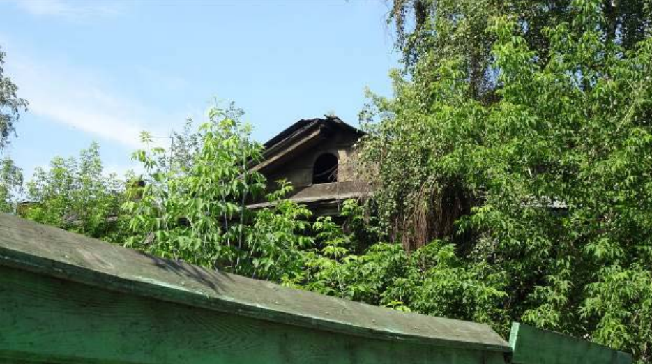
Фото 15 - Фрагмент юго-восточного фасада пристроя лит. а –
