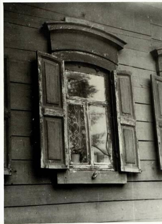
Фото VI - Декоративное оформление главного фасада. Наличник оконного проема по центральной оси.
