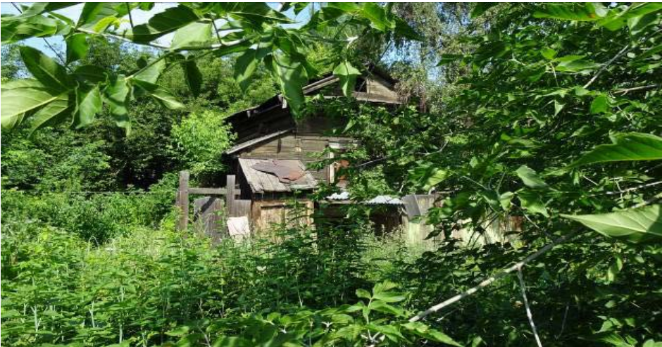
Фото 6 - Фрагмент юго-восточного фасада лит. А. Пристрои лит. а, а1
