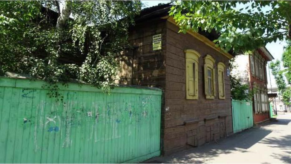
Фото 1 - Общий вид усадьбы по ул. Декабрьских событий с востока
