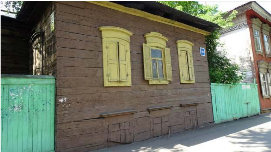
Фото 3 - Северо-восточный фасад главного дома (лит. А)
