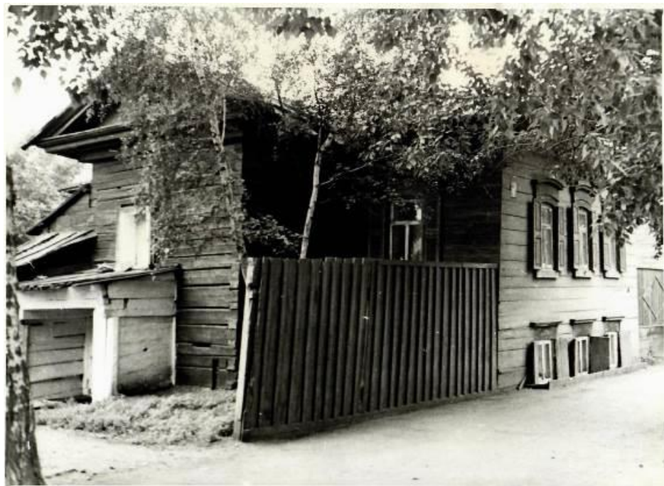
Фото II - Вид главного дома усадьбы (лит. А) с восточного угла
