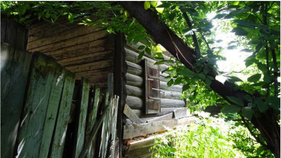
Фото 7 - Фрагмент дворового (юго-западного) фасада лит. А
