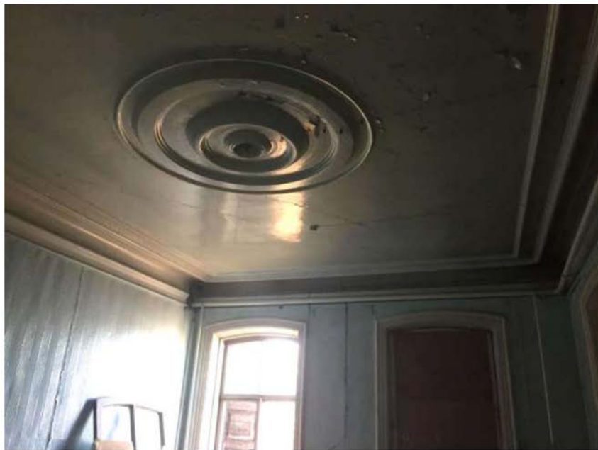
Фото 14. Интерьер. Профилированная обналичка окон, профилированные потолочные тяги, потолочная розетка. Адрес: г. Киренск, ул. Ленских Рабочих, 31.
