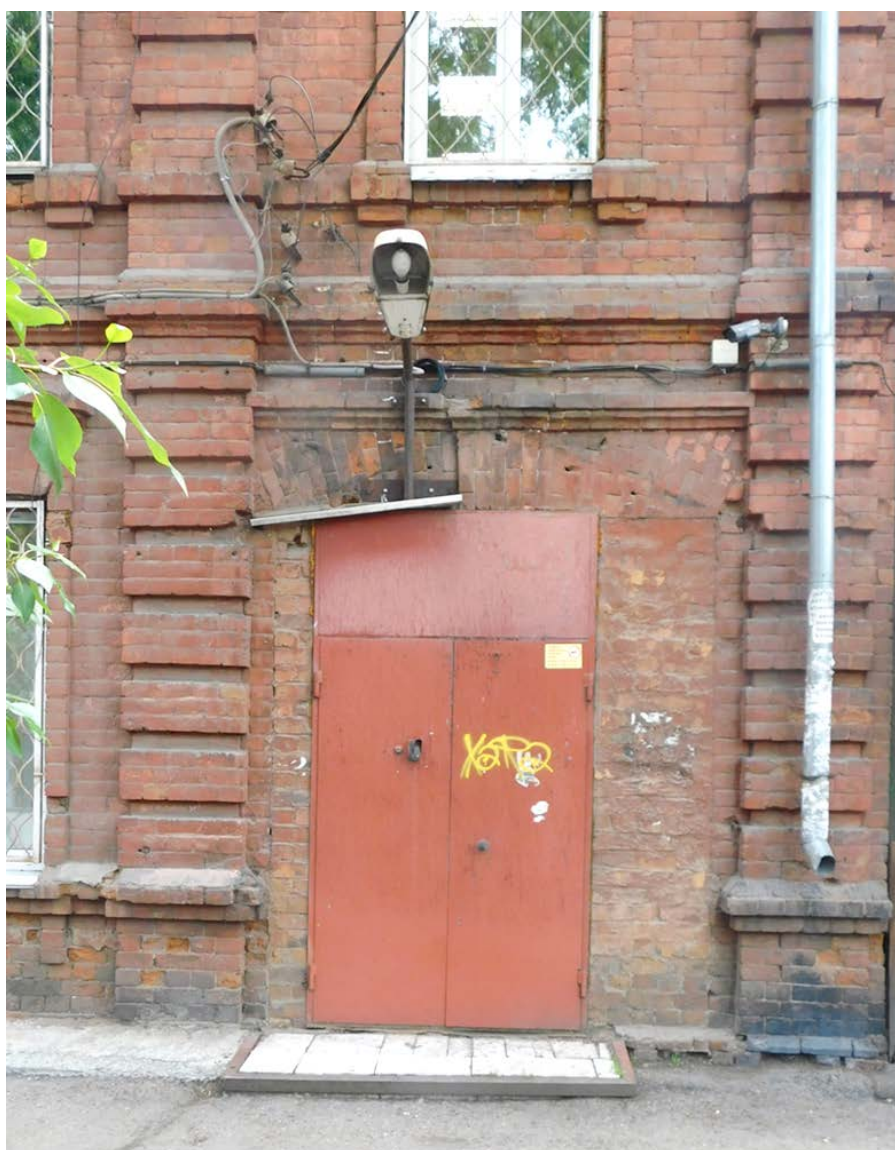
15. Главный, юго-западный фасад. Главный вход. Подоконный пояс.
