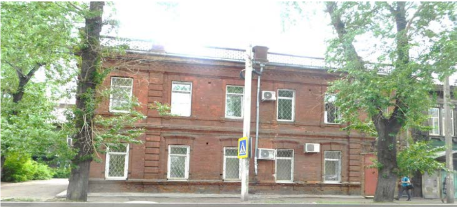
1.Юго-западный, главный фасад.
