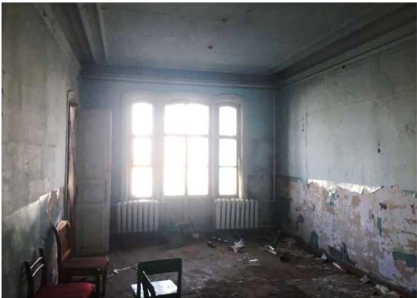
Фото 13. Интерьер. Профилированная обналичка окон, профилированные потолочные тяги, филенчатая дверь. Адрес: г. Киренск, ул. Ленских Рабочих, 31.
