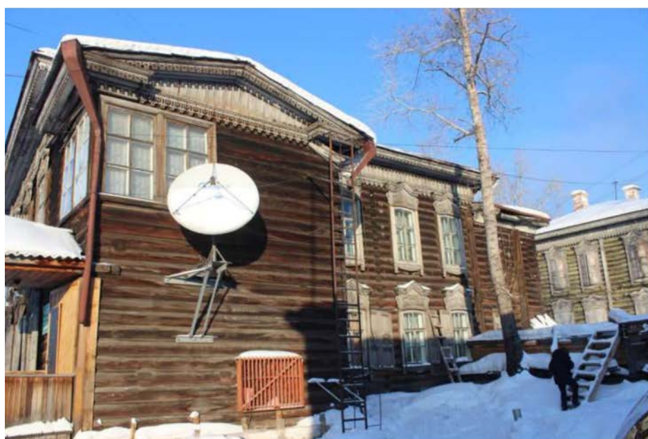
Фото 4. Дворовый (южный) фасад по адресу: г. Киренск, ул. Ленских Рабочих,30.
