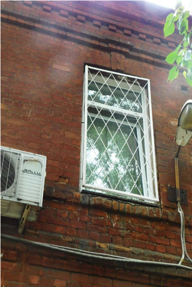
17. Боковой, юго-западный фасад. Оконный проем1 этажа.
