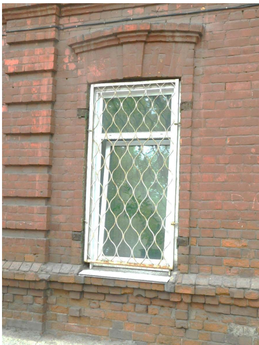
11.Главный, юго-западный фасад. Оконный проем 1 этажа. Наличник,сандрик.
