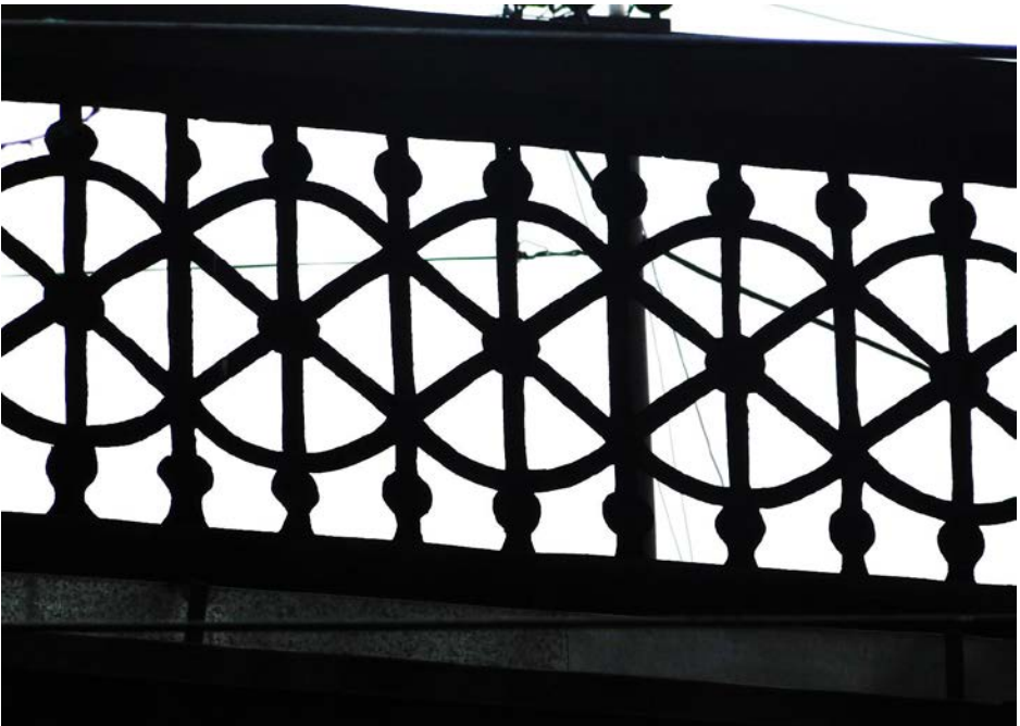
3.Фрагмент решетки парапета из листового железа с «просечным» рисунком.
