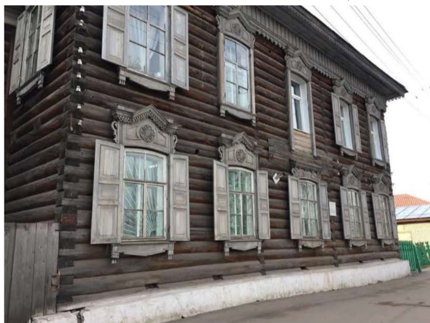
Фото 1. Главный (северный) фасад по адресу: г. Киренск, ул. Ленских Рабочих,30.
