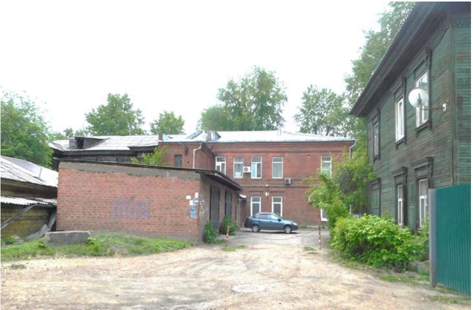
8.Северо-восточный, дворовой фасад. Парапет юго-восточного фасада.
