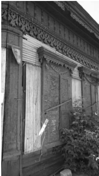
Фото 3 - Фрагмент юго-восточного фасада объекта
