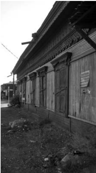
Фото 2 - Фрагмент юго-восточного фасада
