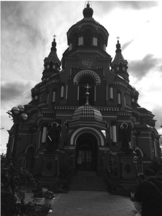
Фото 5 - Главный северо-западный фасад с ул. Декабристов
