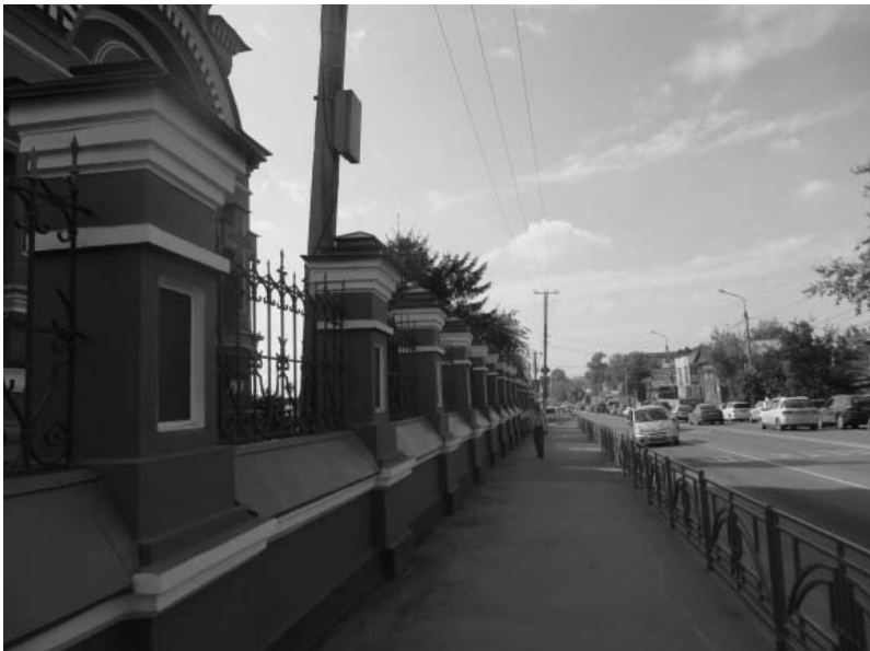
Фото 3 - Кирпичное ограждение со стороны ул. Баррикад
