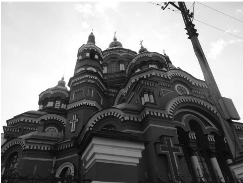
Фото 4 - Вид с севера на Казанскую церковь
