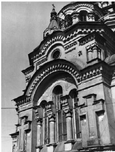
Фото 20 - Портал с тройным окном в стене придела (фото Барановского Е.Ю. от 1979г.)
