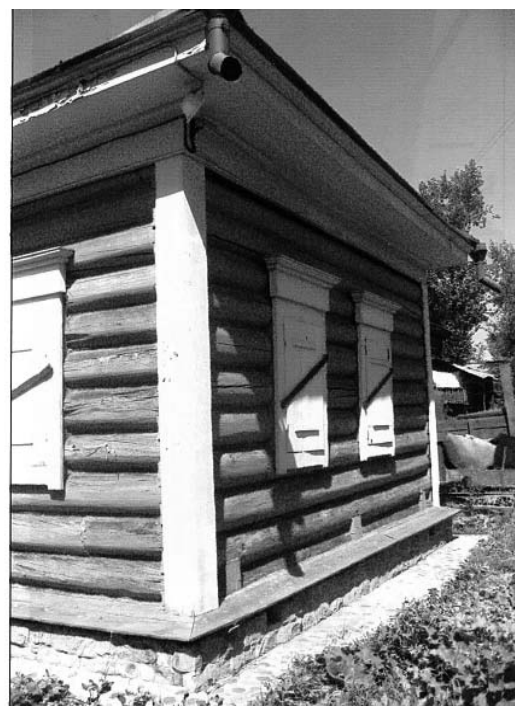
5. Юго-восточный дворовой фасад (прируб)
