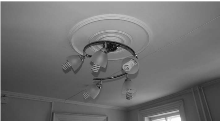
Фото А.А. Жильцов, май 2018 г. Гипсовые тяги (по периметру потолка) и розетка в пом. № 3 по плану ОГУП «ОЦТИ – Областное БТИ» на 1 этаже.
