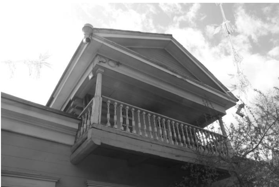
Фото А.А. Жильцов, май 2018 г. Вид на мезонин с балконом со стороны (северо-восточного) фасада.
