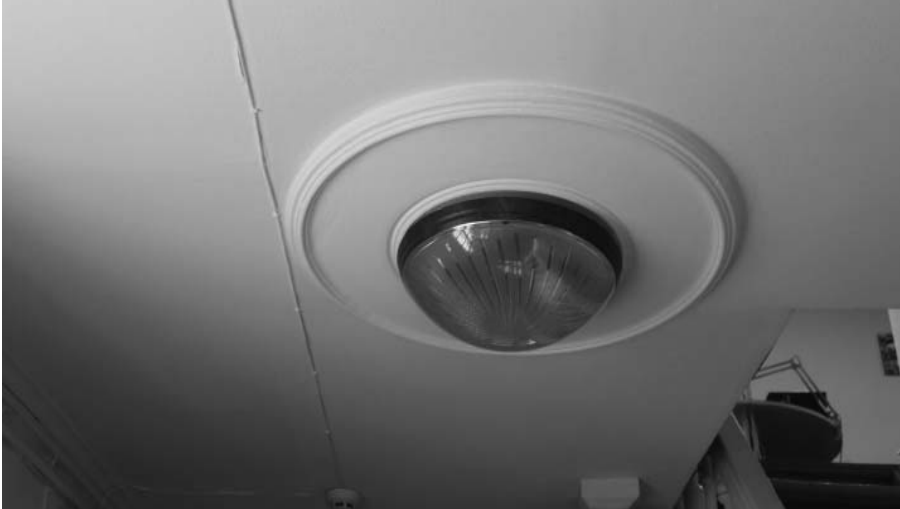
Фото А.А. Жильцов, май 2018 г. Розетка в пом. № 4 по плану ОГУП «ОЦТИ – Областное БТИ» на 1 этаже.
