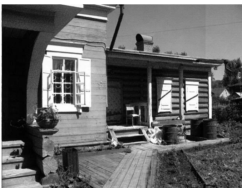
3. Фрагмент юго-западного фасада (прируб)
