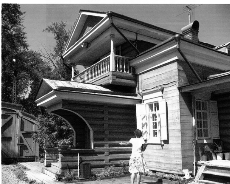
2. Дворовой (юго-западный) дворовой фасад
