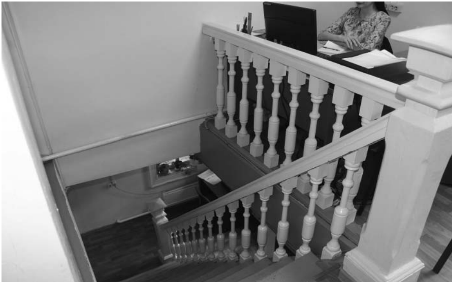
Фото А.А. Жильцов, май 2018 г. Деревянная лестница, огражденная со стороны входа перилами с балясинами и фигурными опорными столбиками.
