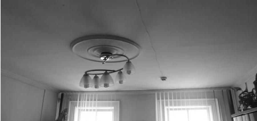
Фото А.А. Жильцов, май 2018 г. Гипсовые тяги (по периметру потолка) и розетка в пом. № 2 по плану ОГУП «ОЦТИ – Областное БТИ» на 1 этаже.
