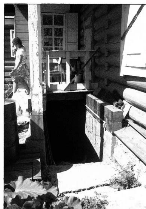
7. Входная часть в подвальный этаж
