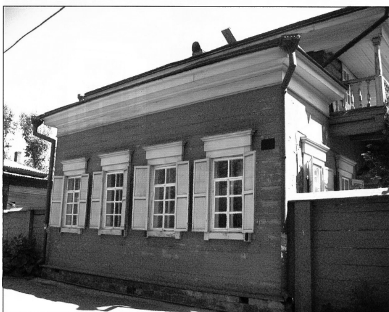
1. Главный (северо-западный) фасад
