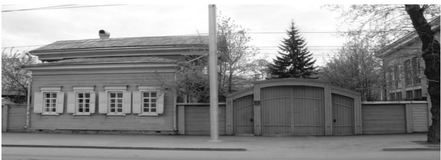
Фото А.А. Жильцов, май 2018 г. Главный (северо-западный) фасад.
