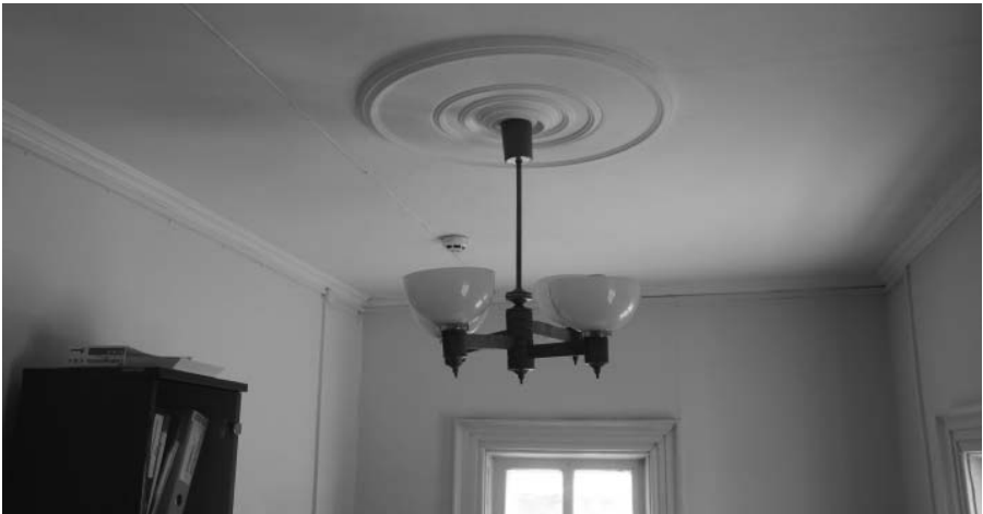
Фото А.А. Жильцов, май 2018 г. Гипсовые тяги (по периметру потолка) и розетка в пом. № 8 по плану ОГУП «ОЦТИ – Областное БТИ» на 1 этаже.
