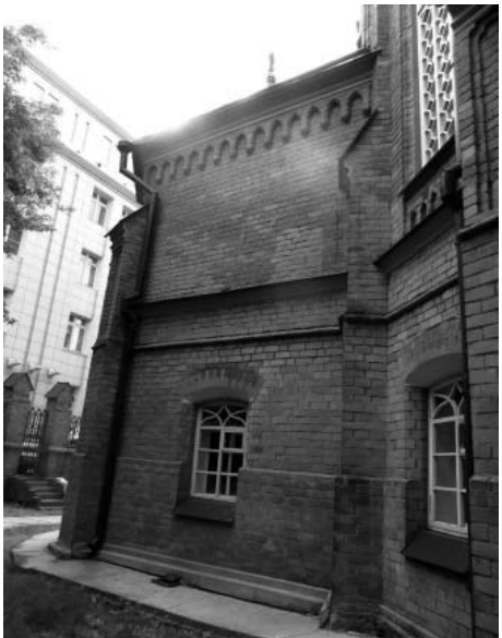
38. Южный объем трансепта со стороны восточного фасада.
