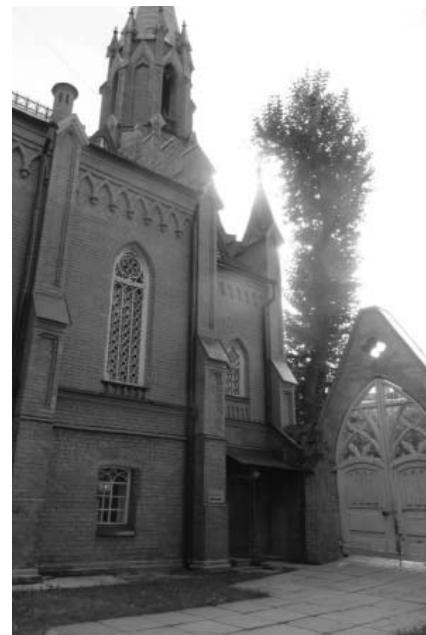
45. Фрагмент северного фасада (западная часть) с фрагментом ворот.
