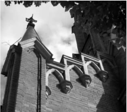
11. Оформление ступенчатого завершения стены главного фасада
