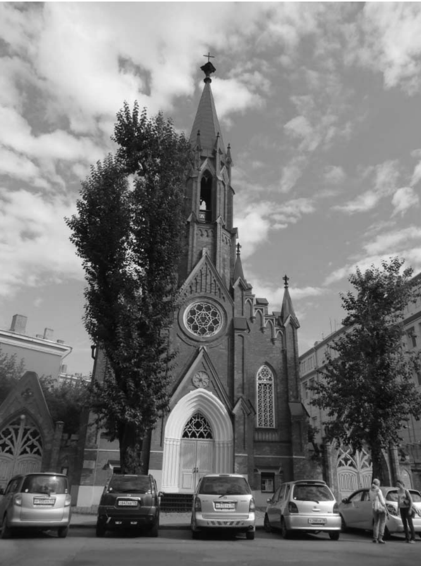
4. Западный (главный) фасад
