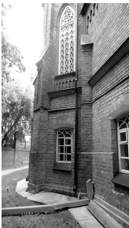
41. Апсида и восточная стена северного объема трансепта.
