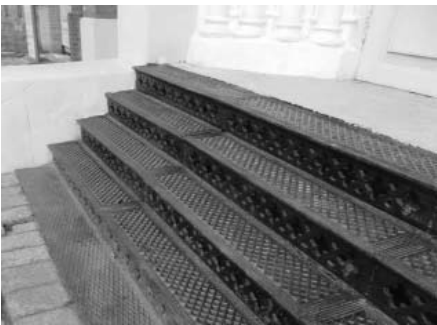
7. Решетчатые чугунные ступени крыльца
