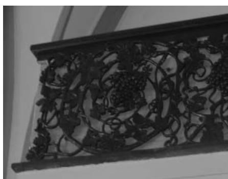
69, 70. Фрагменты узорной литой решетки балкона
