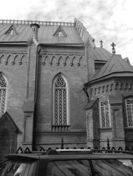
28. Фрагмент южного фасада (восточная часть).
