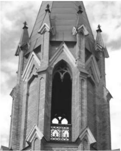
15. Арка звона колокольни с южной стороны
