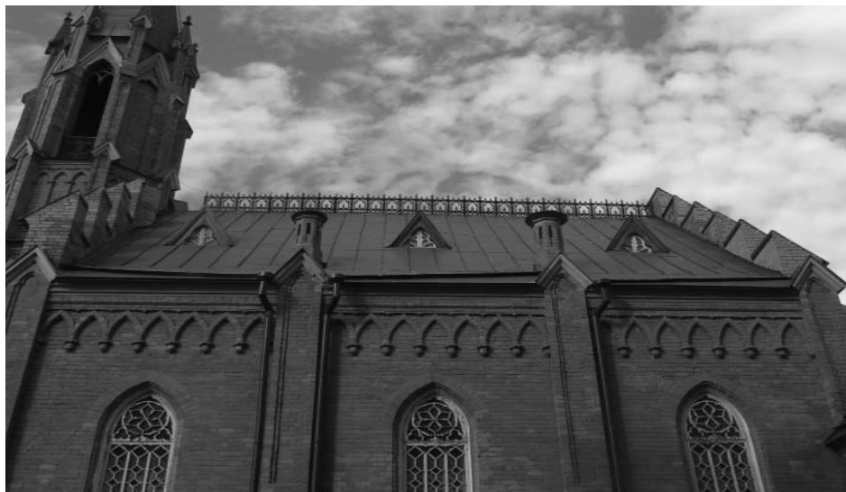
21. Фрагмент южного фасада основного объема храма.
