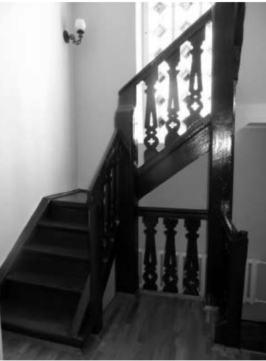
75-78. Фрагменты деревянной лестницы на колокольню
