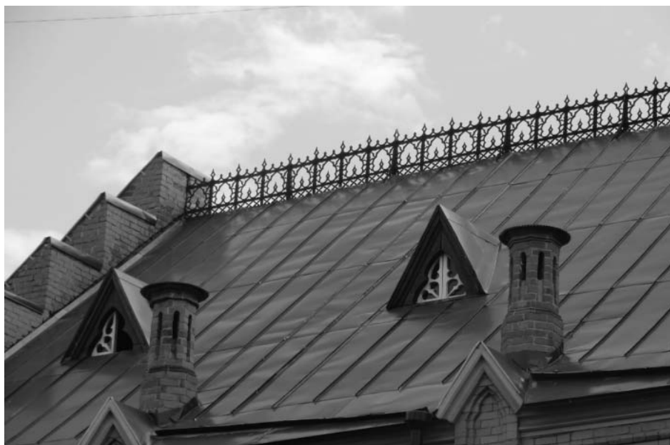
22. Фрагмент крыши основного объема храма со стороны южного фасада.
