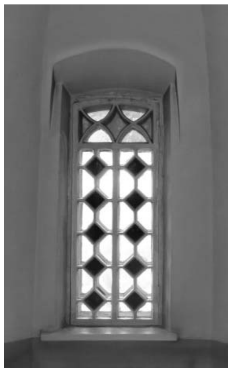
65. Лучковое окно в помещении трансепта, второй этаж
