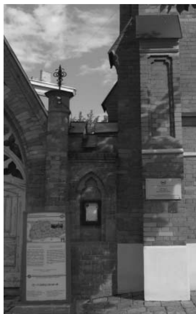
48. Фрагмент ограждения костела (с воротами), примыкающего к зданию слева
