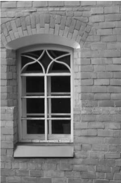
27. Окно первого этаж на южном фасаде.
