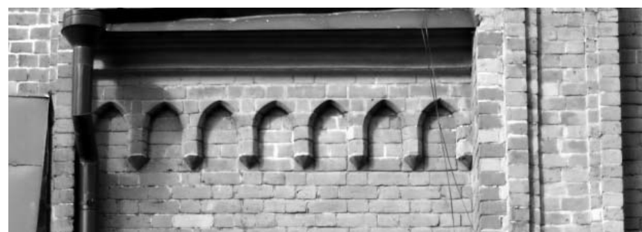
25. Аркатурный фриз в завершении западной части южного фасада.
