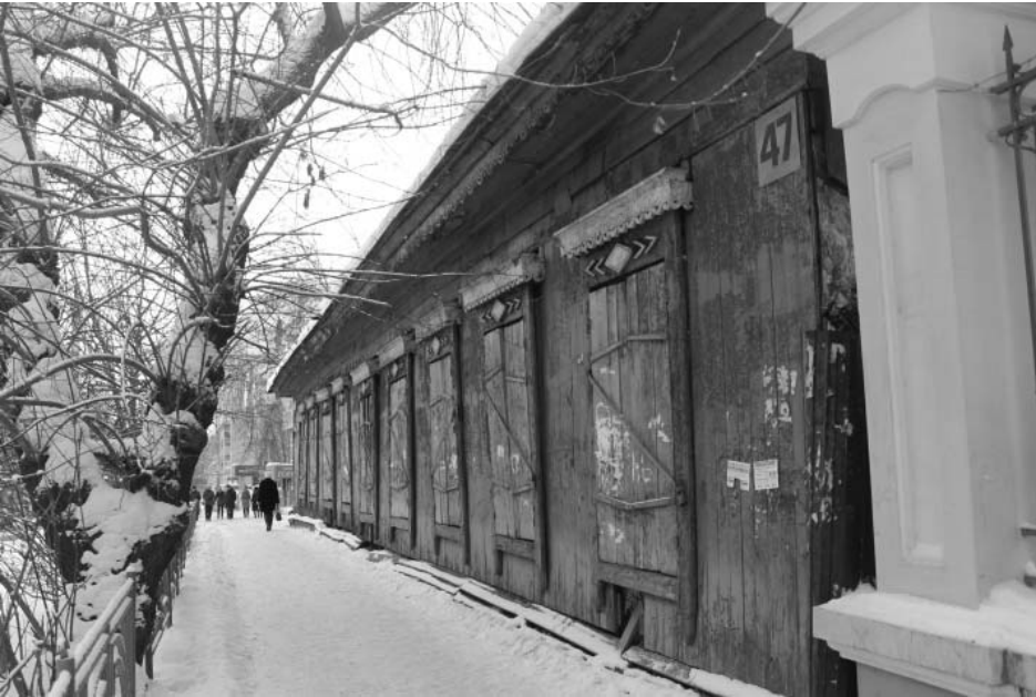
Фото А.А. Жильцов, январь 2018 г. Советская 1-я, 47, лит. А. Главный (южный) фасад.
