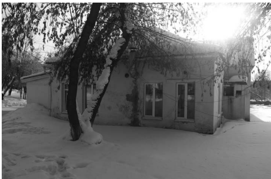
Фото А.А. Жильцов, январь 2018 г. Радищева, 5, Литер Е. Северо-восточный фасад.
