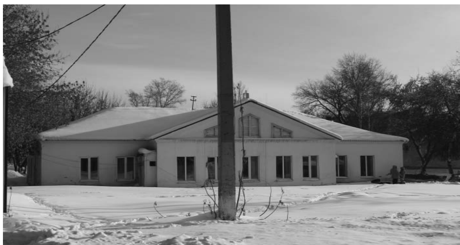
Фото А.А. Жильцов, январь 2018 г. Радищева, 5, Литер Е. Северо-западный фасад.
