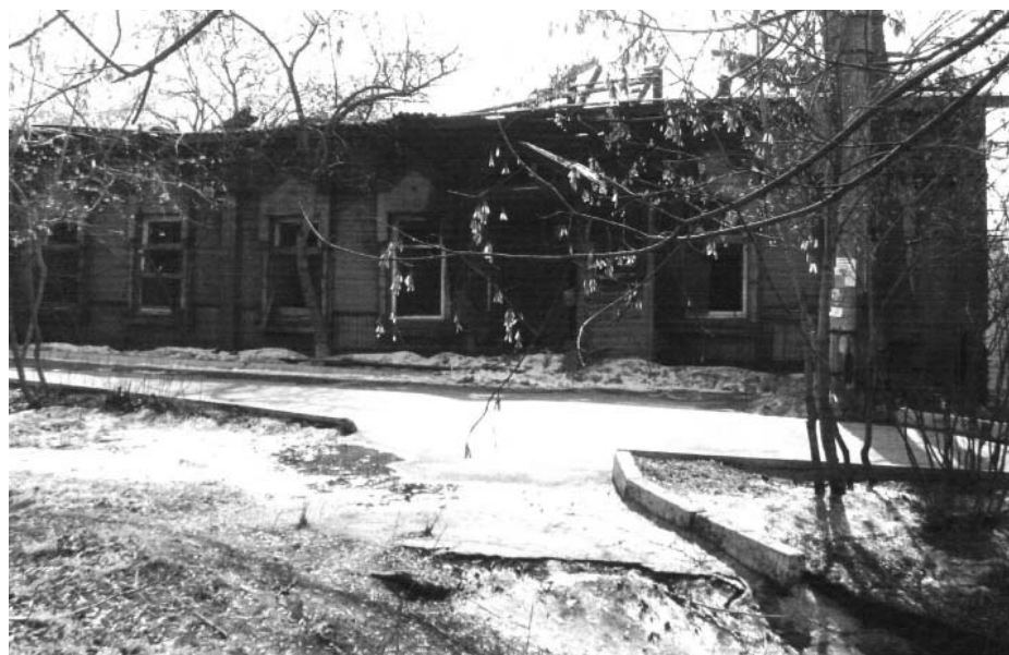
14. Северный фасад (фото 2009г.)
