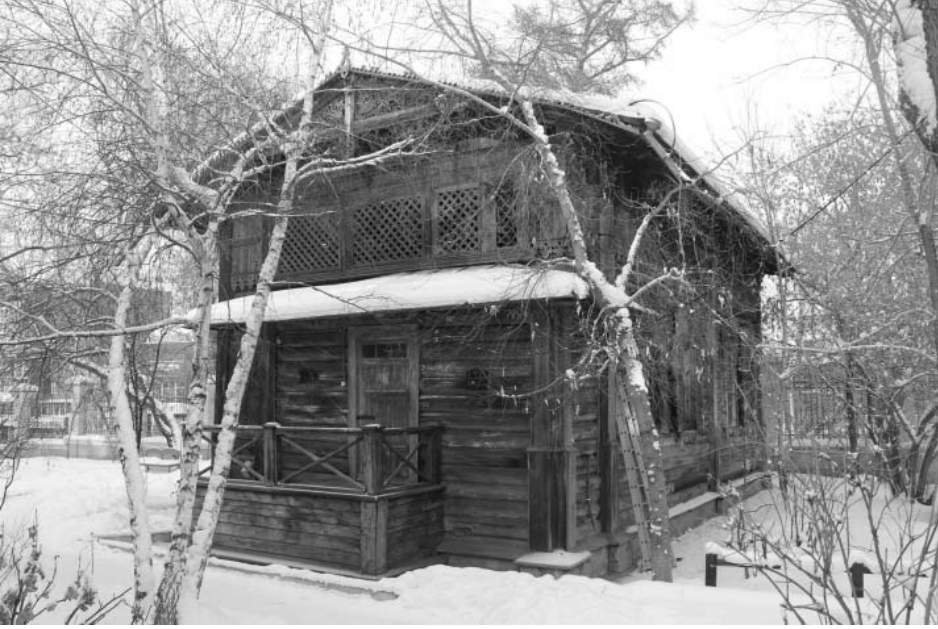
Фото А.А. Жильцов, январь 2018 г. Лит. В. Юго-западный фасад.
