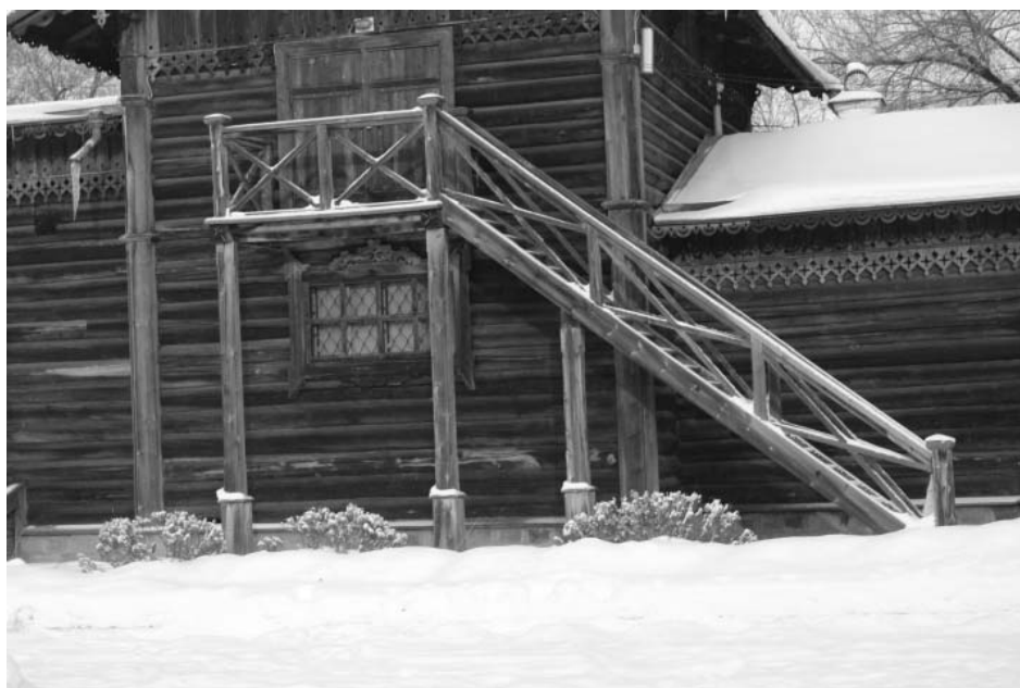
Фото А.А. Жильцов, январь 2018 г. Лит. Г. Фрагмент юго-западного фасада.
