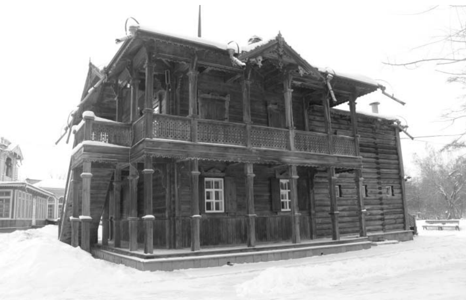
Фото А.А. Жильцов, январь 2018 г. Лит. Б. Северо-восточный фасад.
