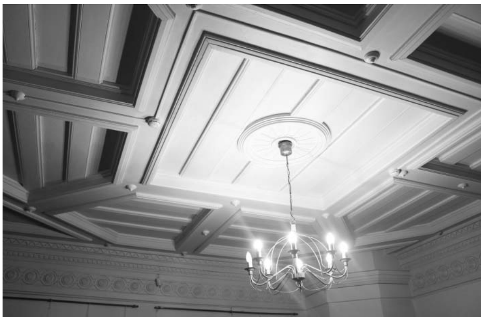
Фото А.А. Жильцов, январь 2018 г. Лит. А. Деревянный кессонный потолок, круглая потолочная розетка, лепные бордюры по верху стен в пом. 8 (по плану МУП «Бюро технической инвентаризации г. Иркутска») на 1 этаже.
