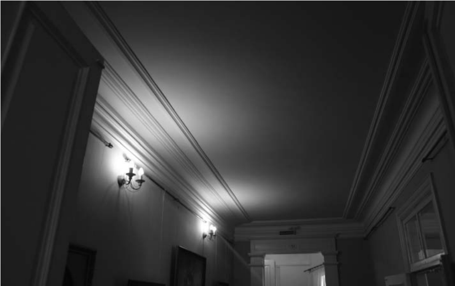
Фото А.А. Жильцов, январь 2018 г. Лит. А. Потолочные тяги в пом. 5 (по плану МУП «Бюро технической инвентаризации г. Иркутска») на 2 этаже.
