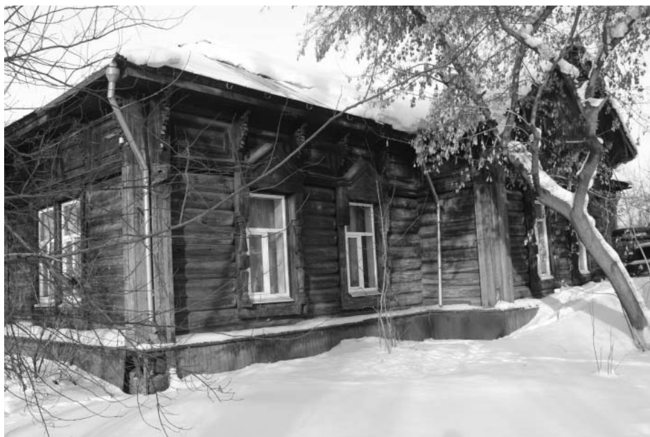
Фото А.А. Жильцов, январь 2018 г. Радищева, 5, лит. В. Фрагмент юго-восточного фасада.
