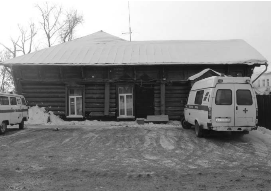
Фото А.А. Жильцов, январь 2018 г. Радищева, 5, лит. В. Северо-восточный фасад.
