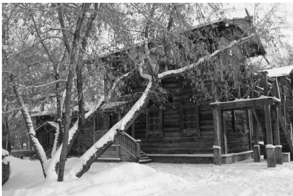
Фото А.А. Жильцов, январь 2018 г. Лит. Г. Северо-западный фасад.
