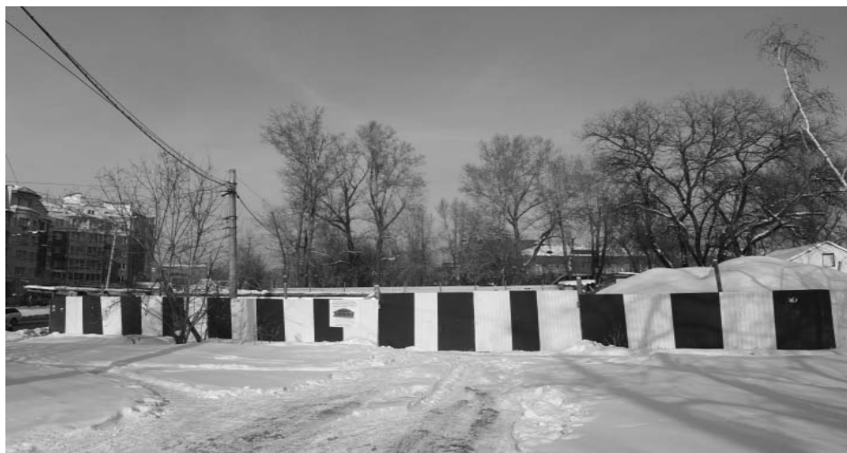
Фото А.А. Жильцов, январь 2018 г. Рабочего Штаба, 4, Литер К. Вид с юга на стройплощадку, где реконструируется здание.
