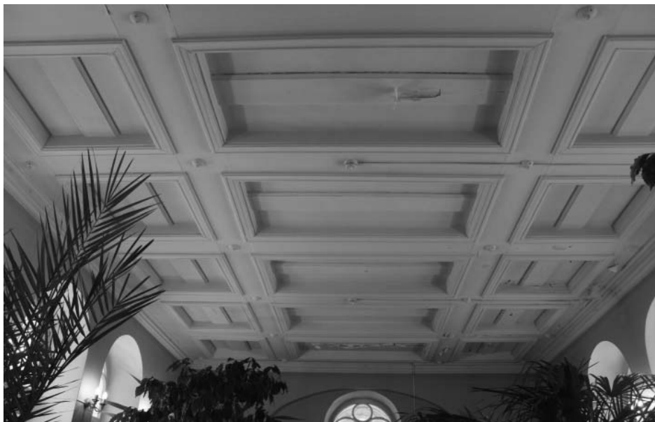
Фото А.А. Жильцов, январь 2018 г. Лит. А. Деревянный кессонный потолок в пом. 15 (по плану МУП «Бюро технической инвентаризации г. Иркутска») на 1 этаже.
