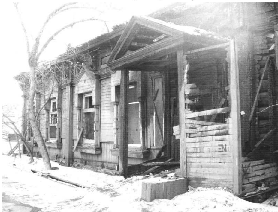
15. Фрагмент Северного фасада (фото 2009г.)
