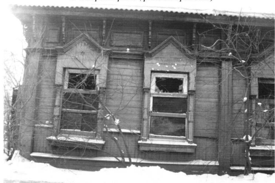
5. Фрагмент Северного фасада (фото январь 2006г.)
