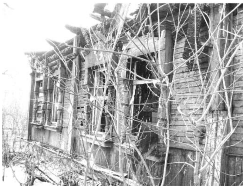
19. Фрагмент Восточного фасада (фото 2009г.)
