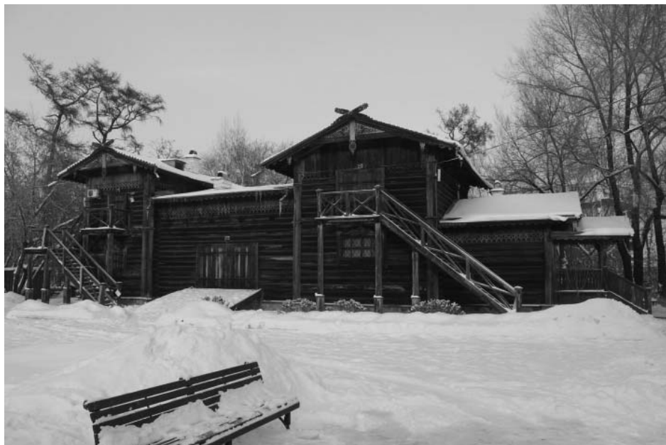
Фото А.А. Жильцов, январь 2018 г. Лит. Г. Юго-западный фасад.
