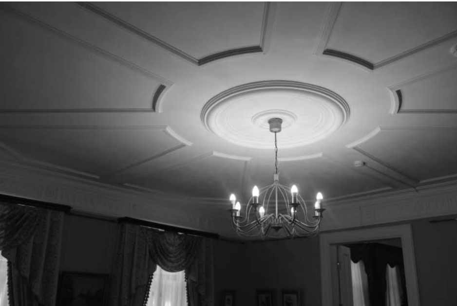
Фото А.А. Жильцов, январь 2018 г. Лит. А. Круглая потолочная розетка, потолочные тяги, лепные бордюры по верху стен в пом. 10 (по плану МУП «Бюро технической инвентаризации г. Иркутска») на 1 этаже.
