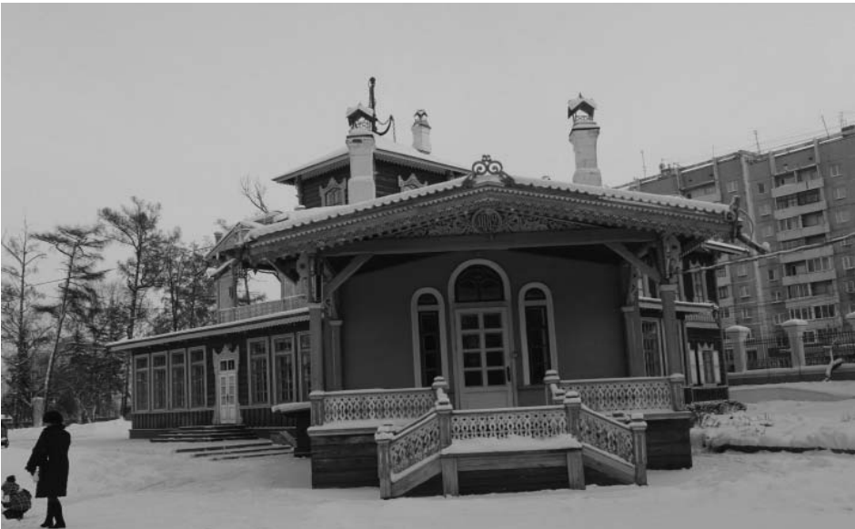
Фото А.А. Жильцов, январь 2018 г. Лит. А. Вид на здание с северо-запада.
