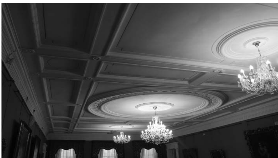
Фото А.А. Жильцов, январь 2018 г. Лит. А. Деревянный кессонный потолок с круглыми розетками, бордюры из меандра по верху стен в пом. 9 (по плану МУП «Бюро технической инвентаризации г. Иркутска») на 1 этаже.
