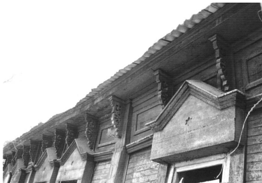
7. Фрагмент Северного фасада (фото январь 2006г.)
