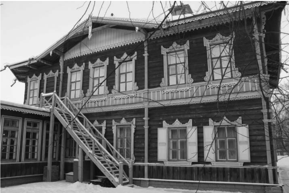
Фото А.А. Жильцов, январь 2018 г. Лит. А. Западный фасад.
