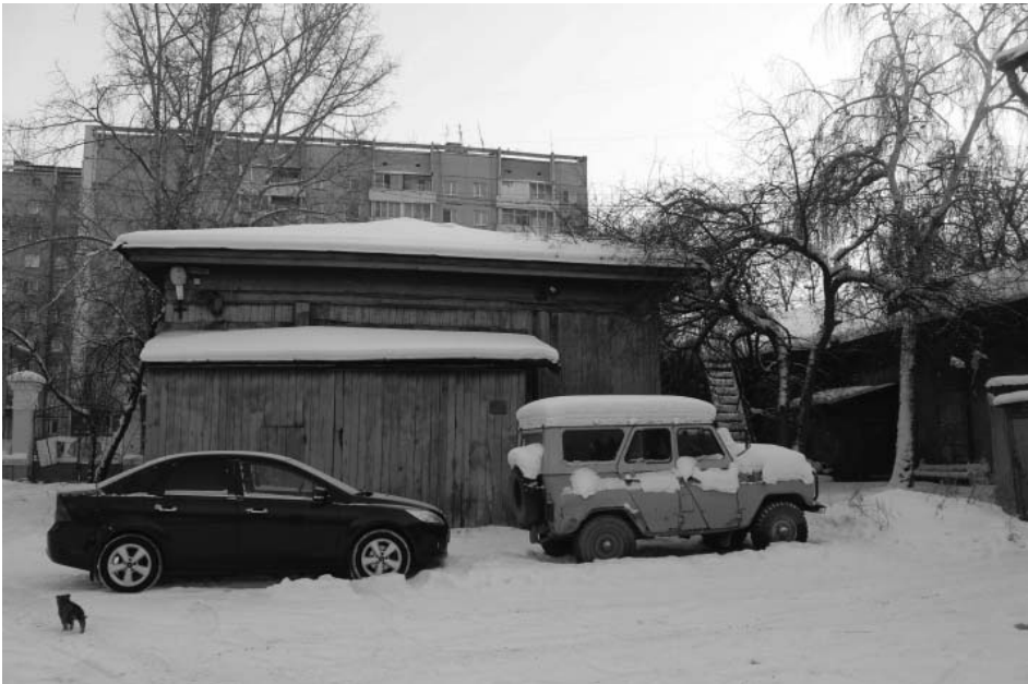
Фото А.А. Жильцов, январь 2018 г. Советская 1-я, 47, лит. А. Фрагмент северного фасада.
