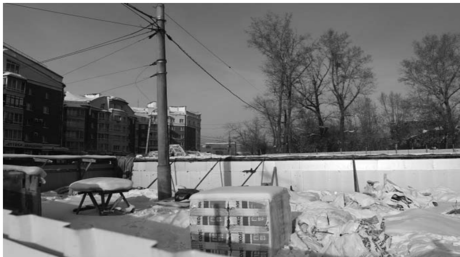
Фото А.А. Жильцов, январь 2018 г. Рабочего Штаба, 4, Литер К. Вид на цокольный этаж в процессе реконструкции здания.
