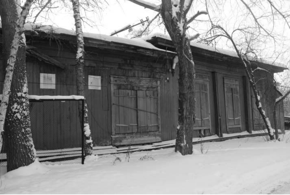
Фото А.А. Жильцов, январь 2018 г. Советская 1-я, 47, лит. А. Восточный фасад.
