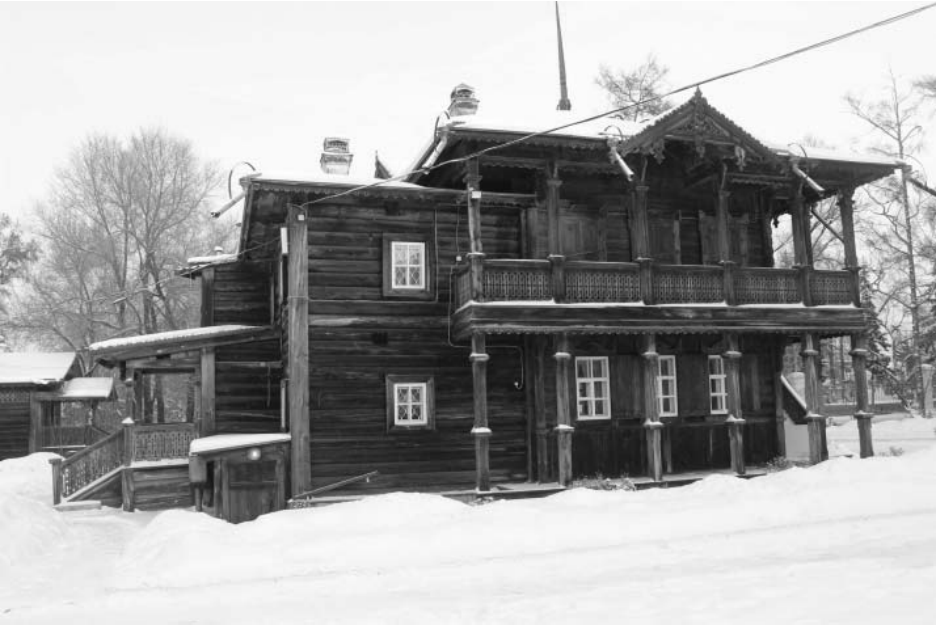
Фото А.А. Жильцов, январь 2018 г. Лит. Б. Юго-западный фасад.
