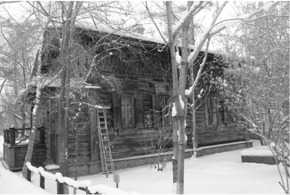
Фото А.А. Жильцов, январь 2018 г. Лит. В. Юго-восточный фасад.
