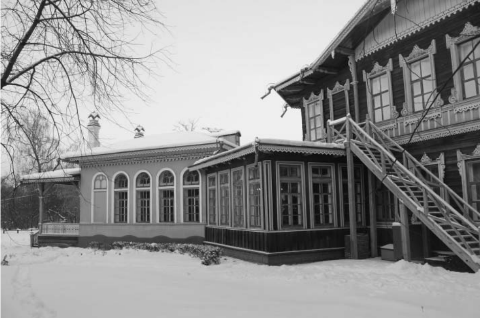
Фото А.А. Жильцов, январь 2018 г. Лит. А. Вид на здание с юго-запада.
