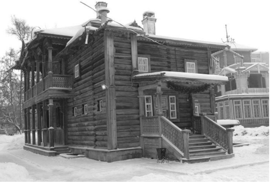
Фото А.А. Жильцов, январь 2018 г. Лит. Б. Северо-западный фасад.
