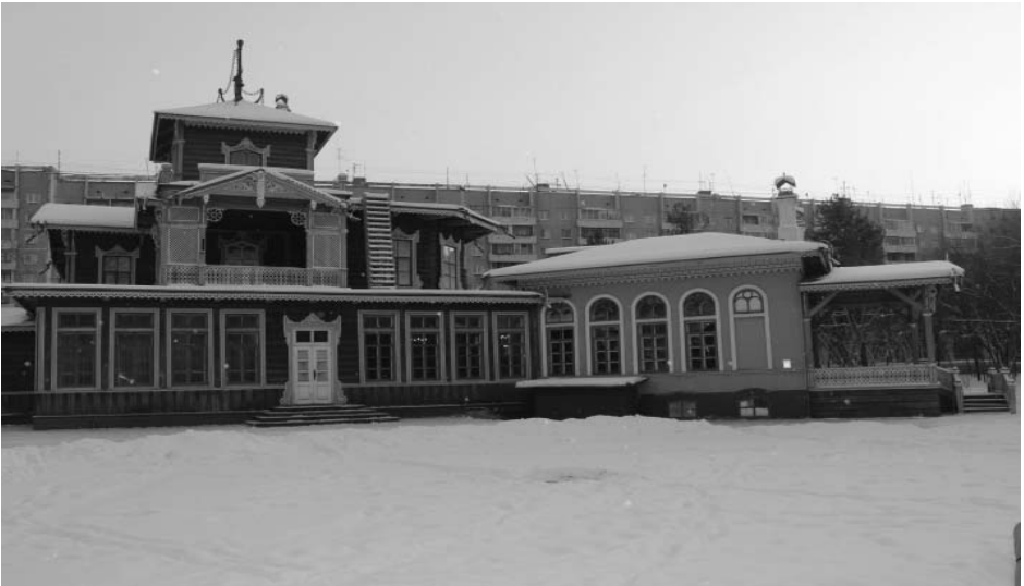
Фото А.А. Жильцов, январь 2018 г. Лит. А. Вид на здание с севера.
