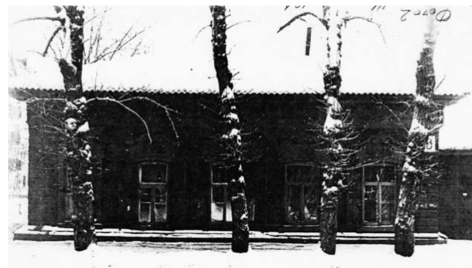
10. Вид на северо-западный фасад здания со стороны улицы Желябова. Автор снимка: Степанов М.Г. Дата съемки: 1983 г.
