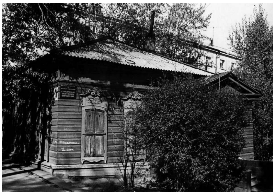
7. Вид на юго-западный фасад здания со стороны въезда в усадьбу. Автор снимка: Степанов М.Г. Дата съемки: 1983 г.
