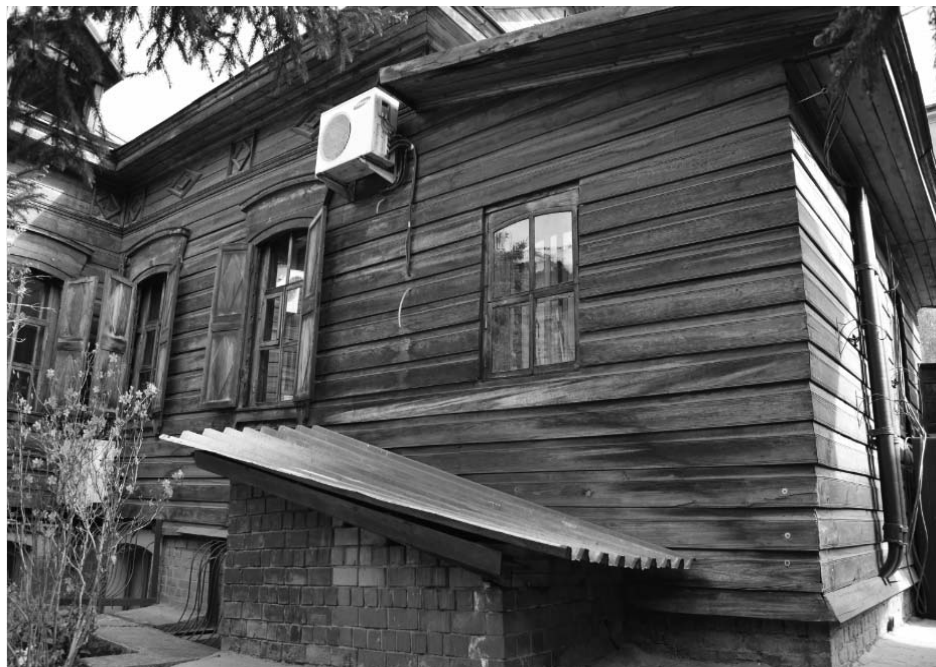
8. Вид на фрагмент юго-восточного фасада здания со стороны двора. Автор снимка: Кравченко В.И. Дата съемки: май 2017 г.
