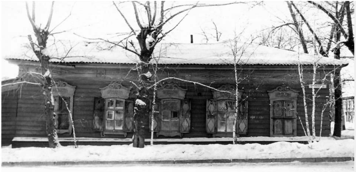
1. Вид на северо-восточный фасад здания со стороны переуллка Пугачева. Автор снимка: Степанов М.Г. Дата съемки: 1983 г.
