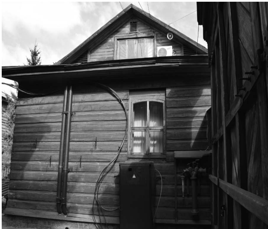
5. Вид на фрагмент юго-восточного фасада здания со стороны двора. Автор снимка: Кравченко В.И. Дата съемки: май 2017 г.
