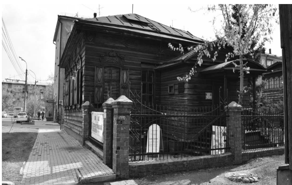
9. Вид на фрагмент юго-восточного фасада здания со стороны въезда на территорию усадьбы. Автор снимка: Кравченко В.И. Дата съемки: май 2017 г.
