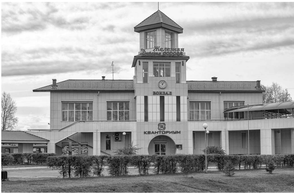
Рисунок 8. Фасадная часть детского технопарка «Кванториум РЖД»
