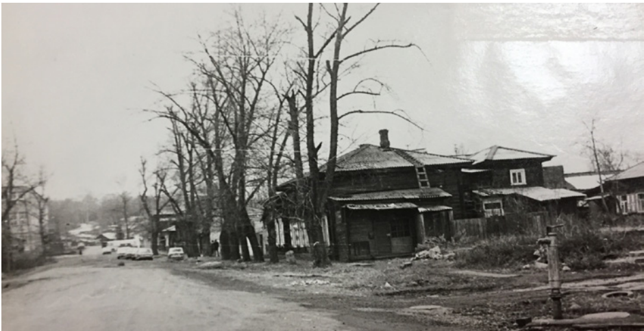
Общий вид на боковой (северо-восточный) фасад с улицы Горной.
