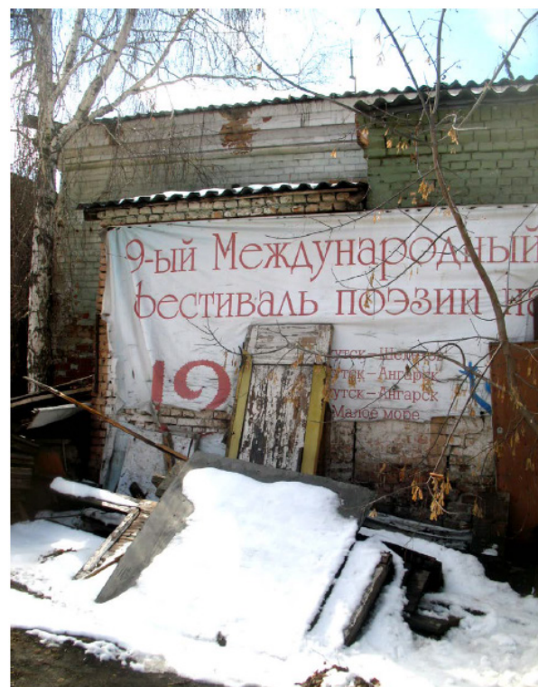
21. Северо-восточный фасад, боковой. Фрагмент.
