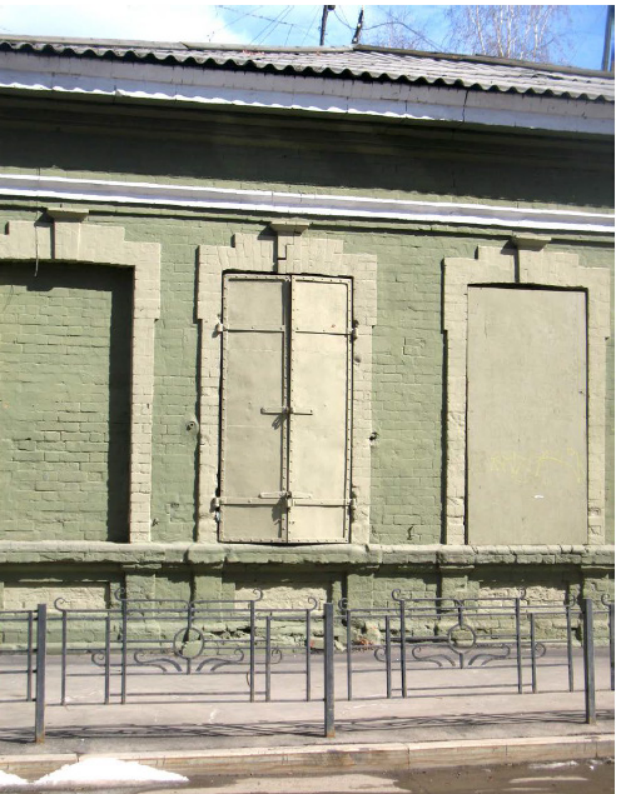
13. Боковой юго-западный фасад, фрагмент. Оконные и подоконные ниши, проемы, наличники, сандрики.
