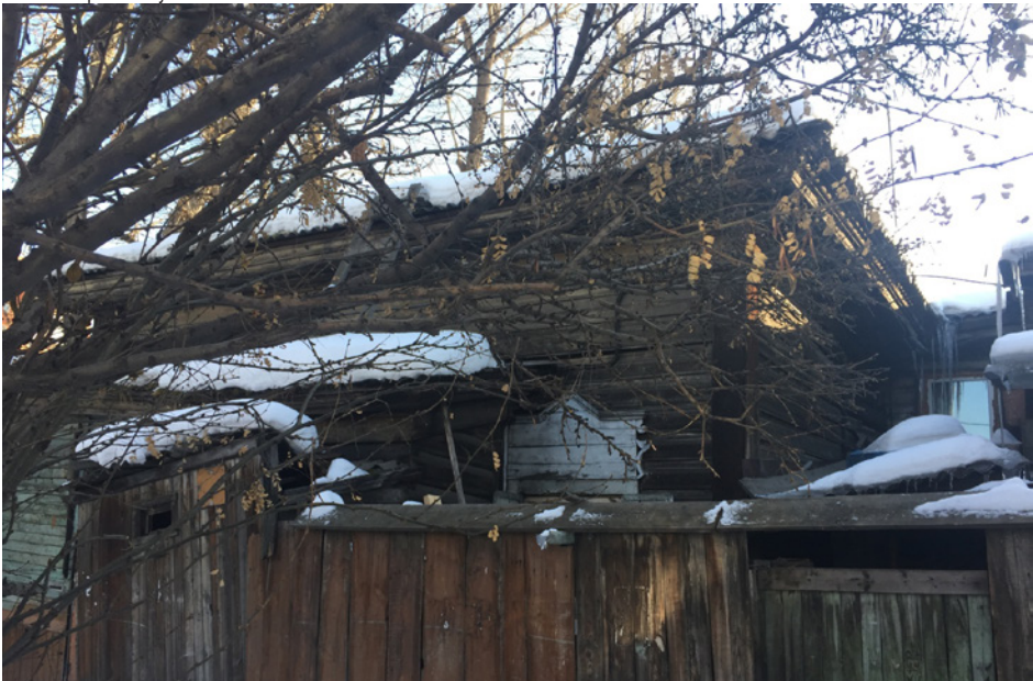
Боковой (северо-восточный) фасад со стороны двора. Пристрой (лит. А2) и пристрой сеней (лит. А1)
