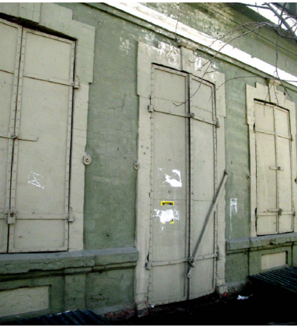
6. Главный, северо-западный фасад по ул. Дзержинского. Фрагмент. Оконные проемы, наличники, сандрики, ставни оконных и дверных проемов. Подоконные пояса и ниши.
