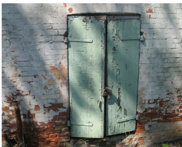
18. Дворовой, юго-восточный фасад. Оконный проем, ставни деревянные
