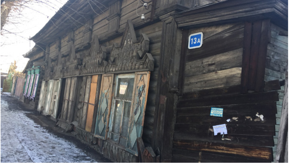
Главный (юго-восточный) фасад.
