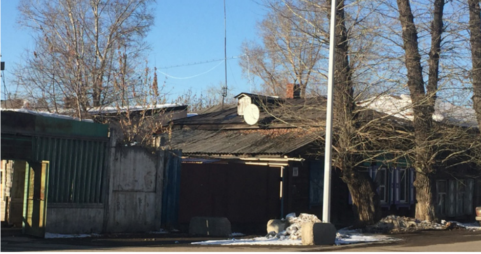
Общий вид с улицы Горной на боковой (юго-западный) фасад.
