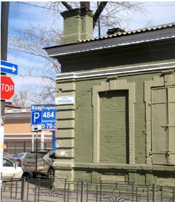
11. Боковой юго-западный фасад, фрагмент. Западная, угловая пилястра. Оконная ниша, подоконные пояса и ниша.
