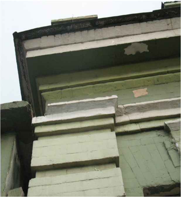
5. Главный северо-западный фасад по ул. Дзержинского. Фрагмент карниза, пилястры.
