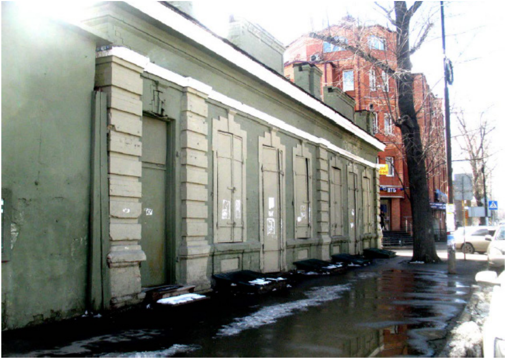
1. Главный северо-западный фасад по ул. Дзержинского.
