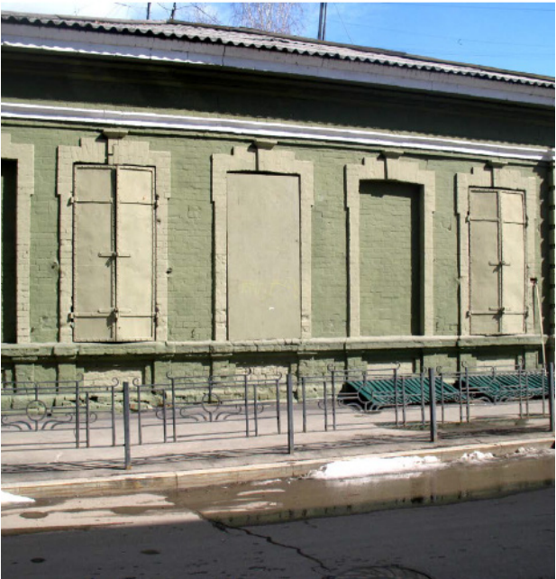
14. Боковой юго-западный фасад по ул. Грязнова. Фрагмент. Карниз, фриз, оконные проемы, ниши, наличники, сандрики, южная (угловая ) пилястра.
