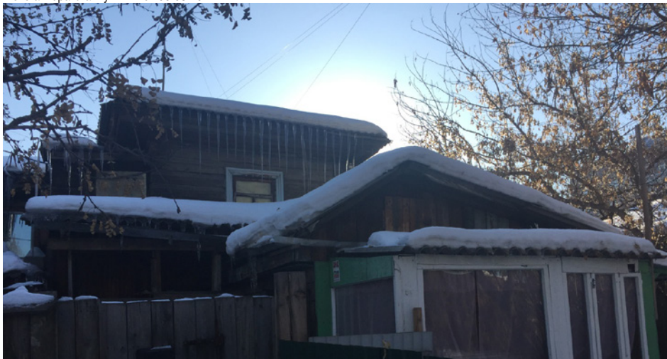
Вид на боковой (северо-восточный) фасад объема (лит. А1) с пристроем (лит. А4) и поздним пристроем (лит. А6).
