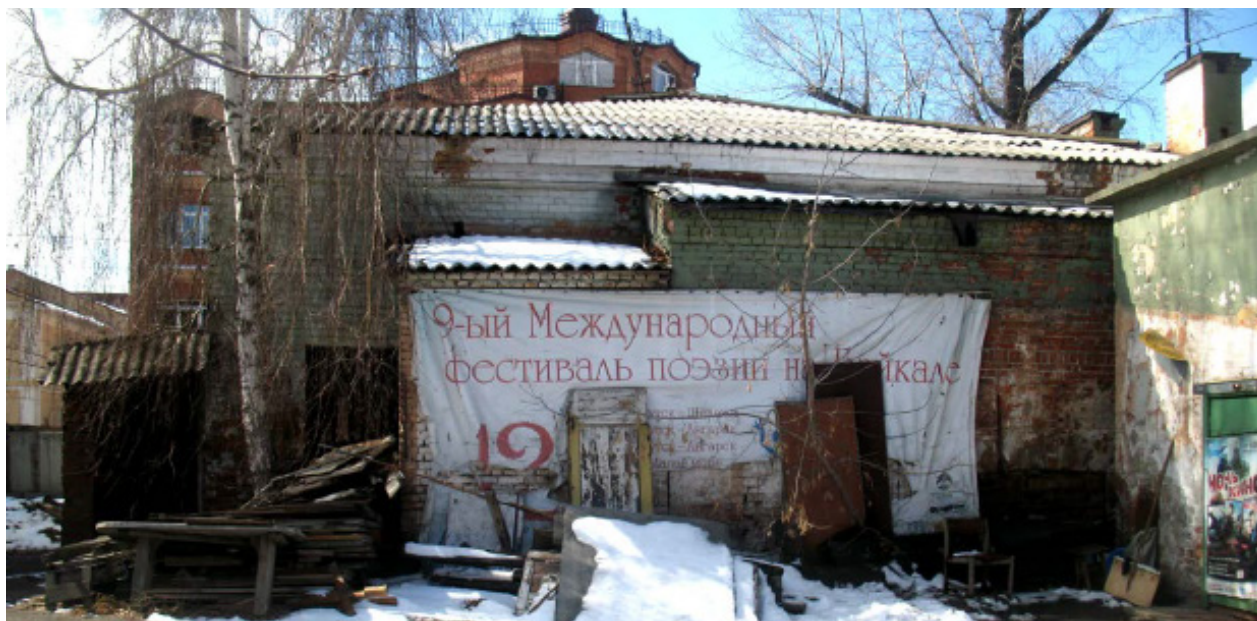
19. Северо-восточный фасад, боковой. Фрагмент.
