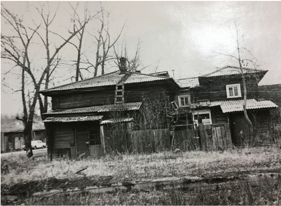
Боковой (северо-восточный) фасад.
