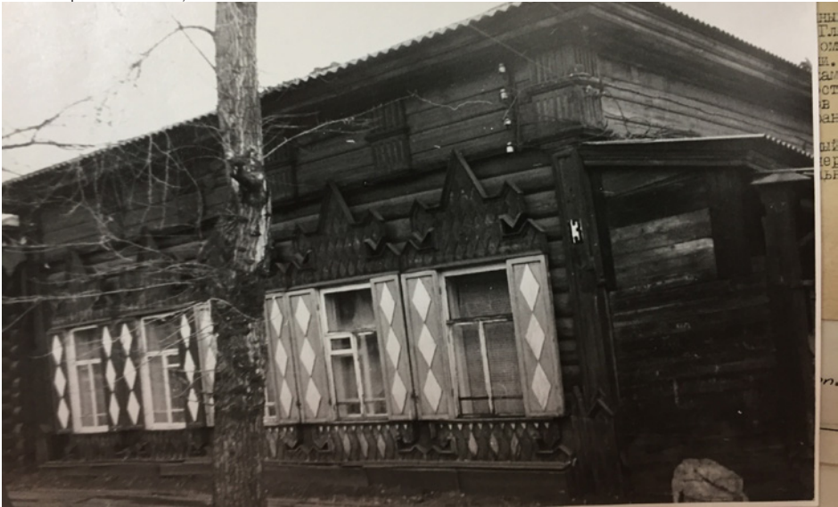
Главный (юго-восточный) фасад.
