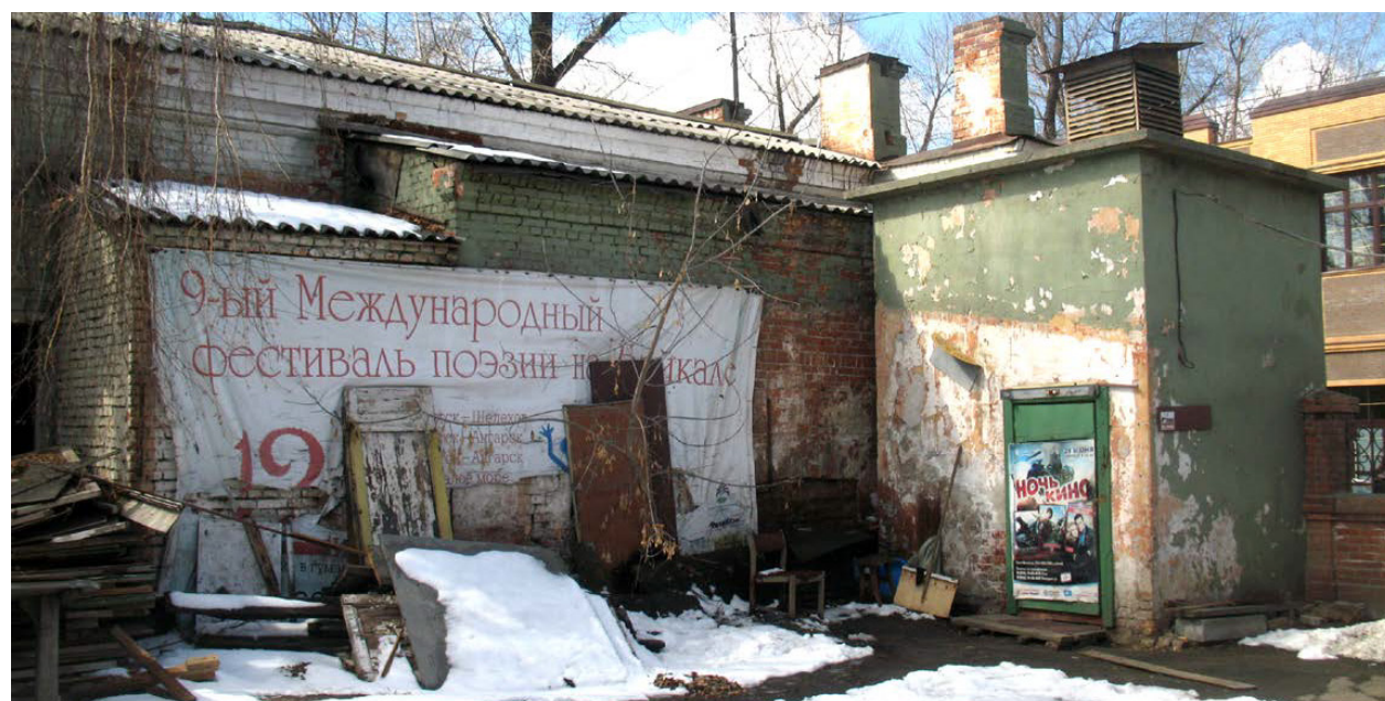
20. Северо-восточный фасад, боковой. Фрагмент.
