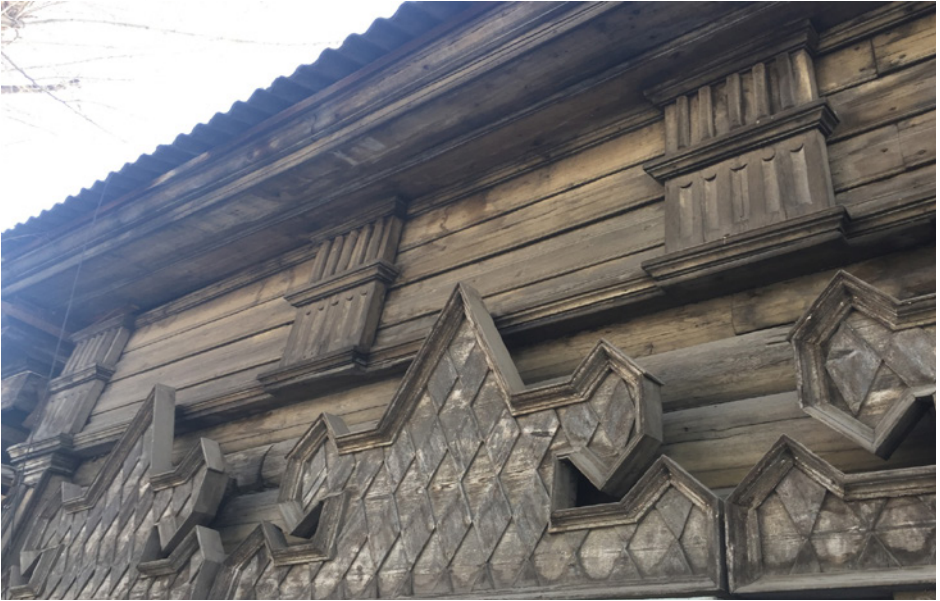
Фрагмент фриза с триглифами и профилированного карниза со стороны главного (юго-восточного) фасада.
