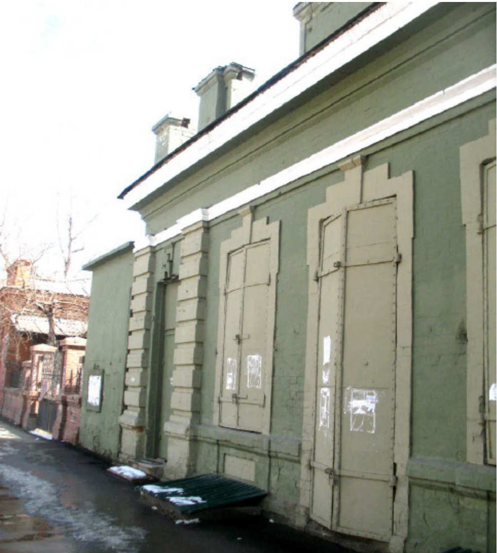
2.Главный северо-западный фасад по ул. Дзержинского. Фрагмент. Оконные проемы и приямки подвала.
