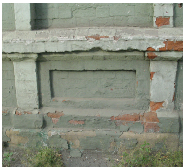
13. Юго-западный фасад по ул. Грязнова. Подоконные поясок, ниши.
