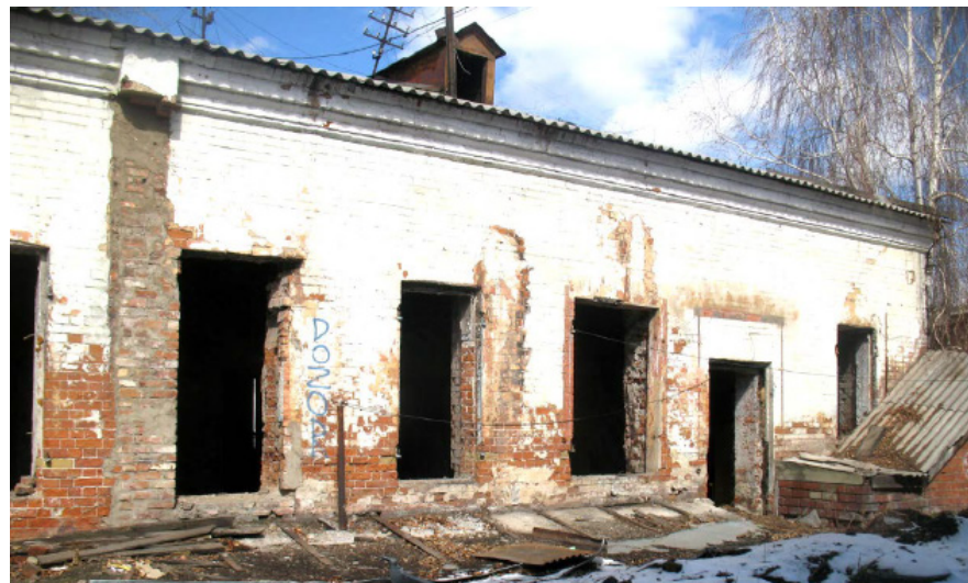
18. Дворовой, юго-восточный фасад. Оконные и дверной проемы.
