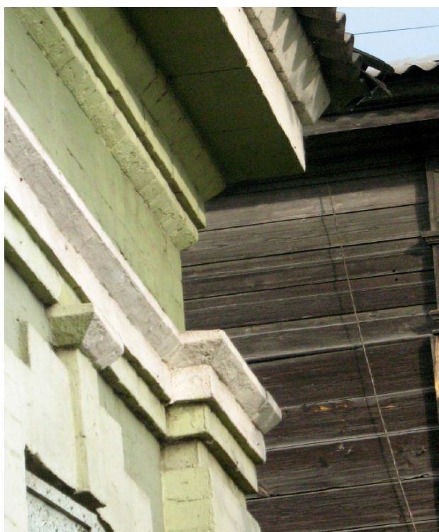
15. Юго-западный фасад по ул. Грязнова. Фрагменты карниза, фриза, сандрика.
