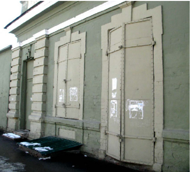
5. Главный, северо-западный фасад по ул. Дзержинского. Фрагмент, главный вход. Оконные проемы, наличники, сандрики, ставни оконных и дверных проемов.
