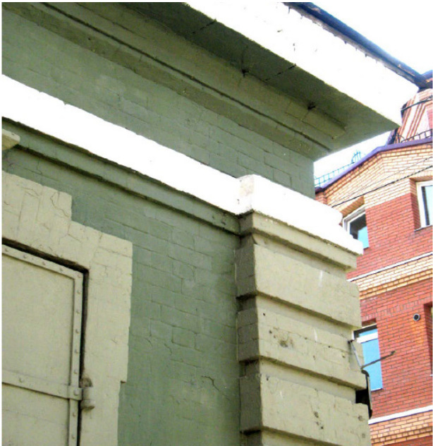
7. Главный, северо-западный фасад по ул. Дзержинского. Фрагмент карниза, фриза, пилястры.
