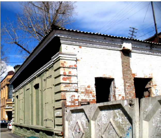
9. Вид с юга. Боковой юго-западный фасад. Фрагмент юго-восточного, дворового фасада.
