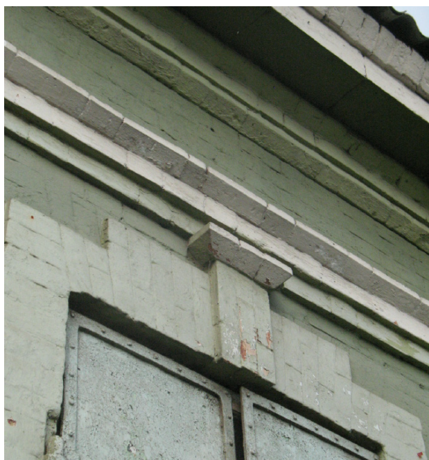
14. Главный северо-западный фасад по ул. Дзержинского. Фрагмент Оконный проем, сандрик, ставни.
