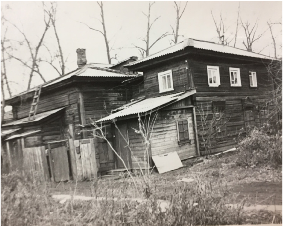
Дворовый (северо-западный) фасад.
