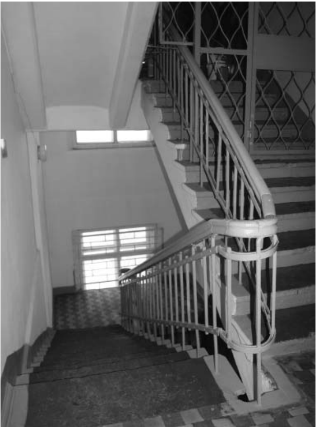
Лестница с ограждением.
