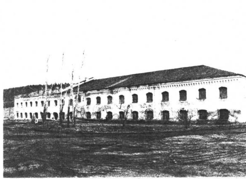
Юго-западный фасад здания. Вид со стороны двора.
