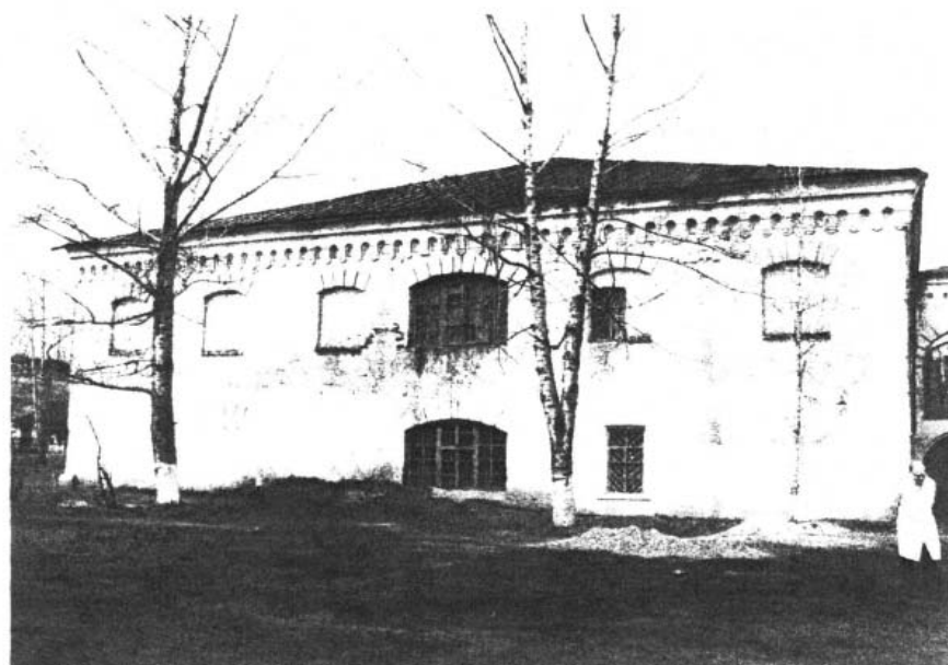
Фрагмент Юго-западного фасада. Торцевой фасад прямоугольного корпуса.
