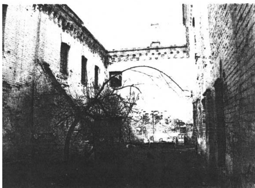
Внутренний открытый коридор, вид с юго-восточной стороны.
