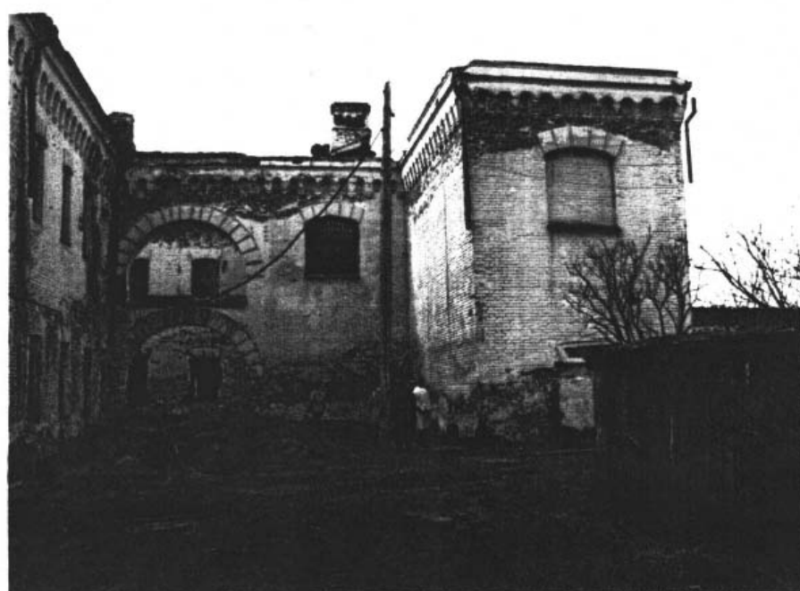
Фрагмент Северо-восточного фасада, компоновочное расположение корпусов здания образуют коридор, ведущий во внутренний дворик.
