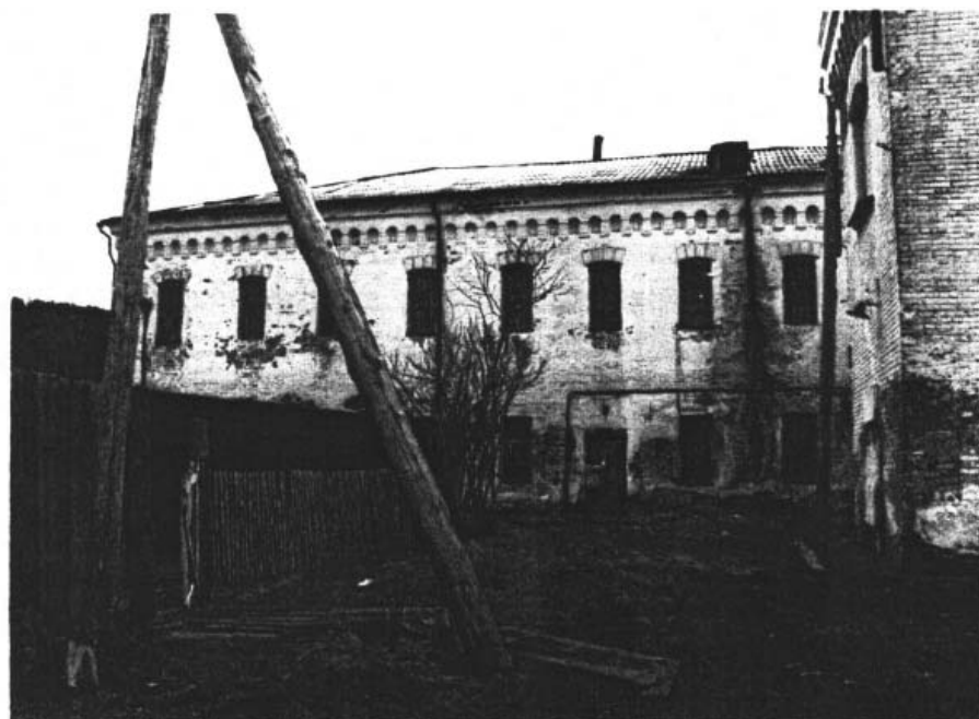
Фрагмент Северо-западного фасада, основной, П-образный корпус здания.
