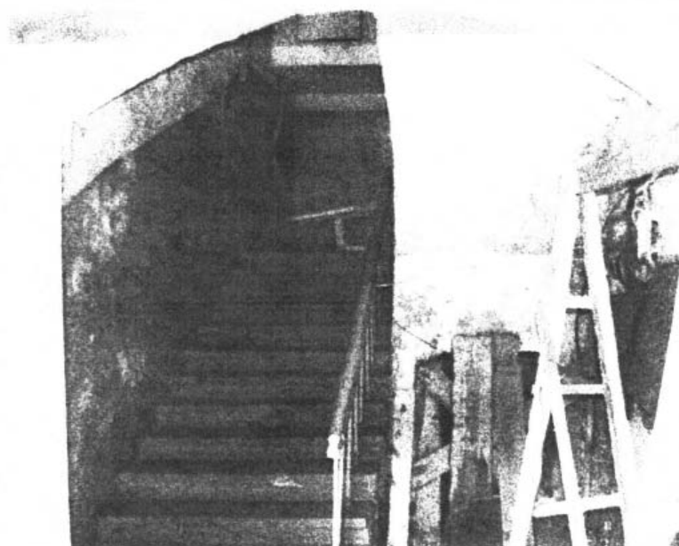
Интерьер. П-образный, северо-восточный корпус. Лестница на второй этаж.
