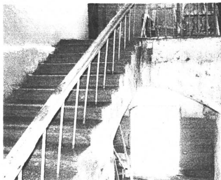
Интерьер. П-образный, северо-восточный корпус. Лестница на второй этаж. вид с межуэтажной площадки.
