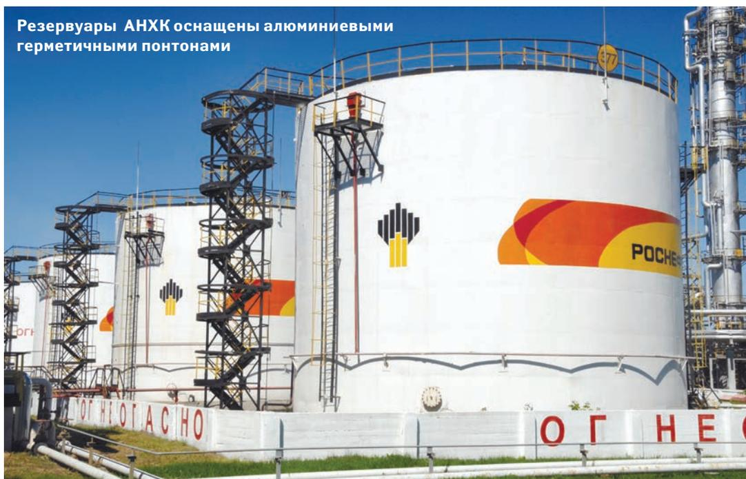
Резервуары АНХК оснащены алюминиевыми герметичными понтонами
