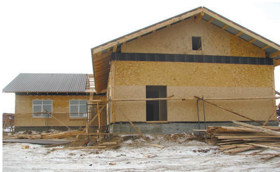
Строящийся детсад в Грановщине
